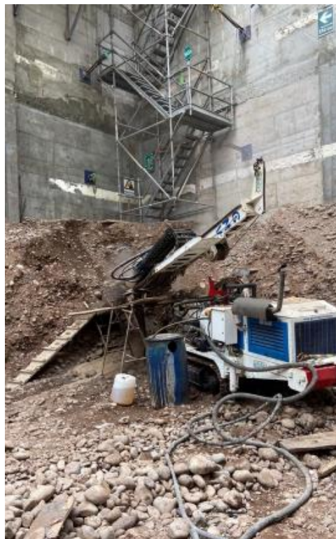
Figura 51. Perforación para anclaje
