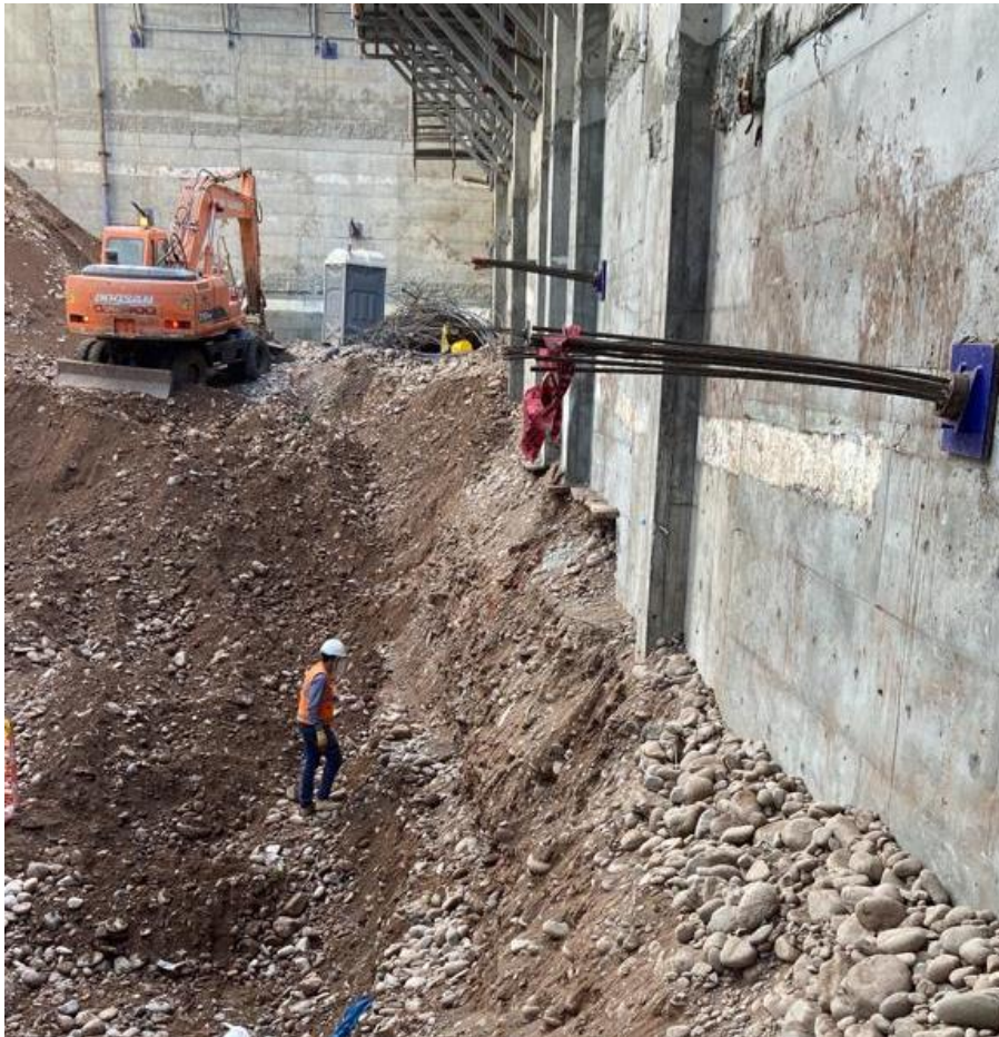
Figura 17. Banqueta con la corona < 1m
