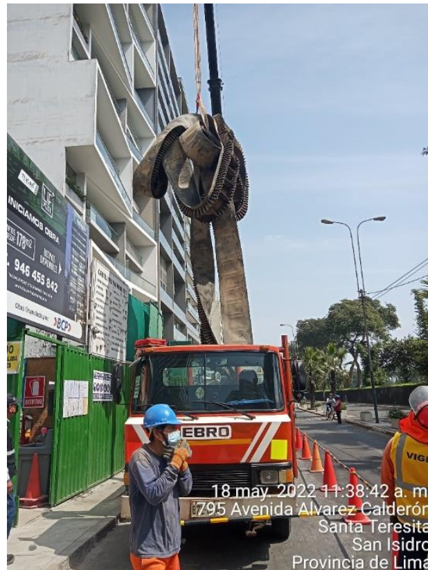
Figura 19. Llegada de equipos y materiales a obra
