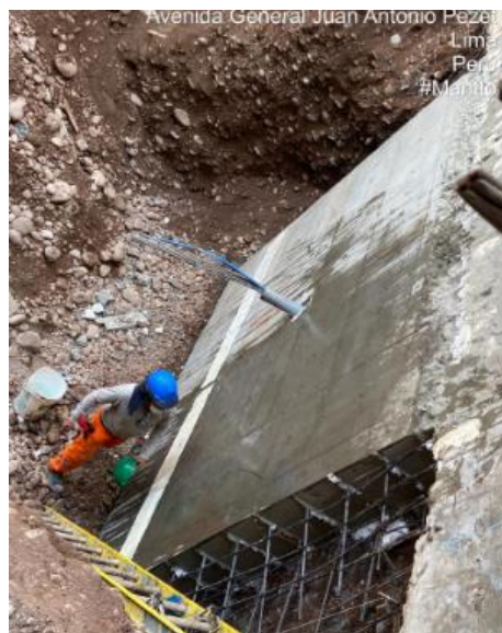
Figura 70. Curado de Muro
