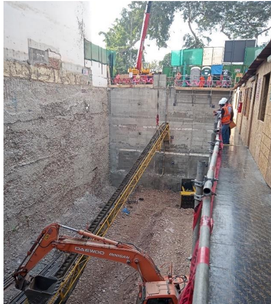
Figura 30. Posicionamiento de faja transportadora
