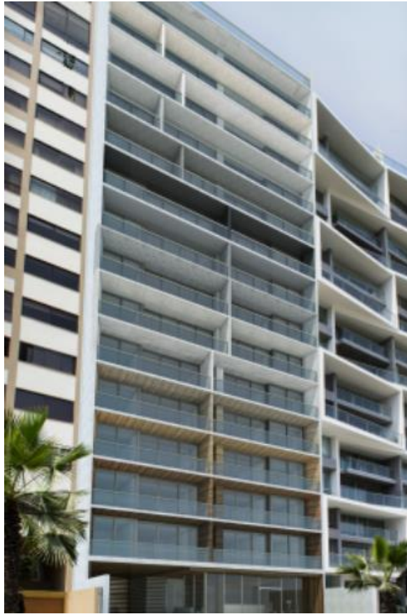
Figura 3. Fachada Principal del Edificio Residencial Lif Pezet
