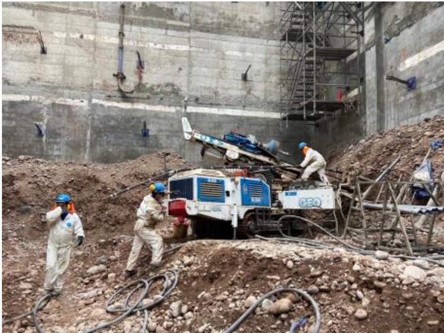
Figura 52. Colocación de torones
