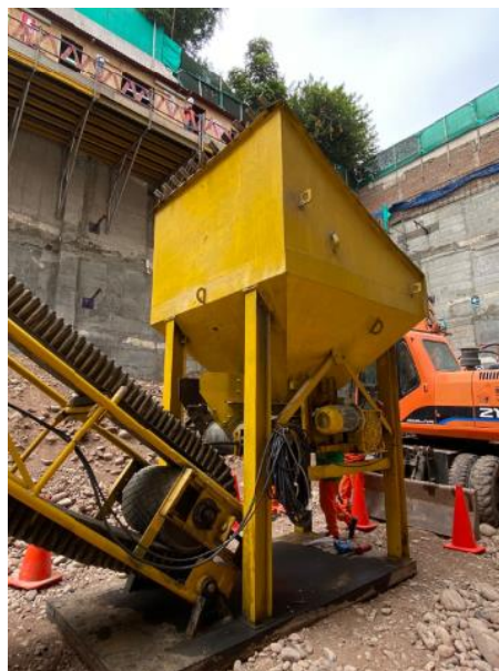
Figura 33. Colocación de tolva
