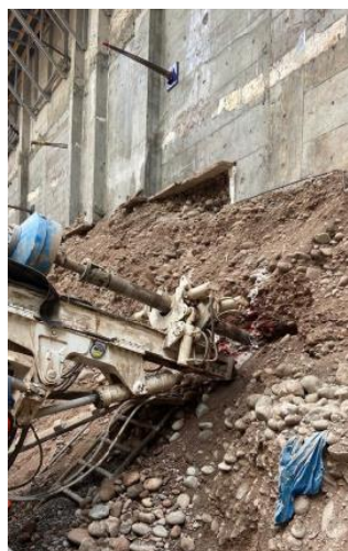
Figura 48. Alineación de inyector en el trazo
