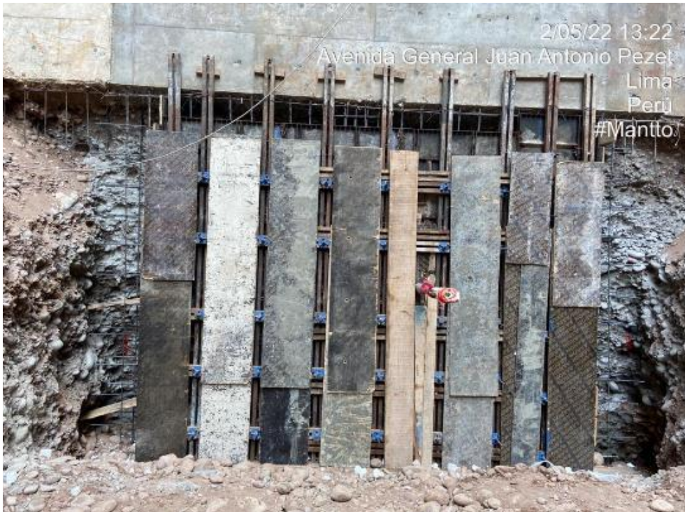
Figura 64. Encofrado de Muro
