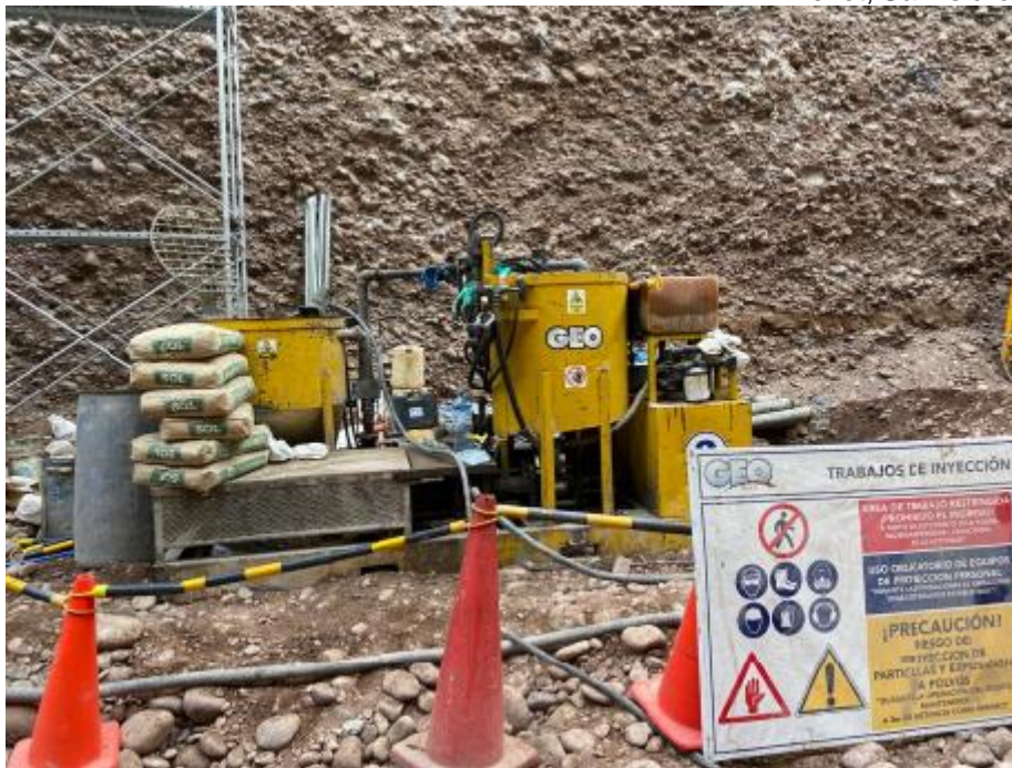
Figura 53. Equipo para preparar lechada
