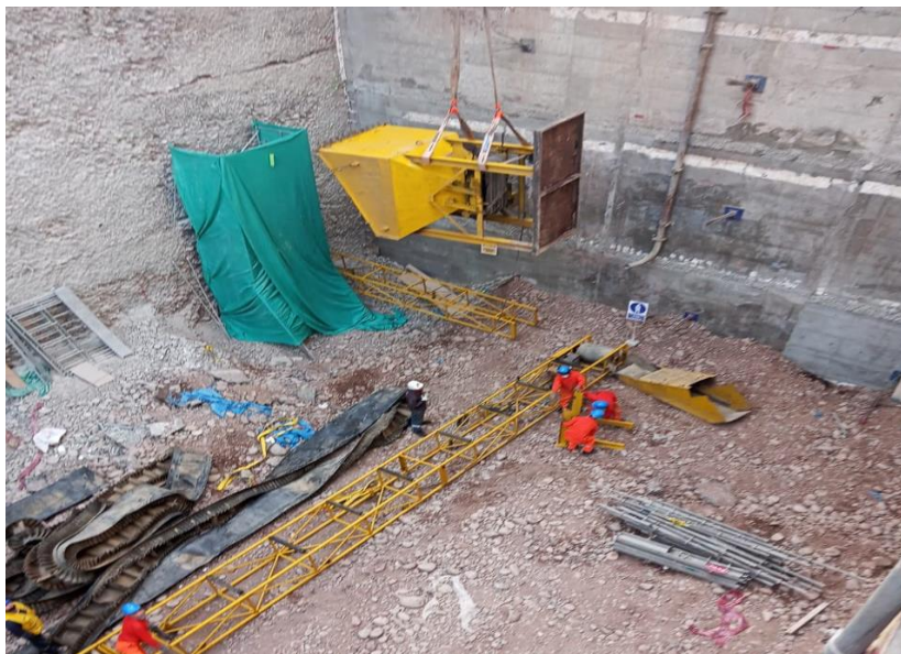
Figura 21. Llegada de equipos y materiales a obra
