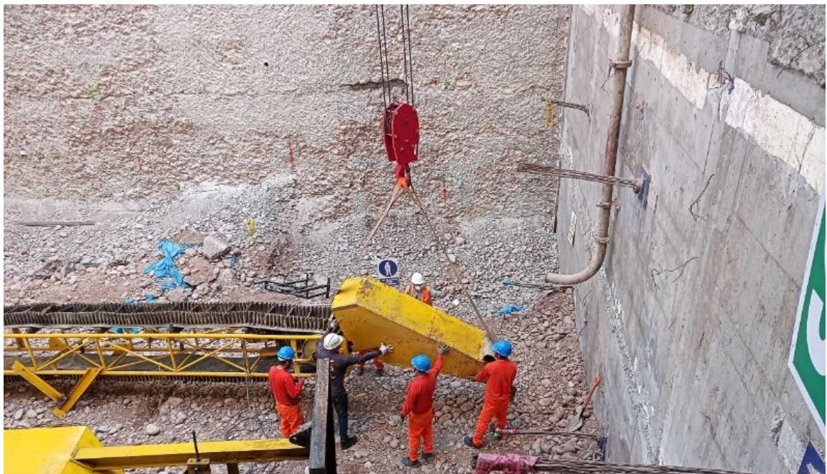
Figura 27. Izaje del cabezal con ayuda de grúa telescópica
