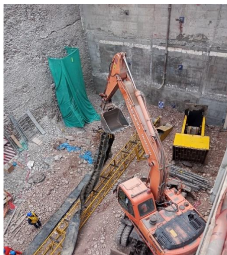
Figura 24. Colocación de lona o faja con ayuda de la excavadora
