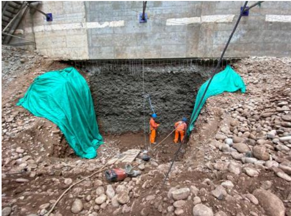
Figura 59. Pañeteo con lechada
