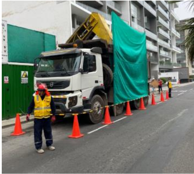
Figura 43. Volquete lleno de material para su retiro de obra
