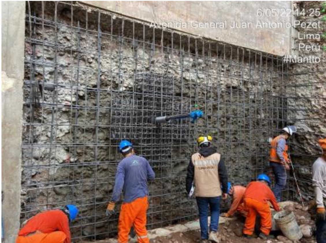
Figura 60. Colocación de acero
