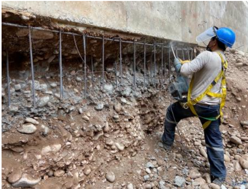
Figura 57. Picado/Limpieza de fondo inferior de muro
