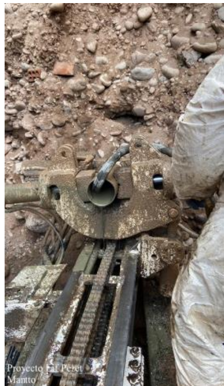
Figura 54. Llenado de lechada al bulbo
