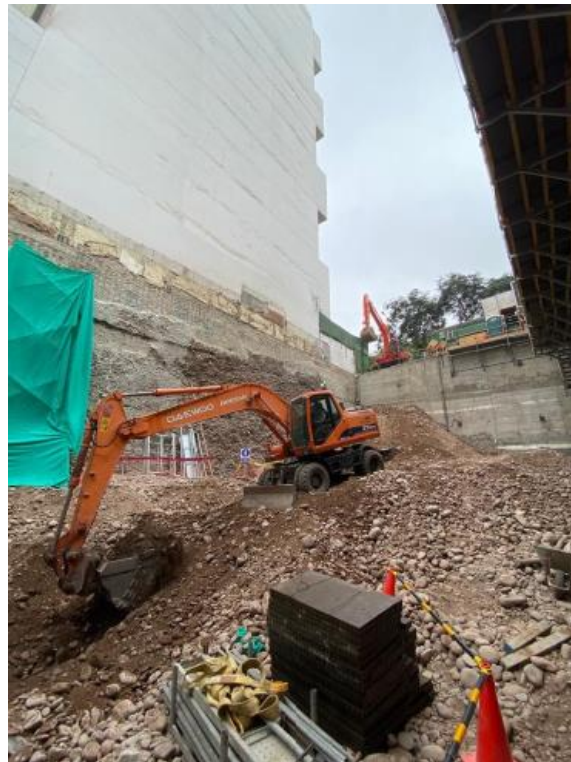
Figura 14. Eliminación masiva: primer método - pasamanos
