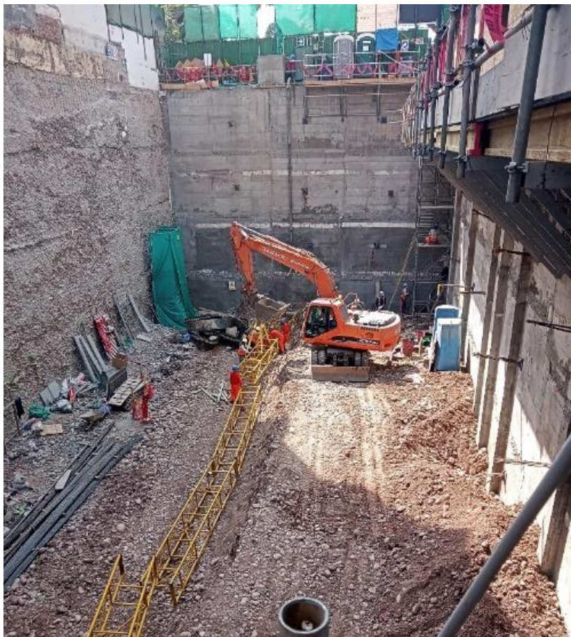
Figura 22. Posicionamiento de cuerpos para armado de castillo
