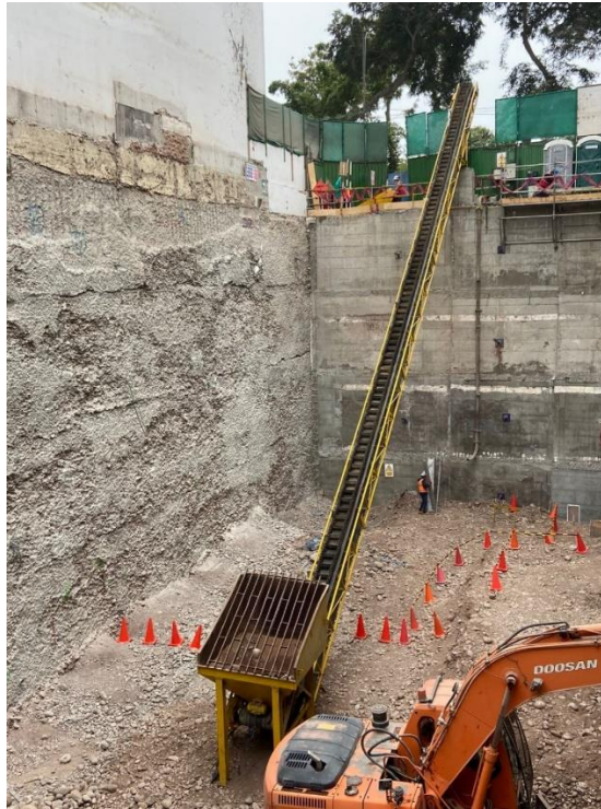
Figura 40. Llenado de la tolva con ayuda de la excavadora
