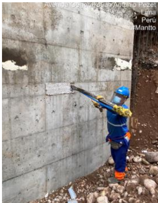
Figura 71. Preparación de Muro para colocación de gato hidráulico
