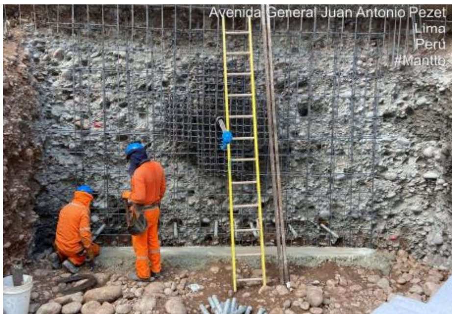
Figura 62. Colocación de solado
