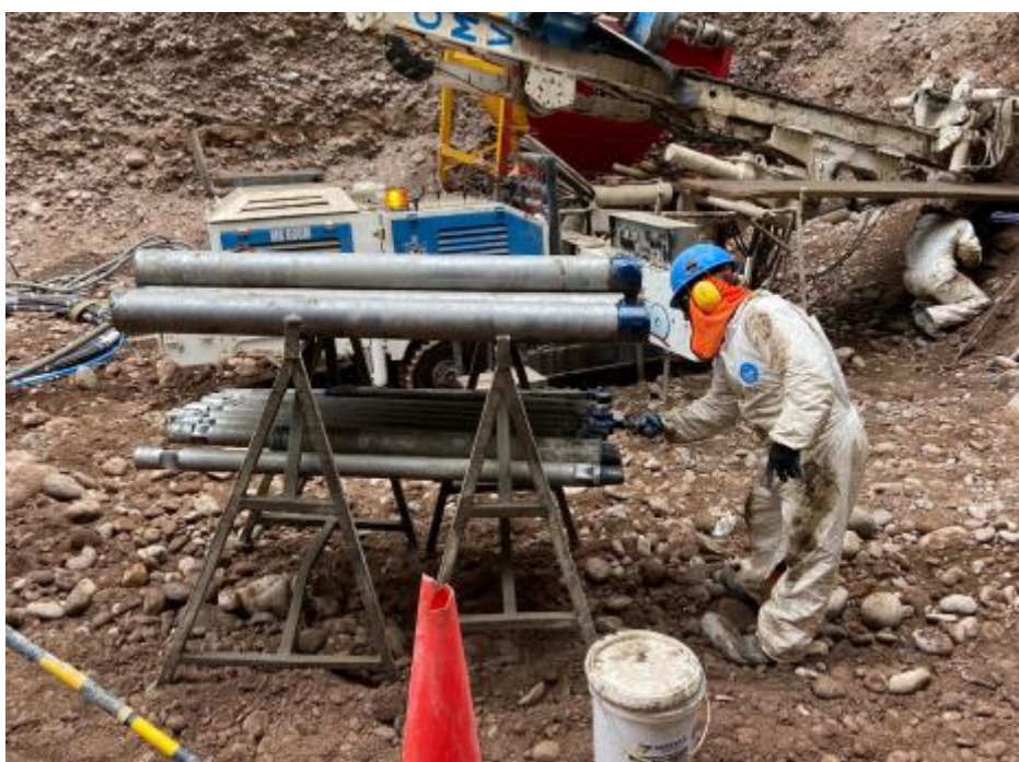
Figura 49. Engrasado de tubos de perforación
