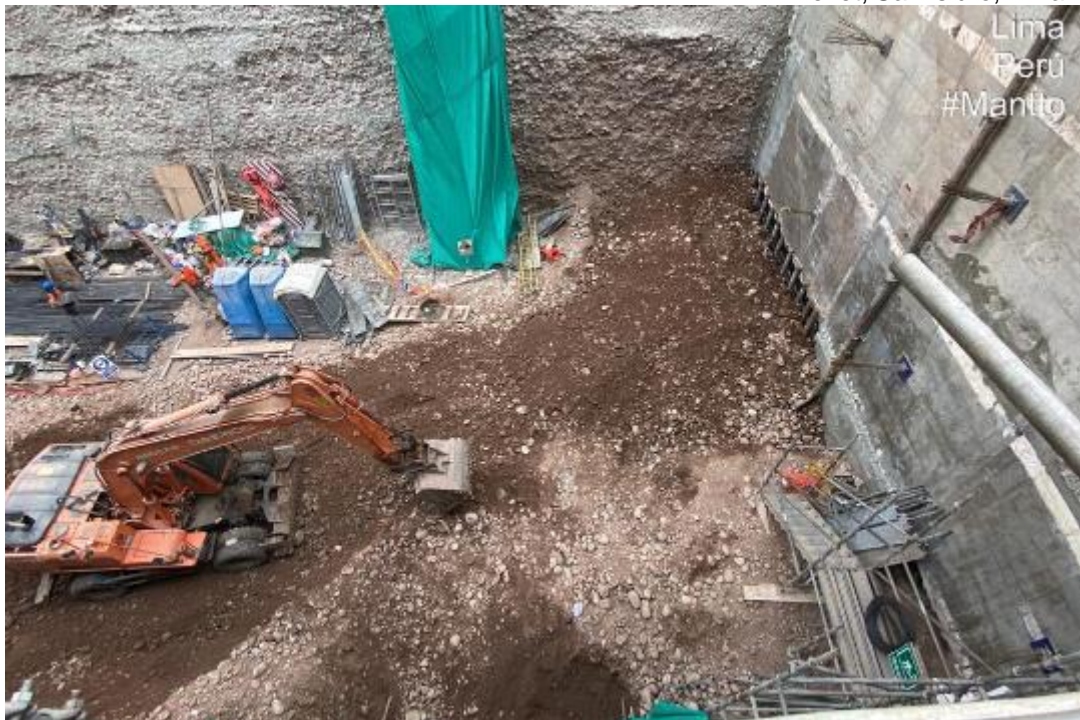
Figura 65. Entierro de muro “Pachamanca”
