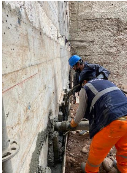
Figura 69. Vaciado de muro
