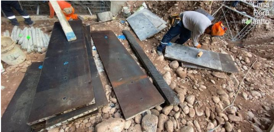
Figura 61. Colocación de desmoldante a encofrado
