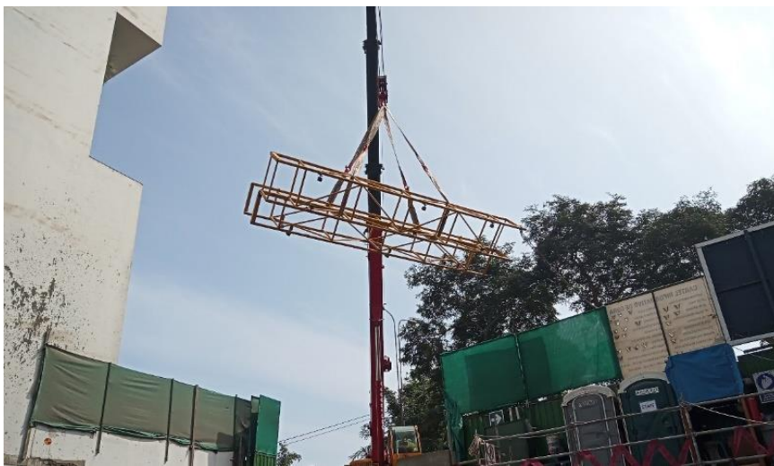
Figura 20. Llegada de equipos y materiales a obra
