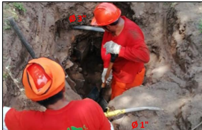
Vista fotográfica de calicata N° 01 ejecutada.
