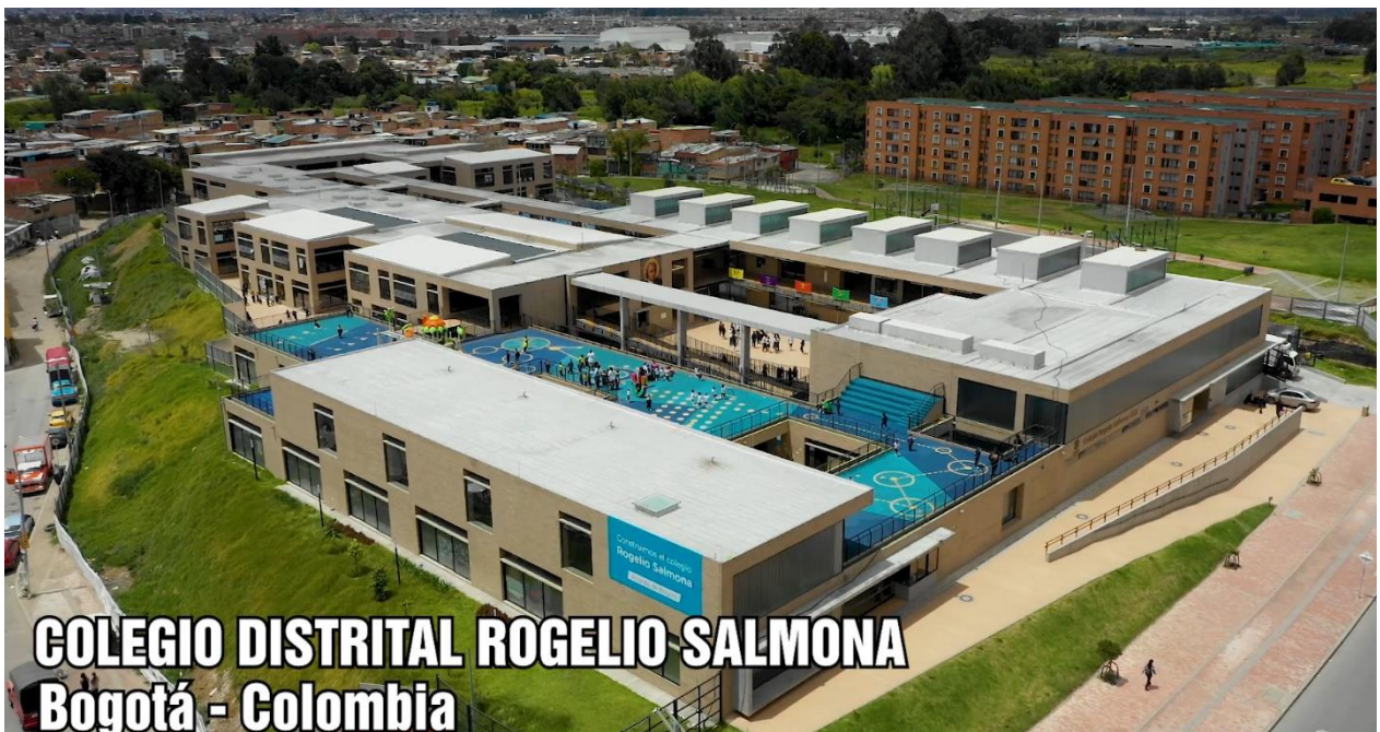
Figura 17 Vista aérea del caso 05 – Colegio Distrital Rogelio Salmona
