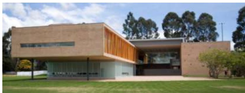
Figura 3: Fachada Colegio Los Nogales
