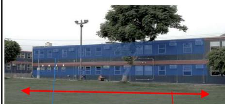
Por se módulos de contenedores estos están ensamblados paralelamente uno con otros, con la intención de ampliar el espacio educativo y ensamblados por gravedad (verticalmente) generando un segundo piso.
