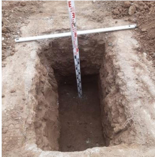
Figura 22. Identificación del tipo de suelos y posibles interferencias dentro de la traza a excavar en las calicatas.
