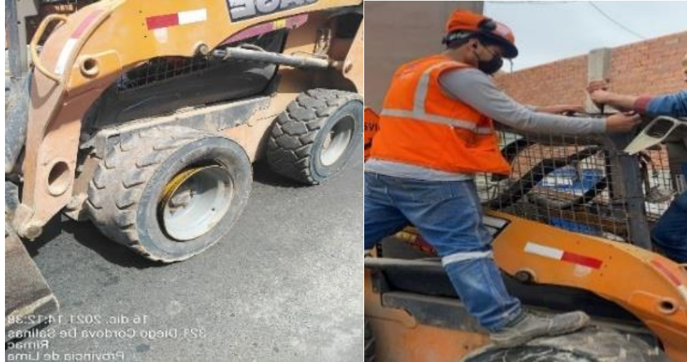
Figura 1: Retraso en el proceso de excavación por fallas en los Minicargadores.
