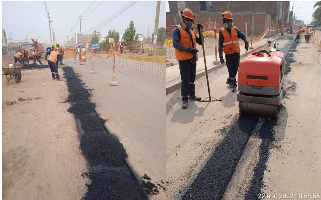
Figura 31: Reposición de Asfalto.
