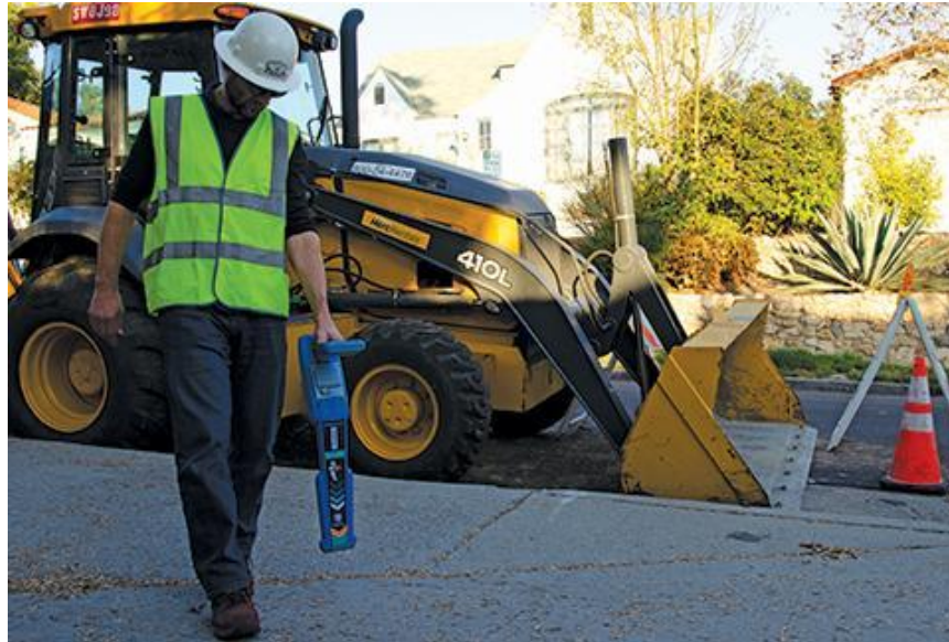
Figura 21: Paso del Radiodetección
