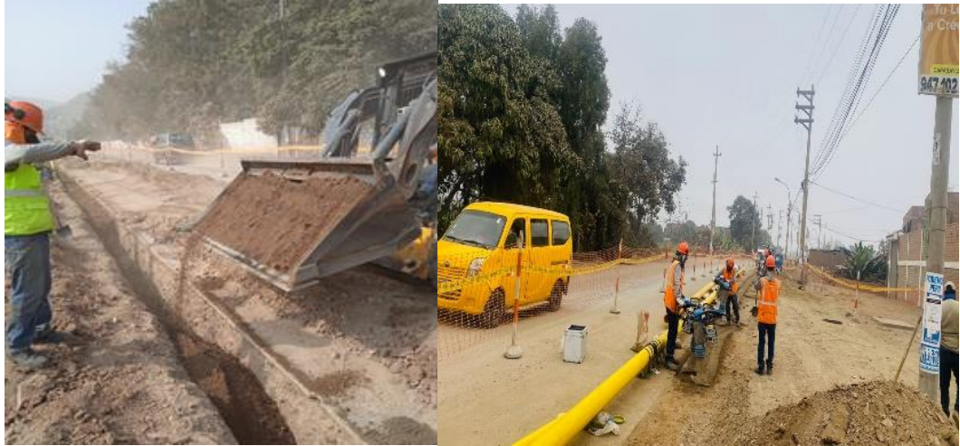
Figura 29: Proceso de compactación
