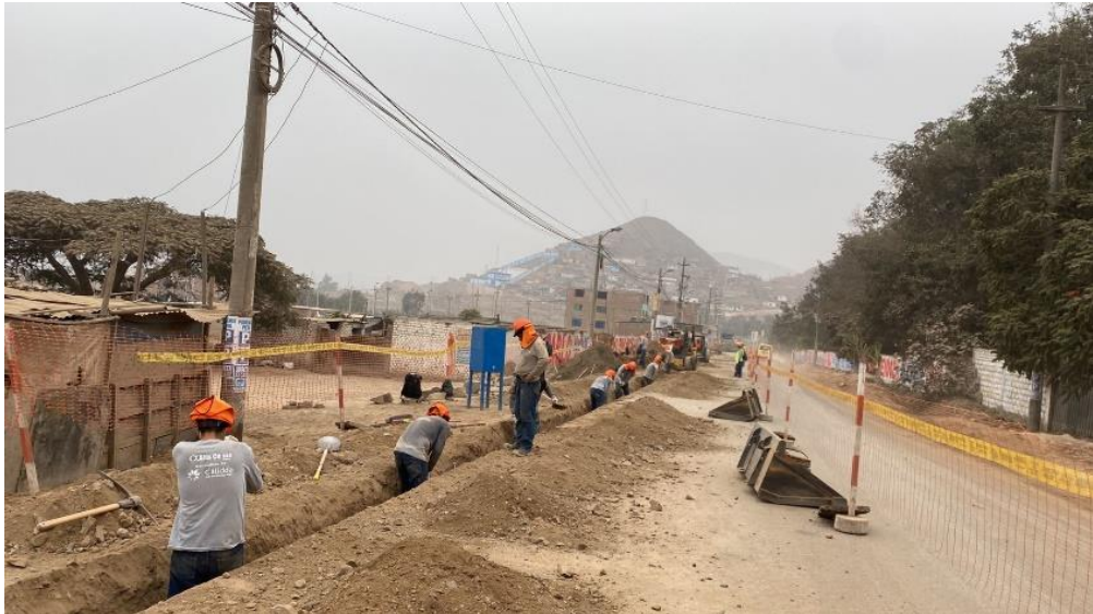
Figura 25: Proceso de excavación manual.
