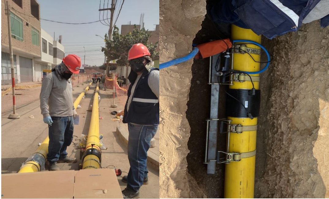
Figura 27: Soldadura de polietileno.
