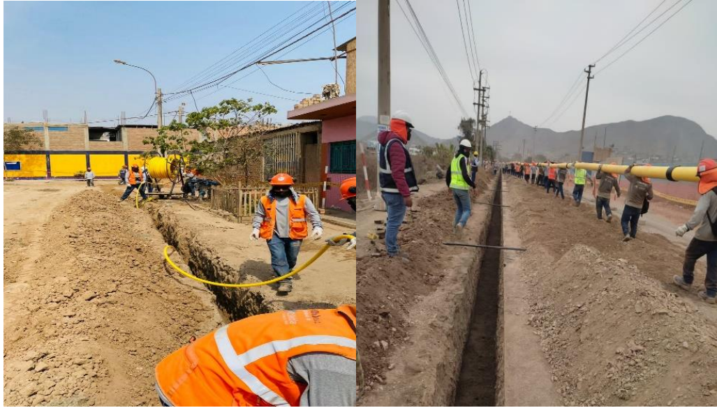
Figura 26: Tendido de la tubería de polietileno.
