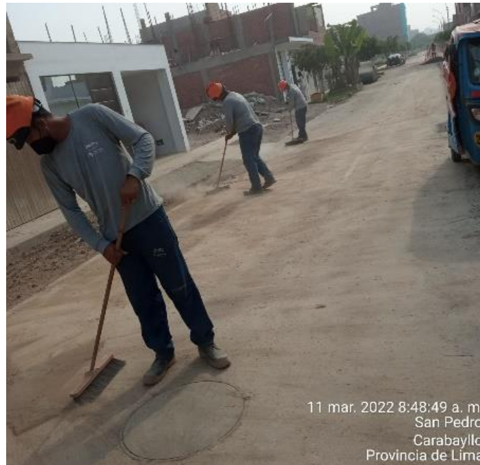
Figura 32: Limpieza de Obra.
