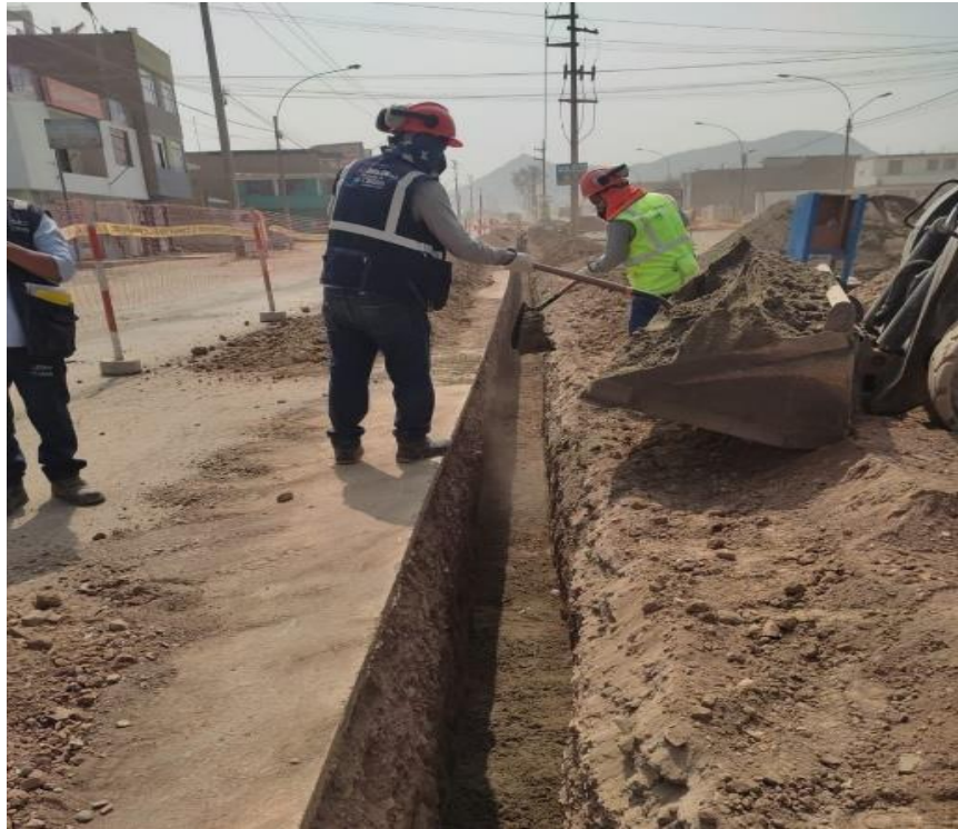
Figura 28: Tapado de tubería de polietileno con arena fina.
