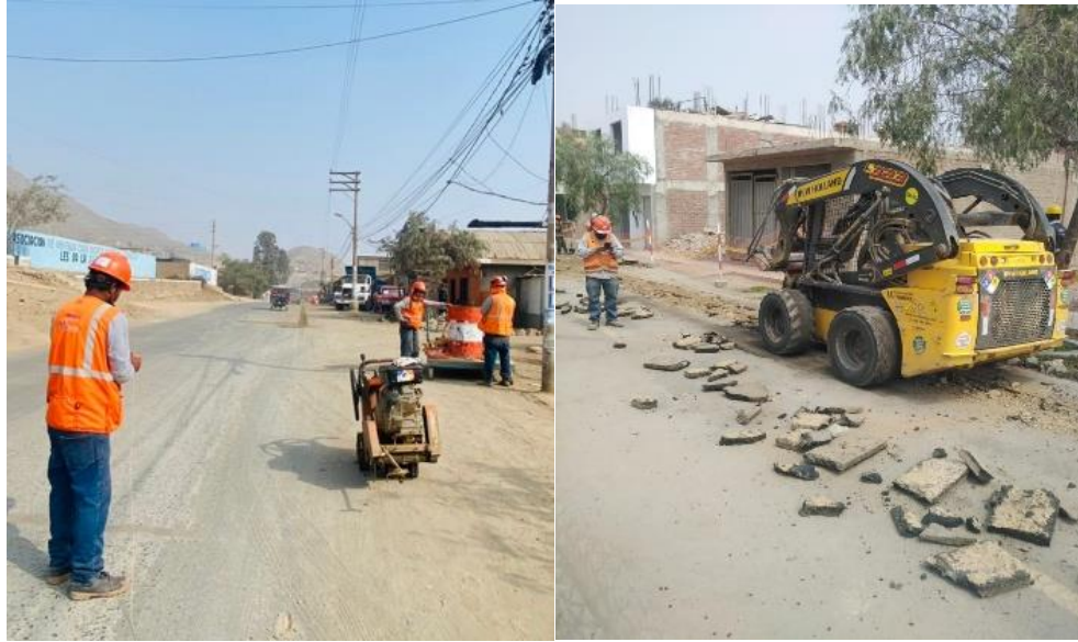
Figura 23: Proceso de corte y rotura de pavimento.
