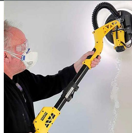
LIJADO DE PAREDES
