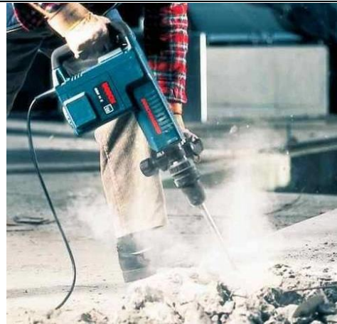
PERFORACIÓN, CORTE O PICADO DE CONCRETO
