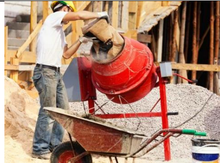
PREPARACIÓN Y MEZCLADO DE CONCRETO
