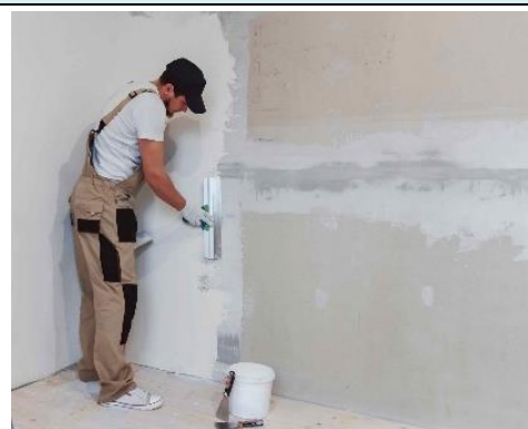
PREPARACIÓN Y COLOCACION DE YESO
