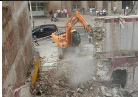
DEMOLICIÓN DE ESTRUCTURAS
