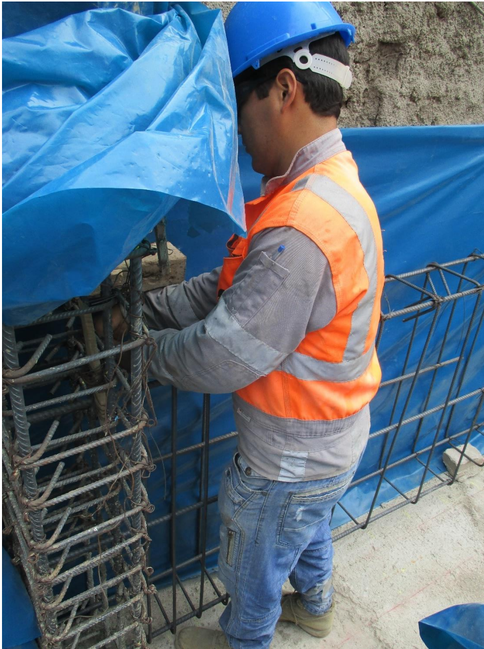
Anexo N° 4: Fotografía del Habilitado de acero en Viga Cimentación.
