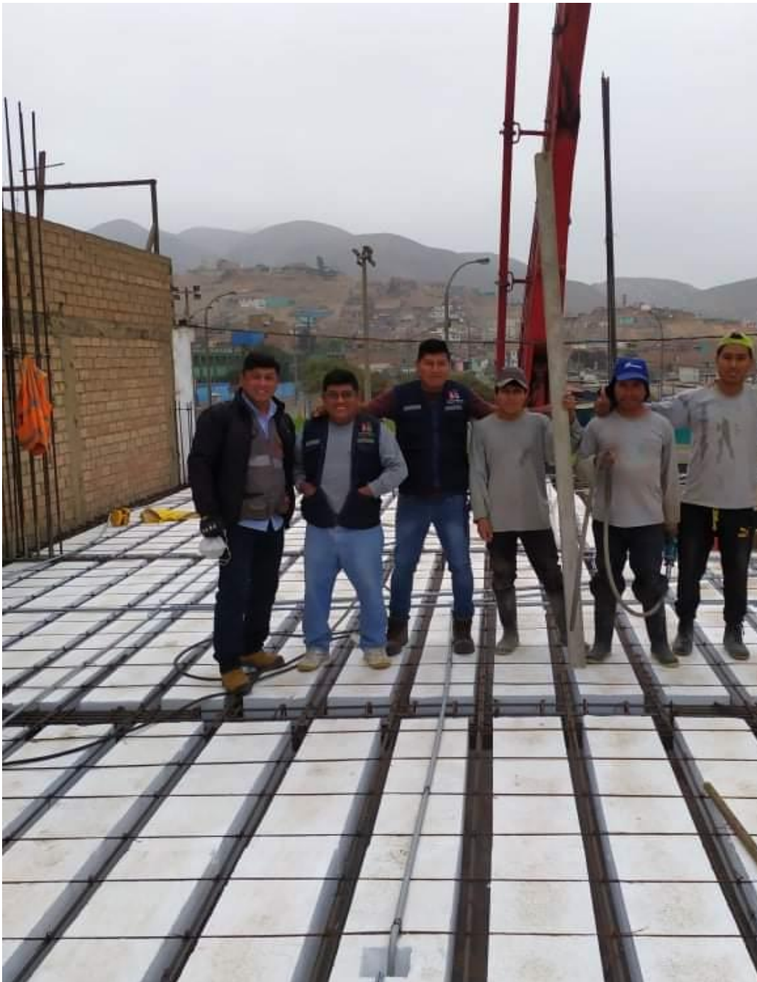
Anexo N° 5: Fotografía Etapa de Colocación de Concreto en Losa Aligerada.
