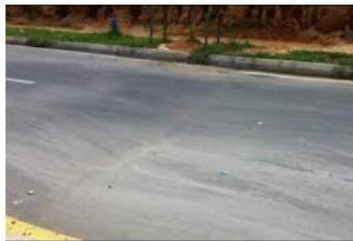
*Figura 5:* Hundimiento Transversal
