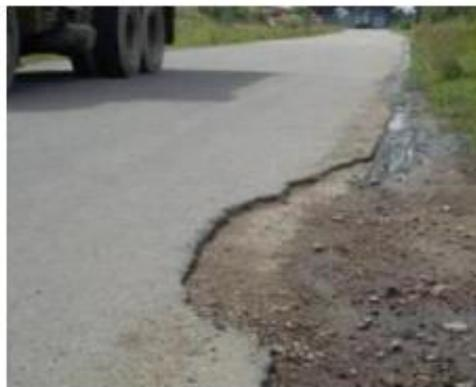
*Figura 11:* Desintegración de Bordes de Pavimento
