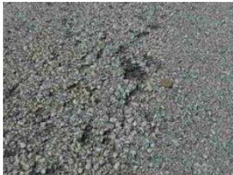
*Figura 10:* Pulimiento de Agregado
