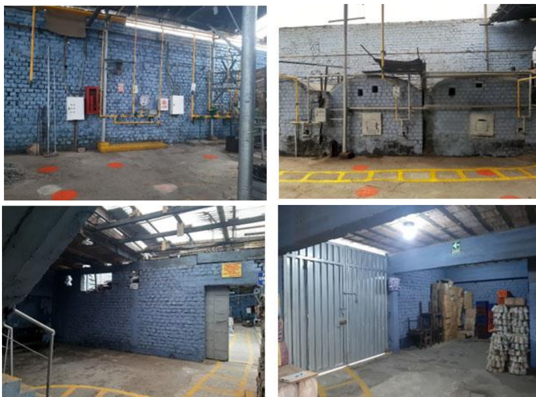
Figura 9: Limpieza de las áreas de trabajo
