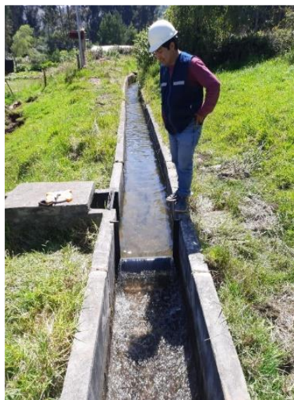
Ilustración 8: Nivelación de flujo para cada vertedero.
