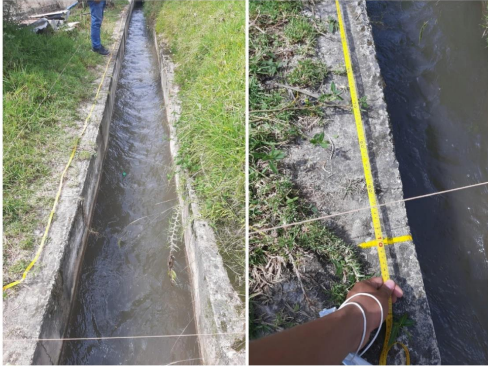
Toma de datos en campo por el método flotador. (KM-05+000)
