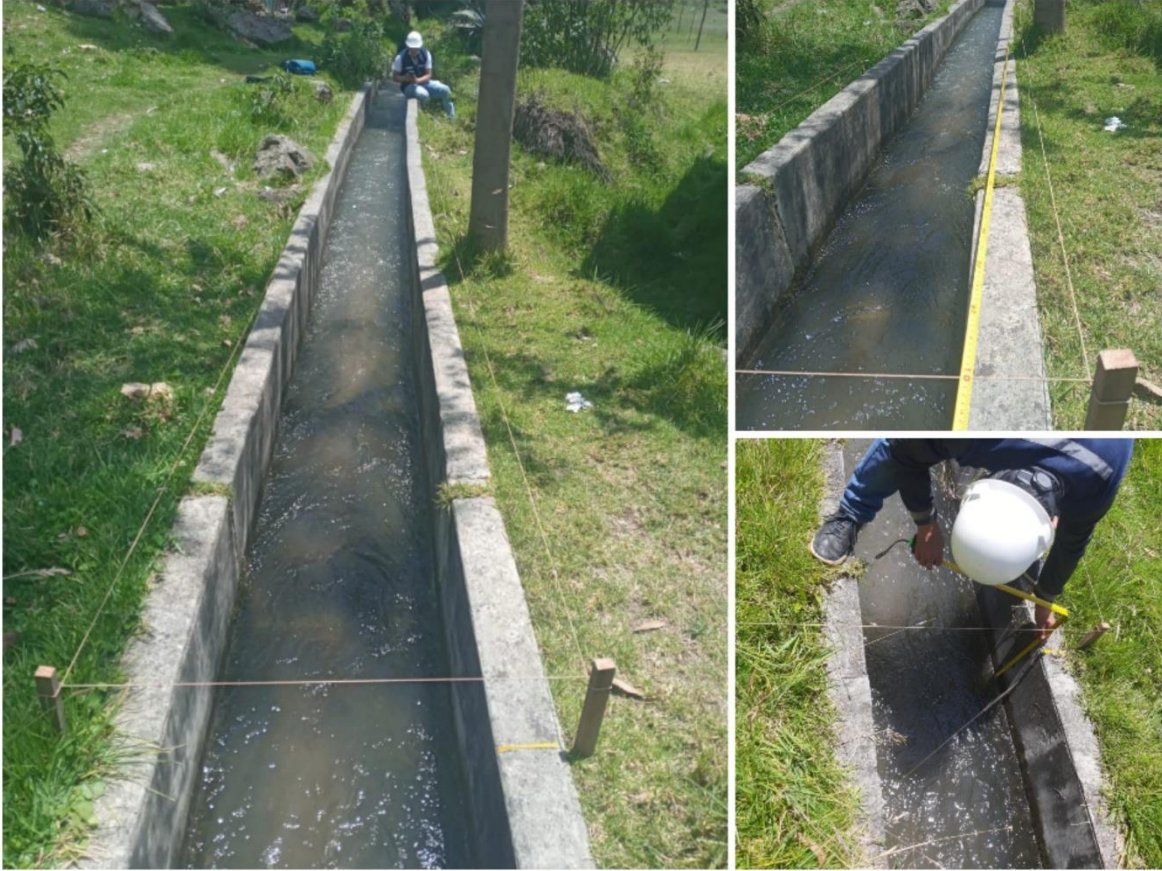
Toma de datos en campo por el método flotador. (KM-02+000)
