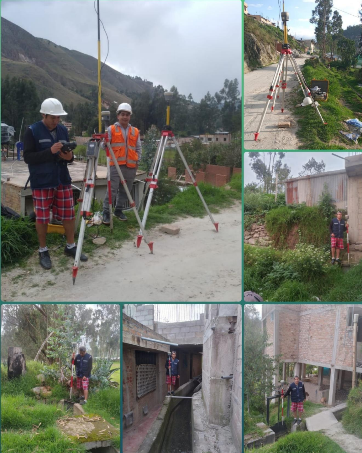
Levantamiento topográfico con GPS Diferencial R10. KM-(00+000 AL 05+000)
