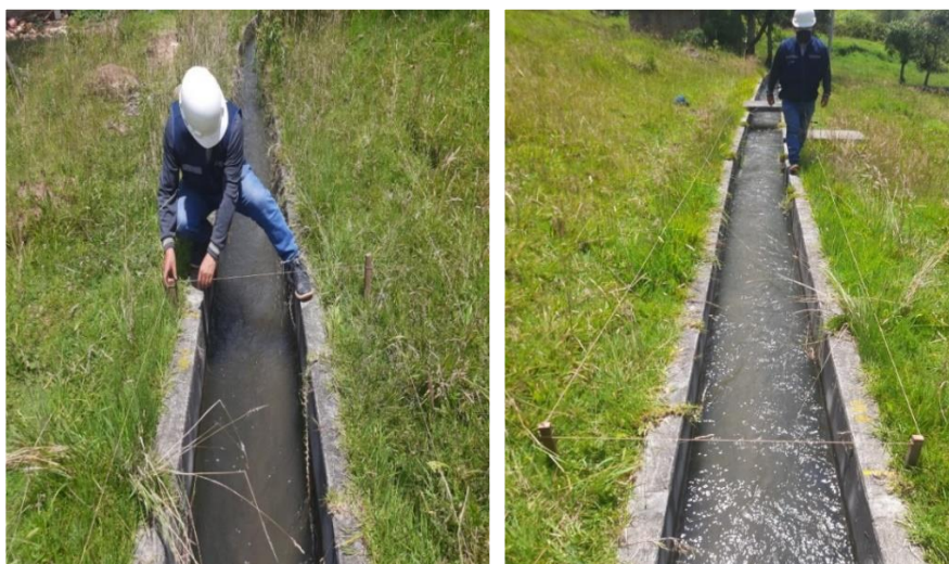
Ilustración 2, 3: Colocación de estacas y delimitación en tramos de 10 m.
