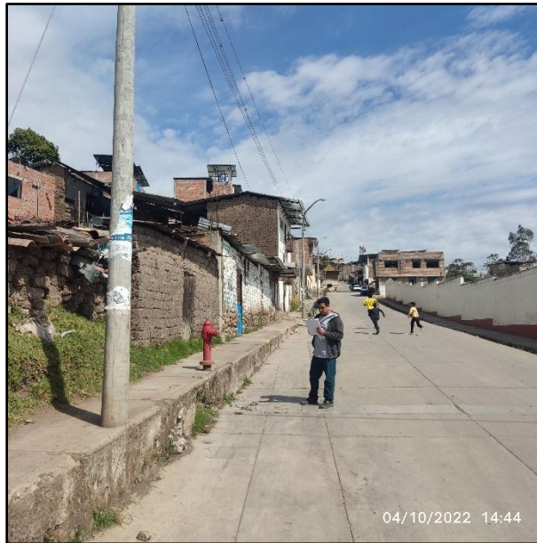
Figura 15: Obstrucción de vereda en el Jr. Miguel Grau por hidrante y poste de luz.
