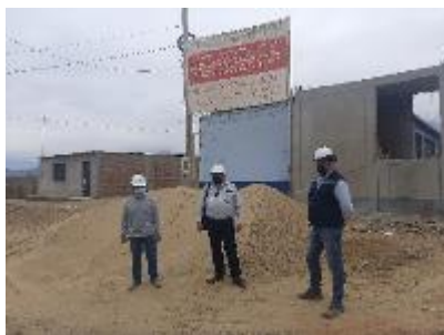
Foto 05: Letrero de la obra.
