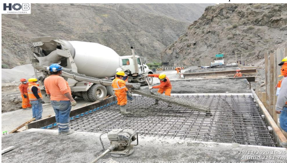
Badén de Concreto Armado – Carretera Pallasca - Mollepatá
