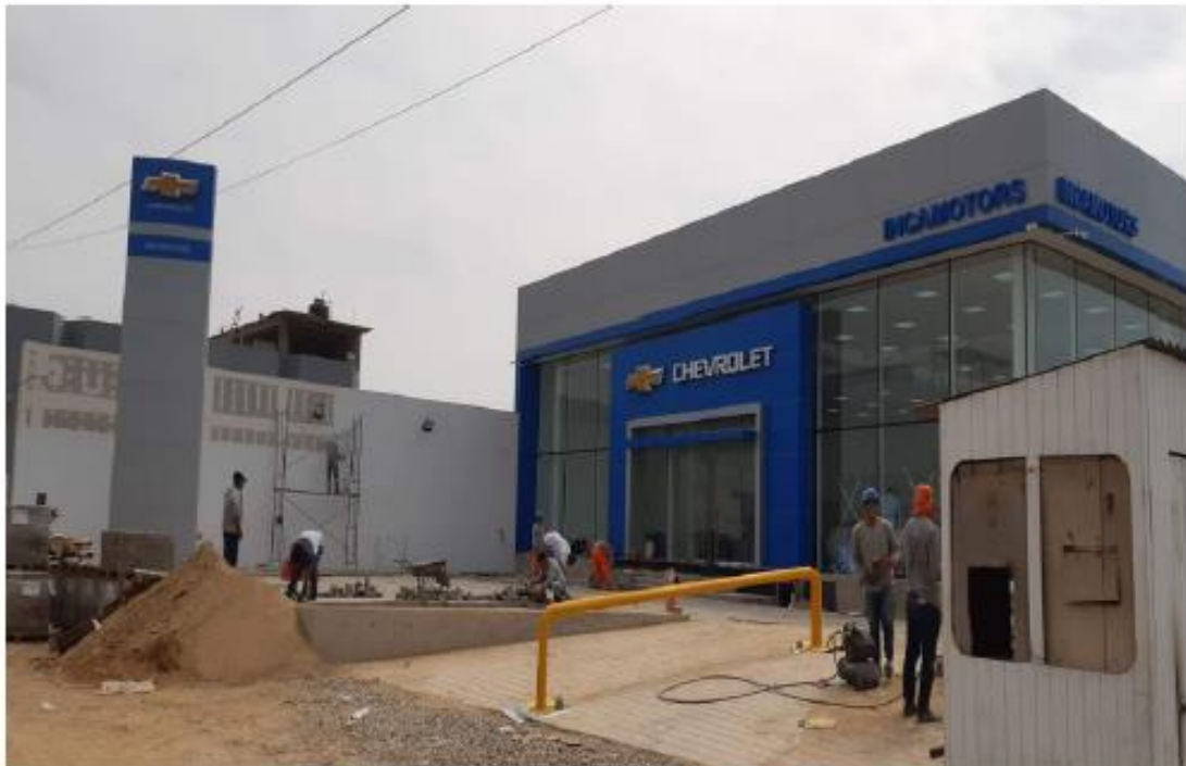
Instalación de aluminio compuesto
