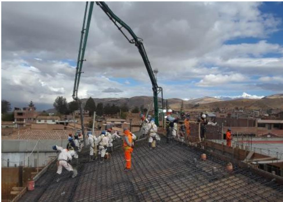
Foto 18: Vaciado de techo 2do Piso Pabellón
