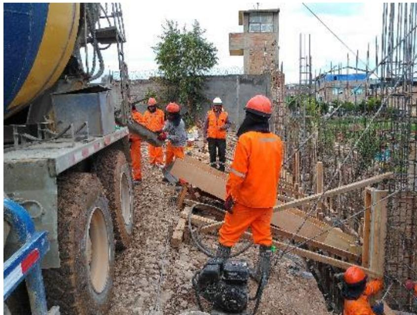
Foto 08: Vaciado de Concreto Placa del Cerco Perimétrico tramo III (colindante vecino)
