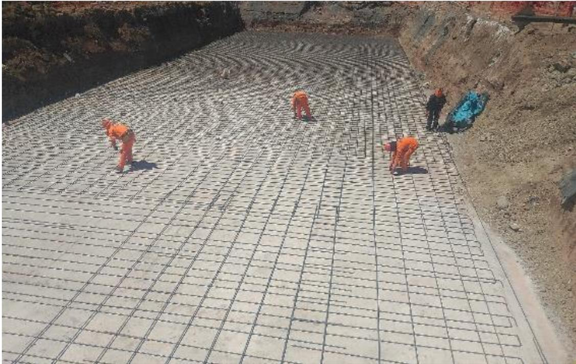
Foto 11: Colocación de acero de la losa de Cimentación del Pabellón
