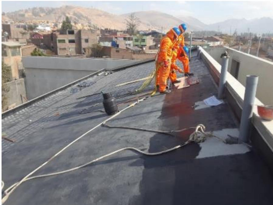
Foto 20: Colocación de Manto Asfáltico en Techo de Pabellón
