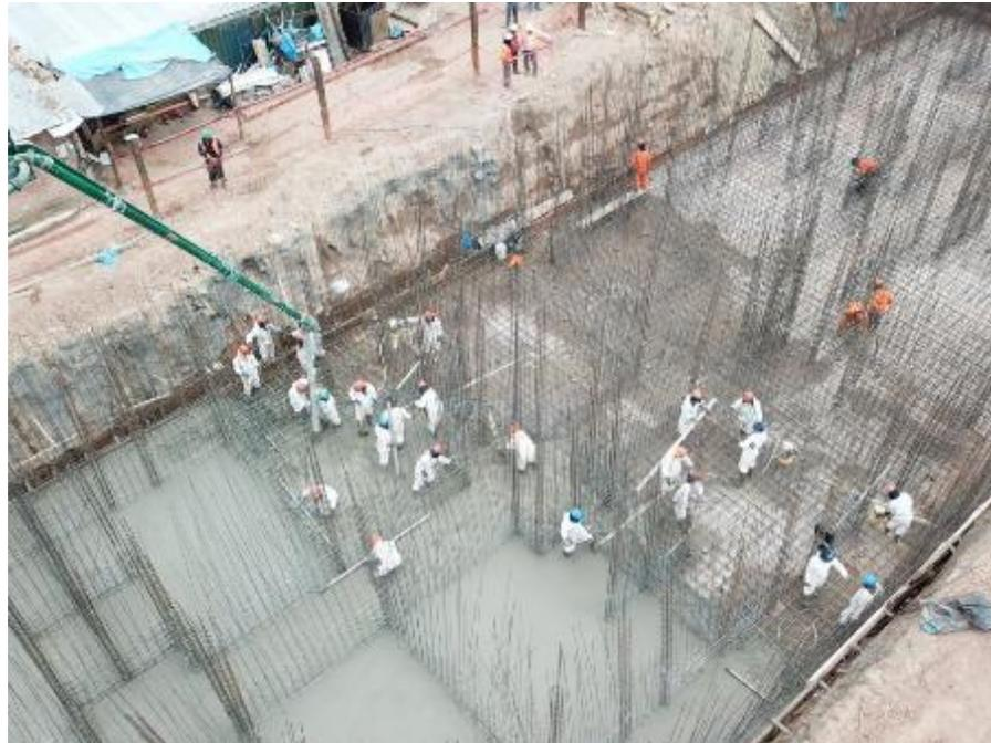
Foto 12: Vaciado de concreto de losa de cimentación en Pabellón
