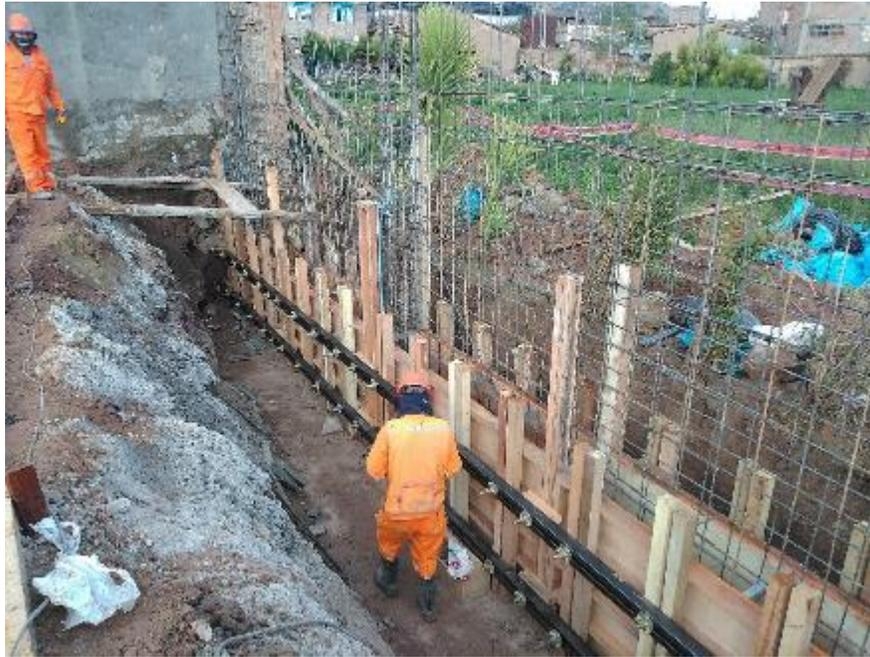
Foto 07: Colocación de Encofrado Placa del Cerco Perimétrico tramo III (colindante vecino)
