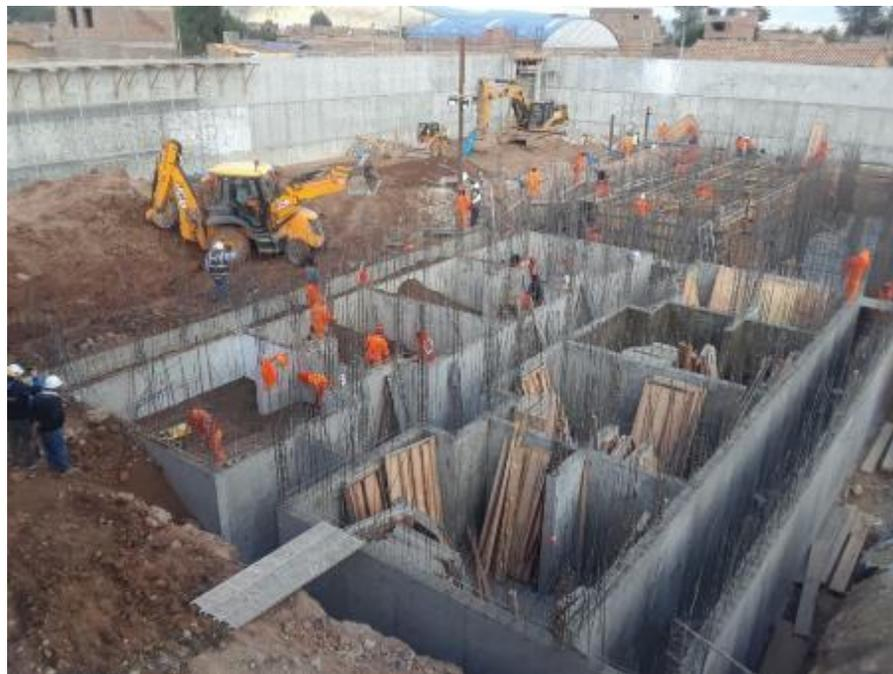
Foto 14: Avance relleno y compactación de celdas y encofrado de Placas de Pabellón
