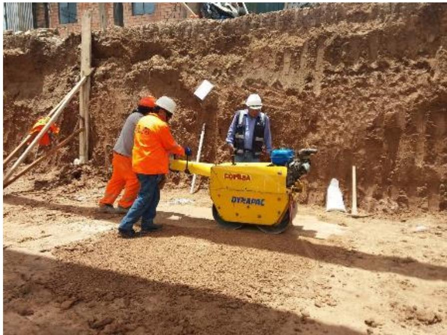
Foto 04: Compactación terreno de fundación para losa de cimentación (Pabellón)
