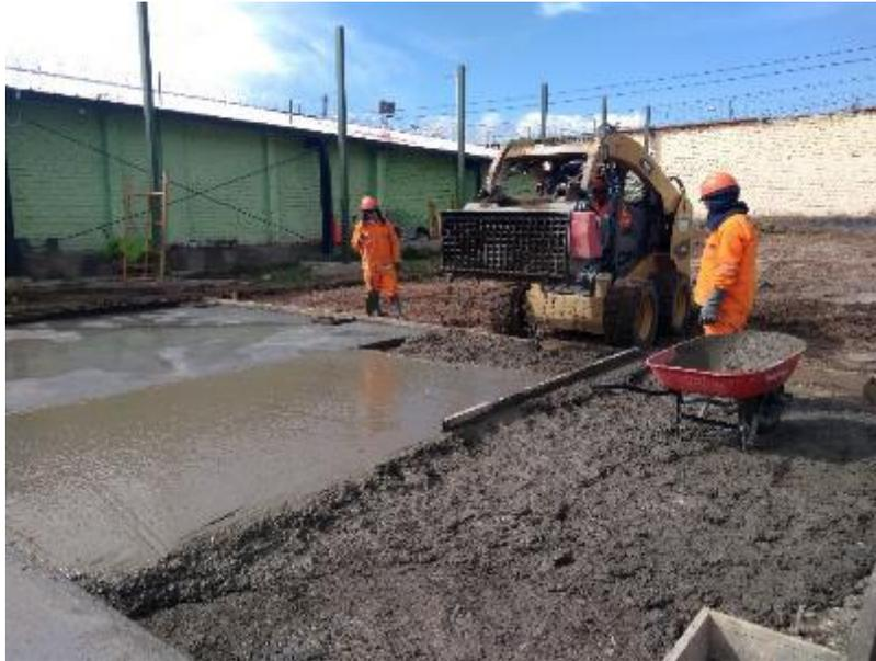
Foto 01: Vaciado de concreto para pisos de obras provisionales
