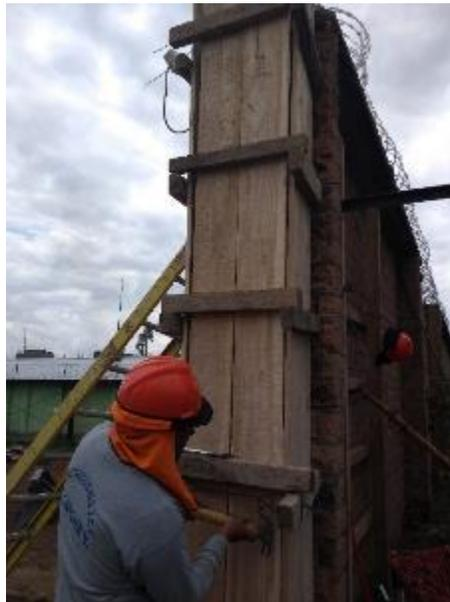
Foto 02: Encofrado de columnas para ingreso provisional
