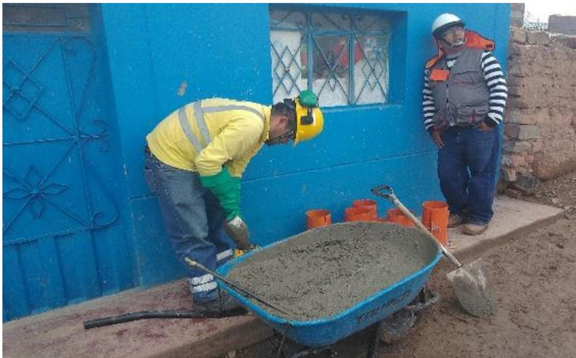
Foto 10: Pruebas de Slump de concreto para las placas del CP tramo III (Colindante a Vecino)
