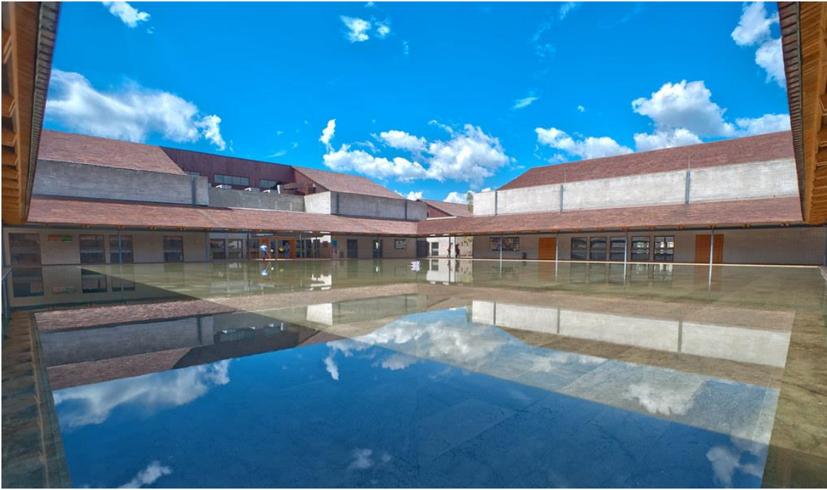
Figura 1. Vista general del caso 01
