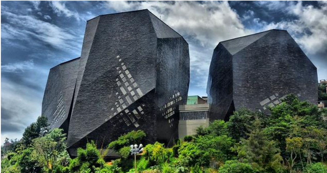
Figura 2. Vista General del caso 02
