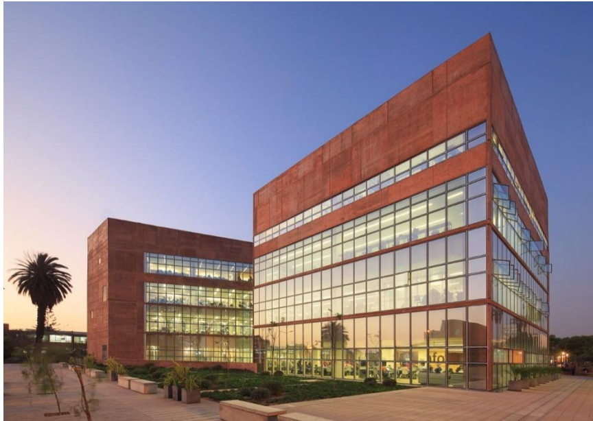
Figura 4. Vista General del caso 04
