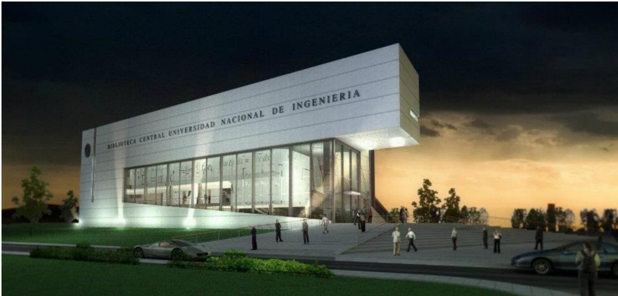
Figura 3. Vista General del caso 03
