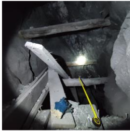
Puntales despues de la voladura
