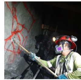
Desatado de rocas
