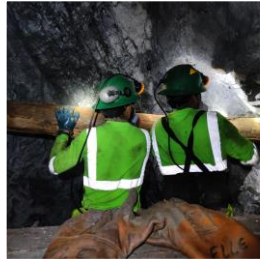
Colocación de puntal
