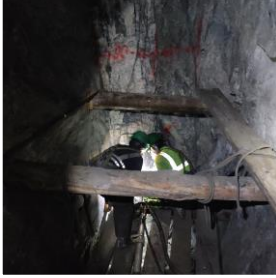
Perforación de taladros
