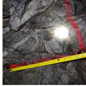
Medición espaciamento de taladros
