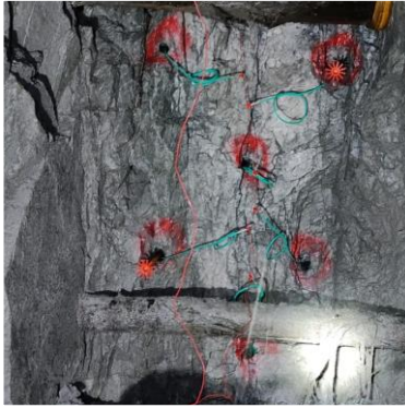
Malla de perforación
