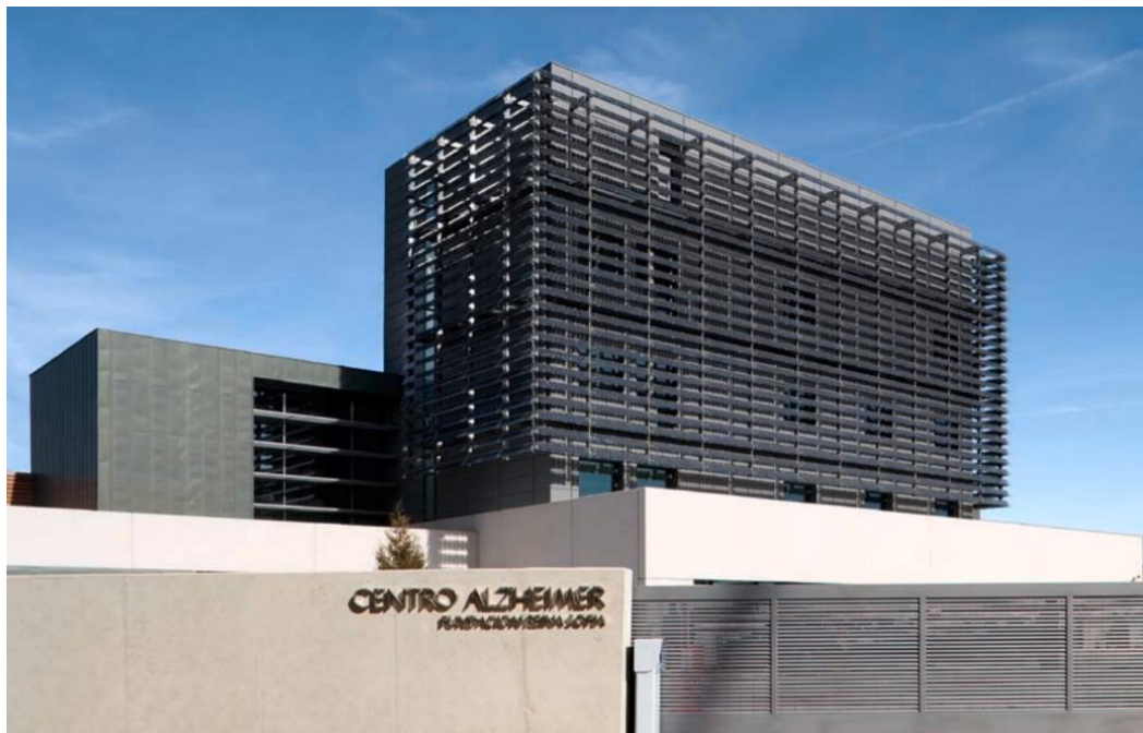
Figura 1: Vista general del caso 01
