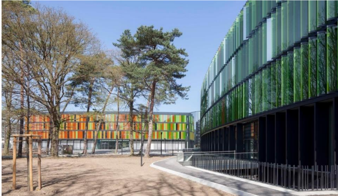
Figura 2: Vista general del caso 02
