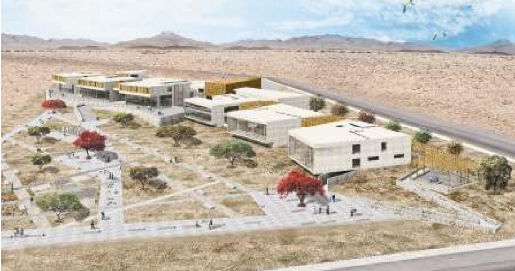
Figura 4: Vista general del caso 04
