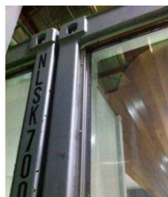
Imagen 46. Unión de contenedores
