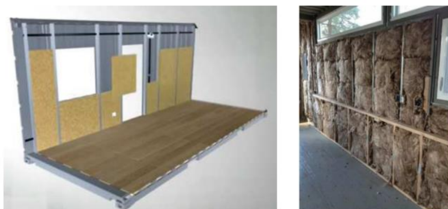
Imagen 51. Colocación de aislamiento
