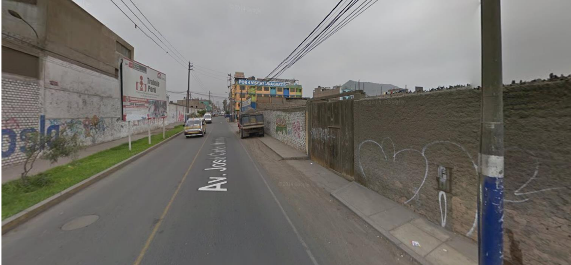
Figura N° 3.22: Vista de la Avenida José Carlos Mariátegui del terreno 2
