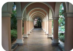
Pisos, pasillos, paredes, columnas, techos, ventanas y estantes
