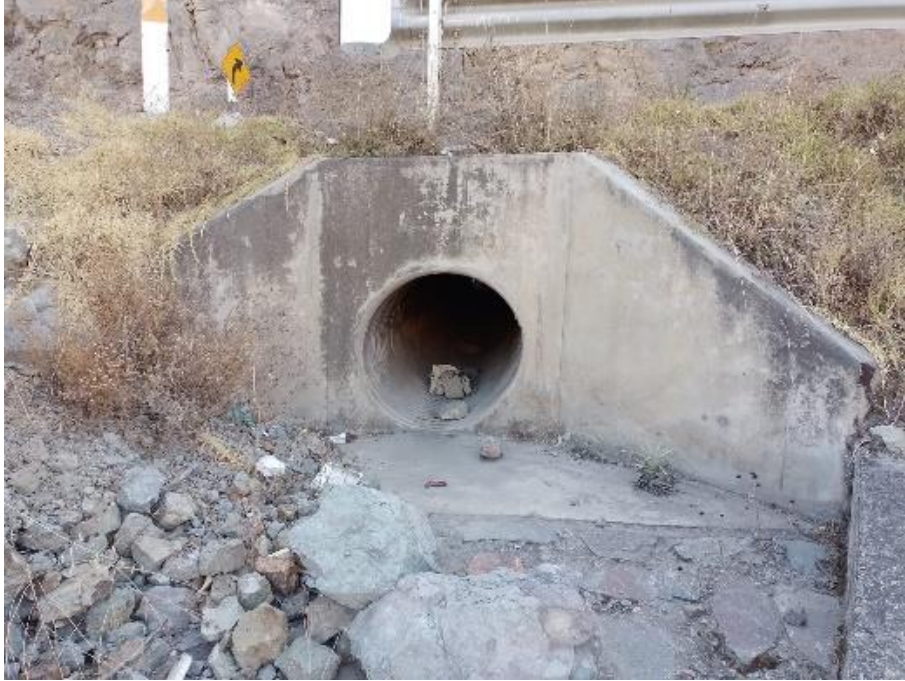
Alcantarilla TMC 36", ubicado en el KM: 01+470
