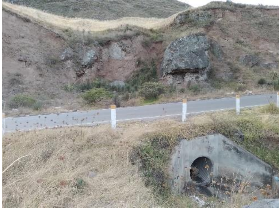
Alcantarilla TMC 36", ubicado en el KM: 02+610
