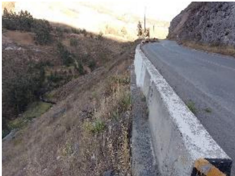
Muro de Contención; 28 metros longitudinal, ubicado en el KM: 01+780
