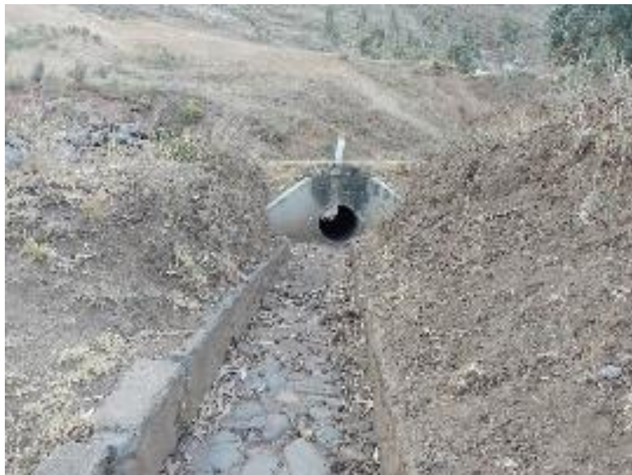
Alcantarilla TMC 36", ubicado en el KM: 02+300
