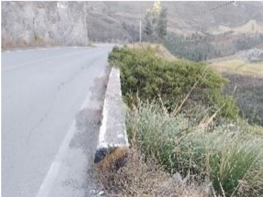
Muro de Contención; 25 metros longitudinal, ubicado en el KM: 01+550
