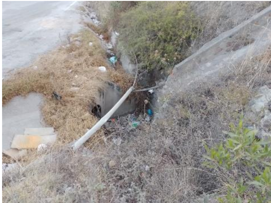
Alcantarilla TMC 36", ubicado en el KM: 02+900
