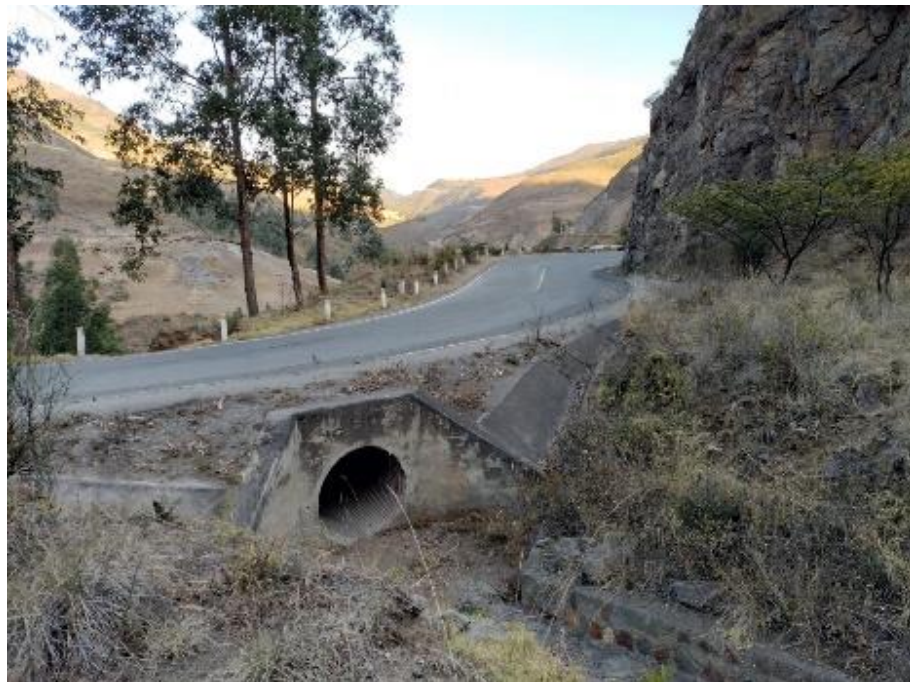
Alcantarilla TMC 48", ubicado en el KM: 02+100
