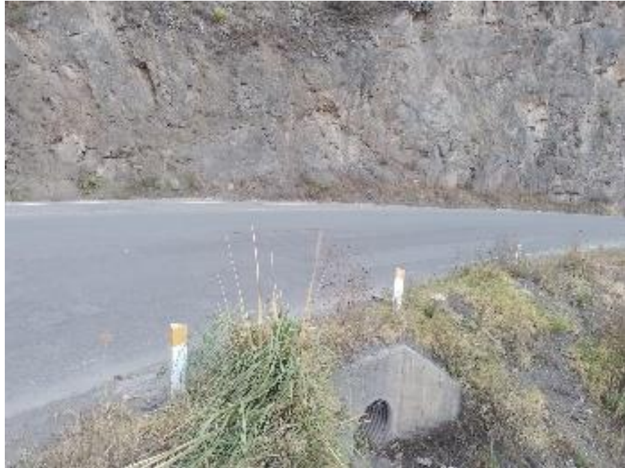
Alcantarilla TMC 36", ubicado en el KM: 01+890
