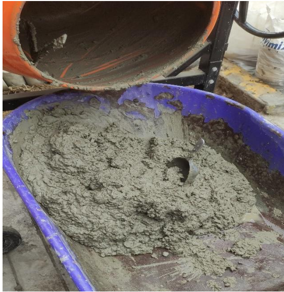
Figura 11. Elaboración de Concreto en Trompo.
