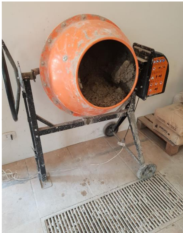
Figura 69: Se coloca los materiales al trompo para el mezclado.
