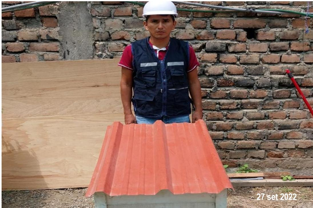
*Figura 12.* Se realiza la fijación de la cobertura de panel termoacústico TK5 en el prototipo F01.
