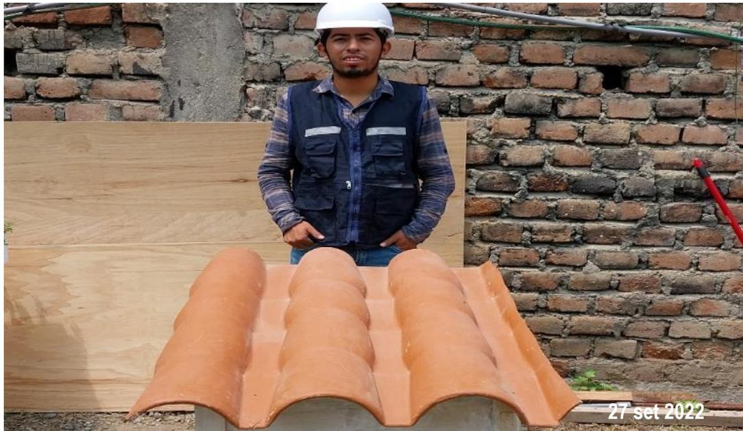
*Figura 13.* Se realiza la fijación de la cobertura de teja andina en el prototipo F02.
