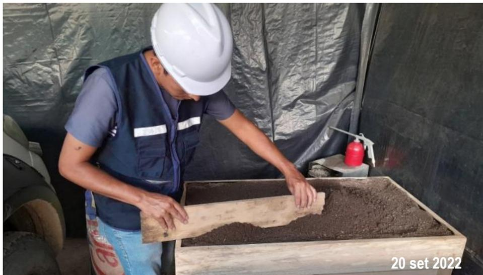
*Figura 8.* Colocación de la tierra orgánica sobre la capa de geotextil con espesor de 1.00 cm, que forma parte de la capa del sustrato para los prototipos V01 y V02.
