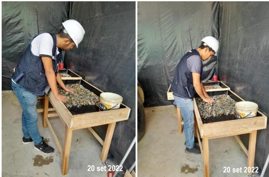
Figura 5. Se muestra la colocación de piedra chancada de 1/2", para el drenaje de las aguas infiltradas de las capas superiores para los prototipos V01 y V02.
