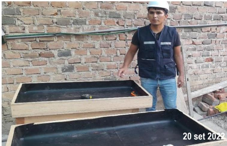
*Figura 4.* Se detalla la colocación de la capa impermeabilizante con geomembrana en los prototipos V01 y V02, además se realiza los orificios de 3/8” de diámetro para la evacuación de las aguas infiltrada.
