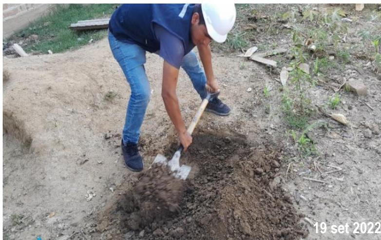
*Figura 02.* Se realizó la extracción del suelo orgánico para la construcción de la capa del sustrato de techos verdes (V01 y V02).
