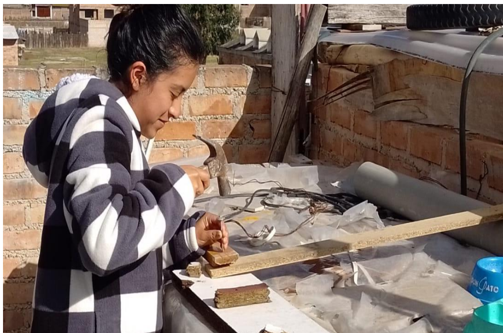
Anexo 14: Construcción de prototipo
