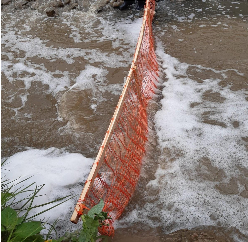
Figura 16. Instalación del sistema de retención en el río Cajamarquino
