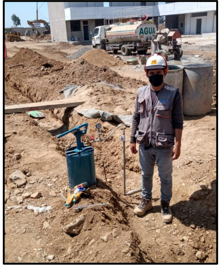
Descripción: Control de la prueba de hidraulica de las redes exteriores.
