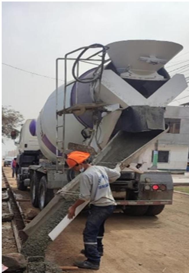
*Nota.* Vaciado con concreto premezclado en sardinel sumergido. Fuente: Elaboración propia.
