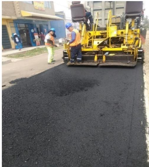
*Nota.* Colocación de carpeta asfáltica en caliente e=2". Fuente: Elaboración propia.
