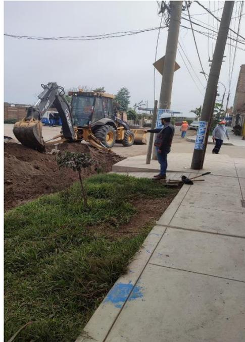
*Foto 5. Excavación nivel de subrasante con equipo*
