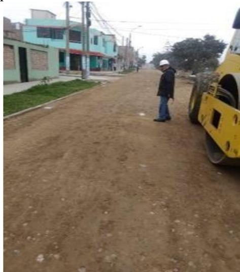
*Nota.* Conformación y compactación de la sub base y base de la vía. Fuente: Elaboración propia.
