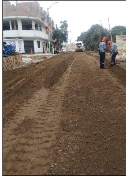
*Foto 13. Conformación y compactación de sub base c/motoniveladora.*
