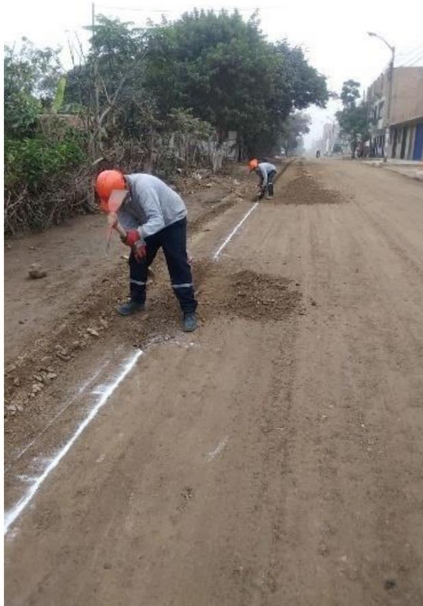
*Nota.* Excavación manual de zanja para sardinel sumergido. Fuente: Elaboración propia.
