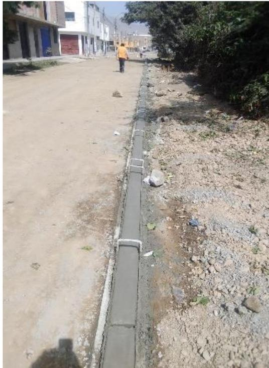
*Nota.* Se muestra el encofrado metálico en sardinel sumergido. Fuente: Elaboración propia
