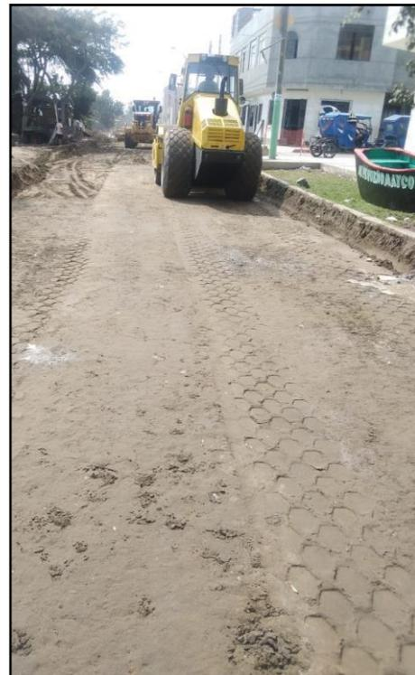
*Foto 12. Conformación y compactación de sub base c/motoniveladora*
