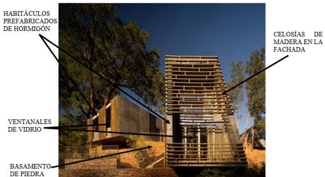
Figura 16. Sistema estructural del caso N°03 Fuente: Archidaily
