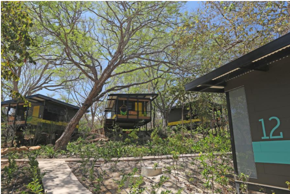
Figura 4. Vista general del caso N°04
