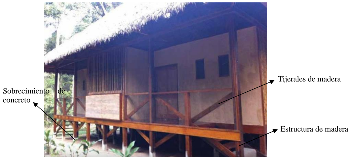
Figura 7. Gráfico estructural del caso N°01 Fuente: ISSU
