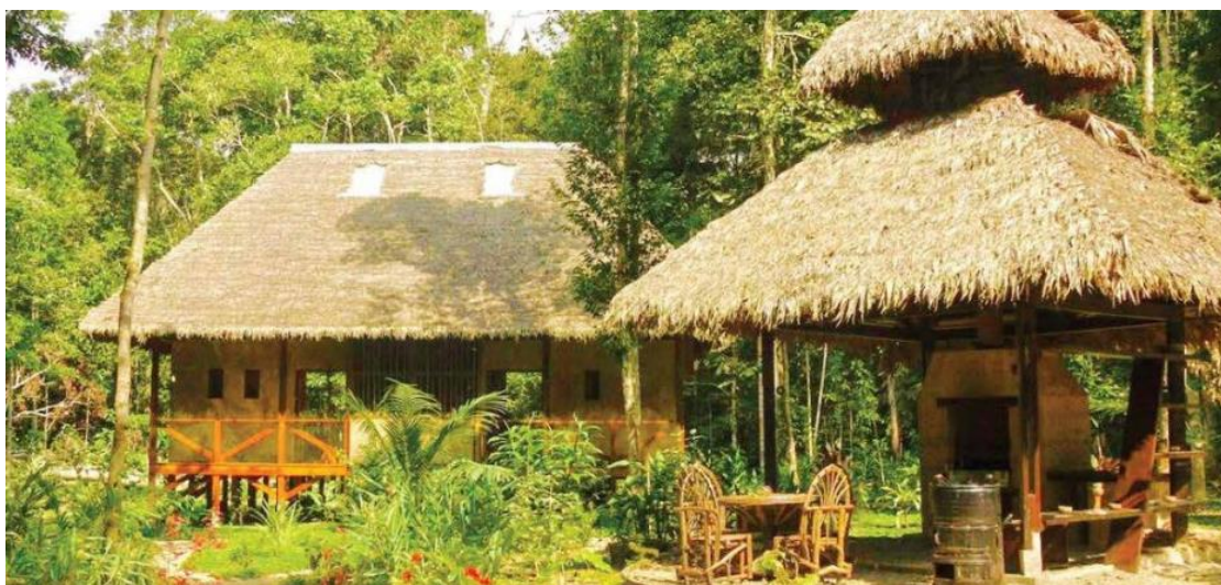
Figura 1. Vista general del caso N°01
