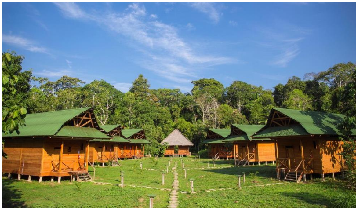
Figura 2. Vista general del caso N°02
