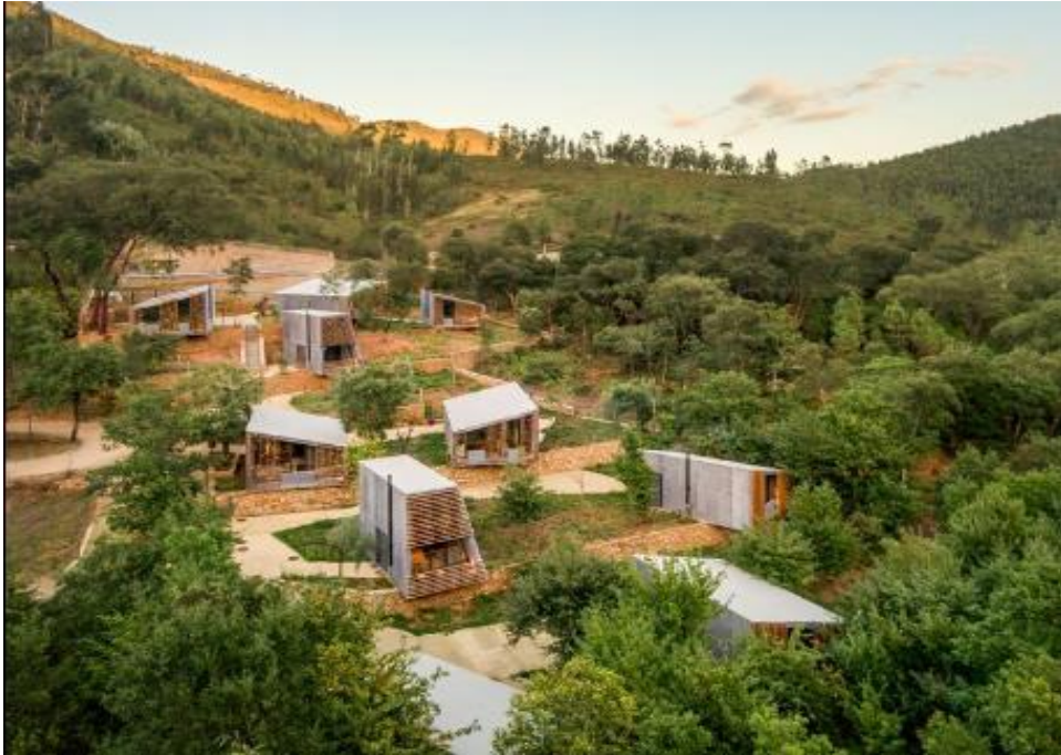
Figura 3. Vista general del caso N°03
