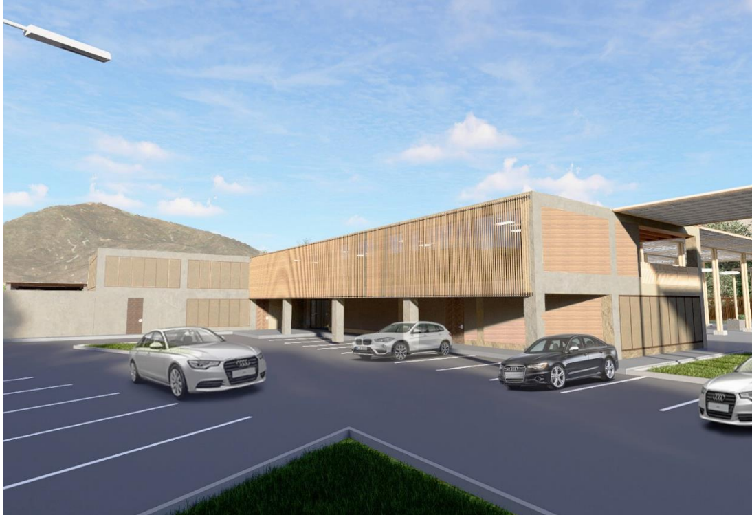
Figura 126. Vista al estacionamiento
