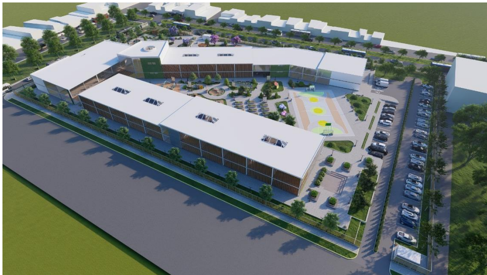
Figura 69: Vista 4 tipo vista aérea del proyecto
