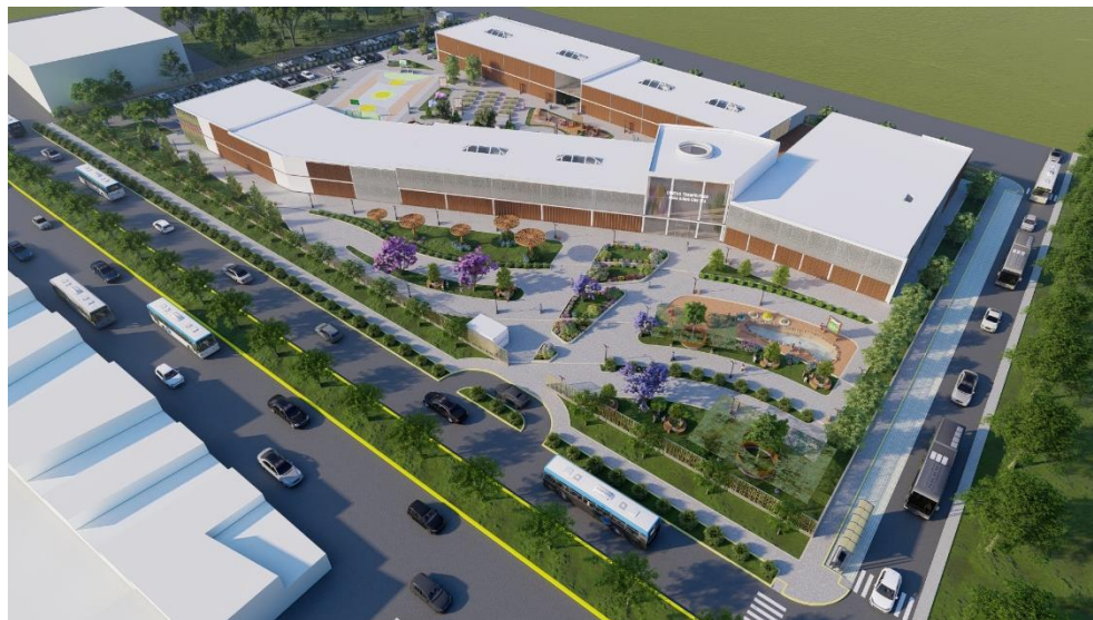
Figura 67: Vista 2 tipo vista aérea del proyecto
