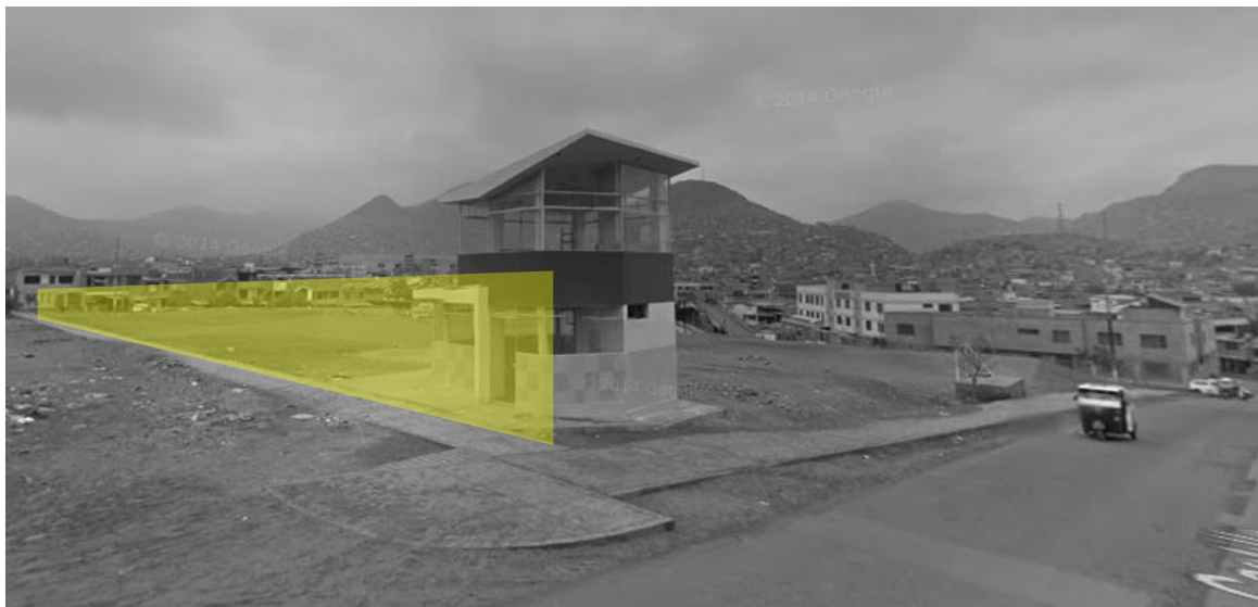
Vista del terreno por la Av. Ejercito
