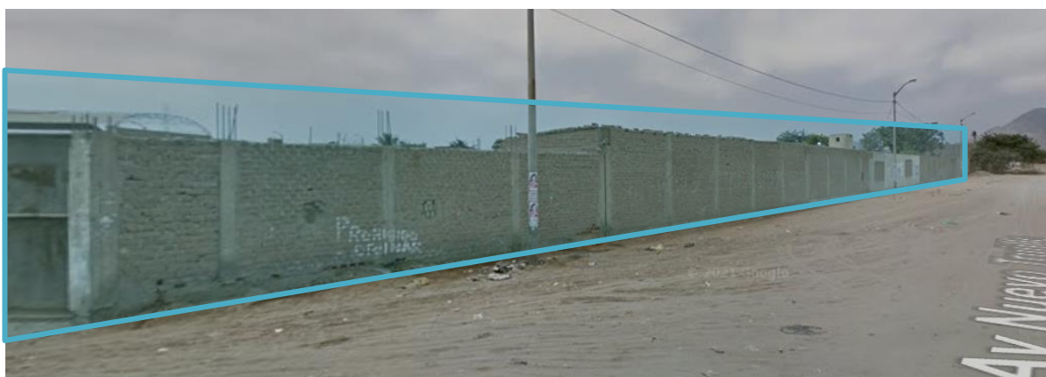
Figura 34: Vista desde Av. Nuevo Trujillo
