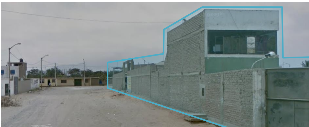
Figura 35: Vista desde pasaje San Pedro
