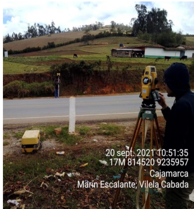
Figura N° 47: Inicio de levantamiento topográfico con Estación
