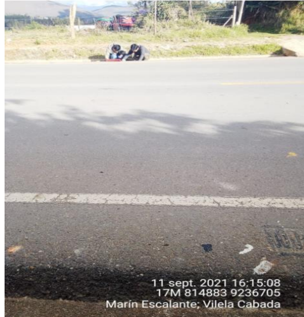
Figura N • 41: monumentación de puntos de control.
