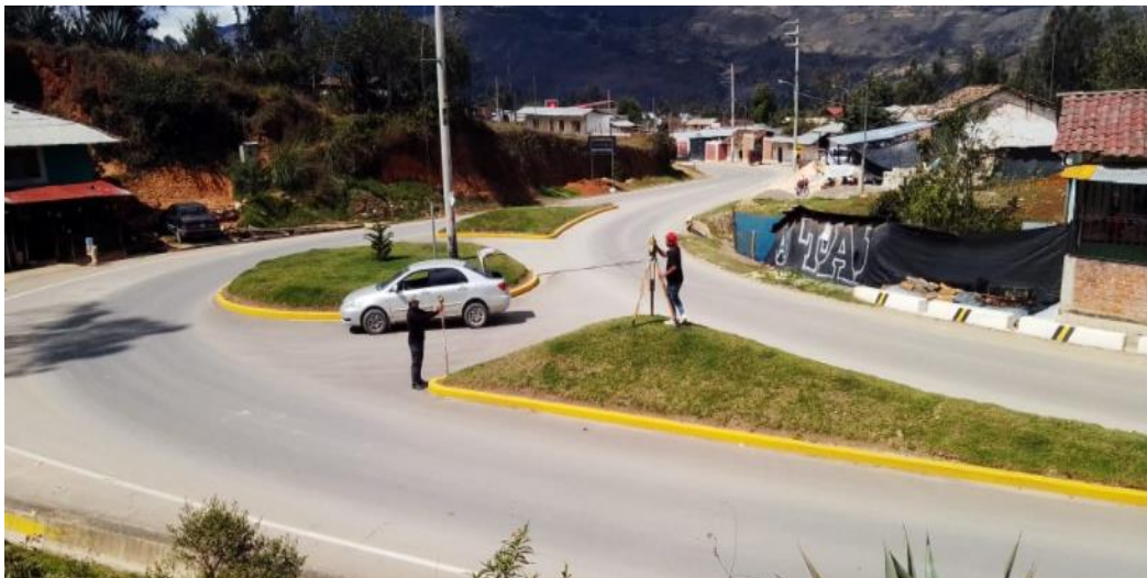
Figura N° 47: Levantamiento topográfico en Km 97+160 con
