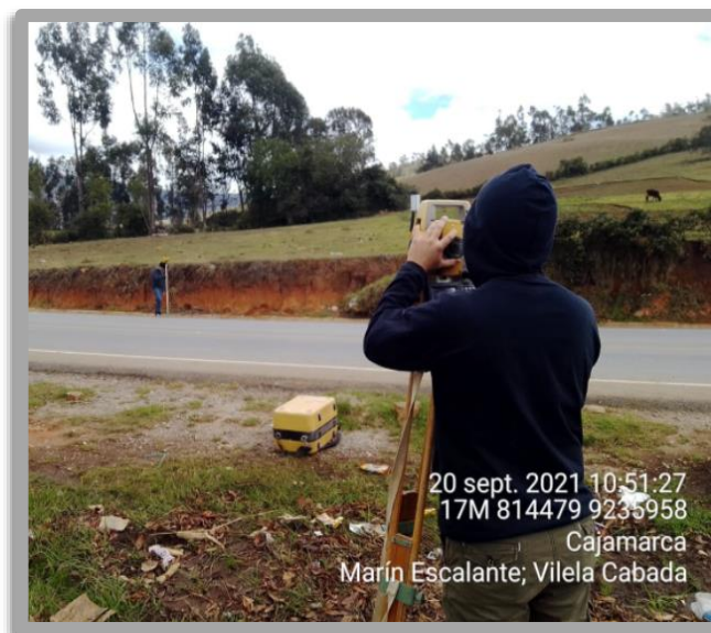
Figura N • 12: Radiación de puntos en todo el tramo de la vía en estudio (Km 96+000 – Km 98+000).
