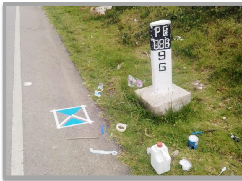
Figura N° 10: Monumentación de los puntos de control con esmalte sintético de color celeste, los que a su vez servirán como Dianas para el levantamiento fotogramétrico.
