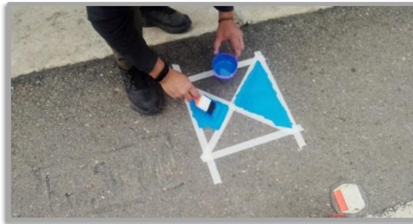
Figura N° 6: Pintado de los puntos de control con esmalte sintético, los que a su vez servirán como dianas para el levantamiento fotogramétrico.
