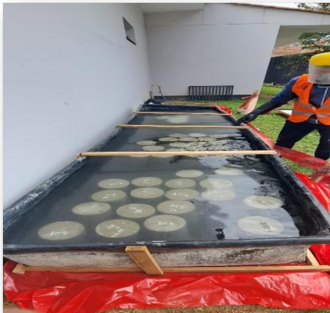
Foto 16. Foto del curado del concreto agua convencional.
