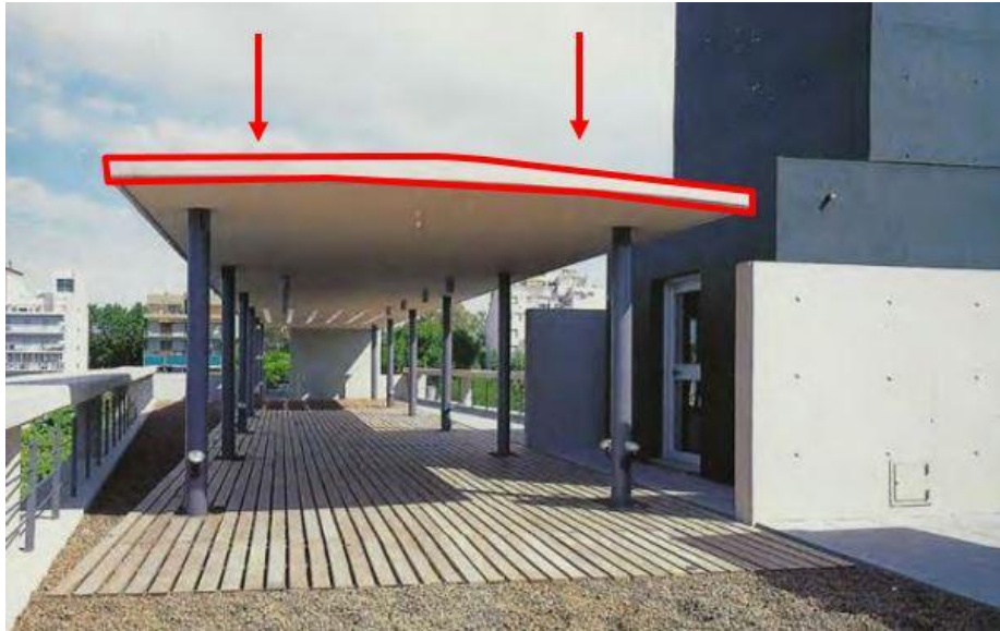
Figura 16. Edificio Corporativo Organon
