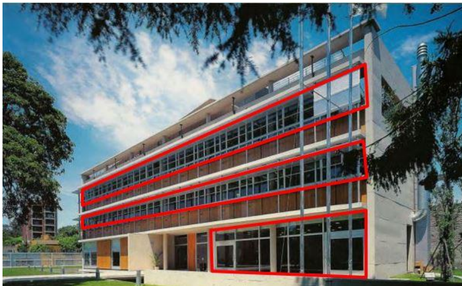
Figura 17. Edificio Corporativo Organon
