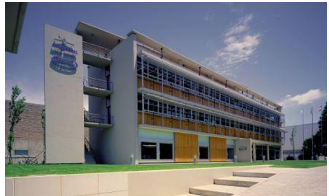
Figura 2. Edificio corporativo Organon
