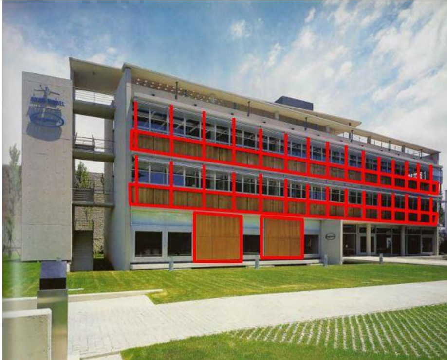
Figura 18. Edificio corporativo Organon
