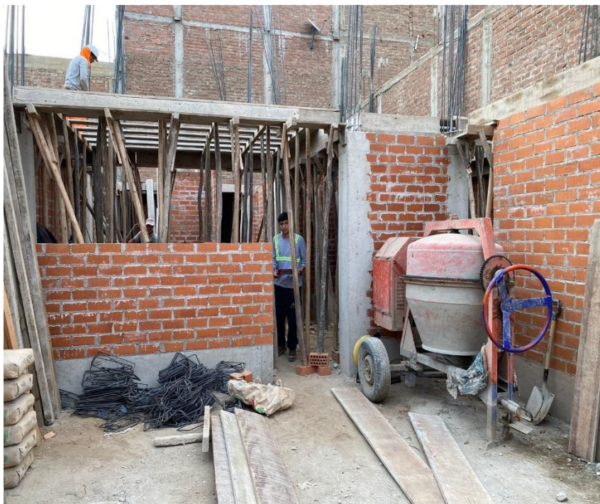
ANEXO N°37: Vaciado de concreto artesanal.
