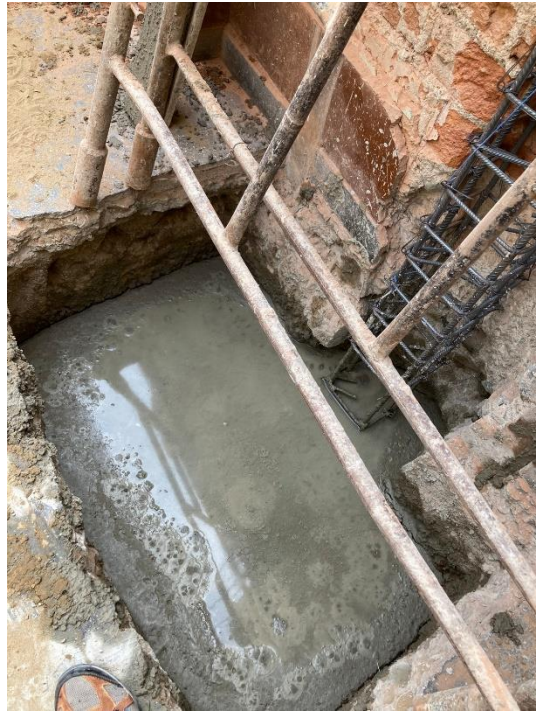
ANEXO N°38: Vaciado de concreto artesanal.
