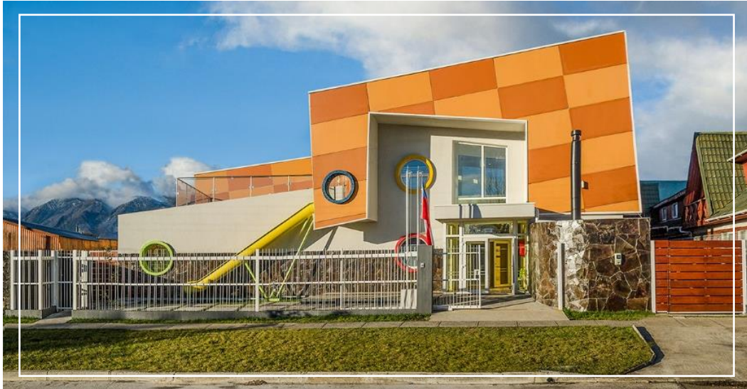
Figura 3: Vista aérea caso 3 Fuente: Archdaily.pe
