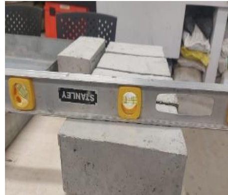
Figura 42. Medición y Nivelación de las unidades de albañilería
