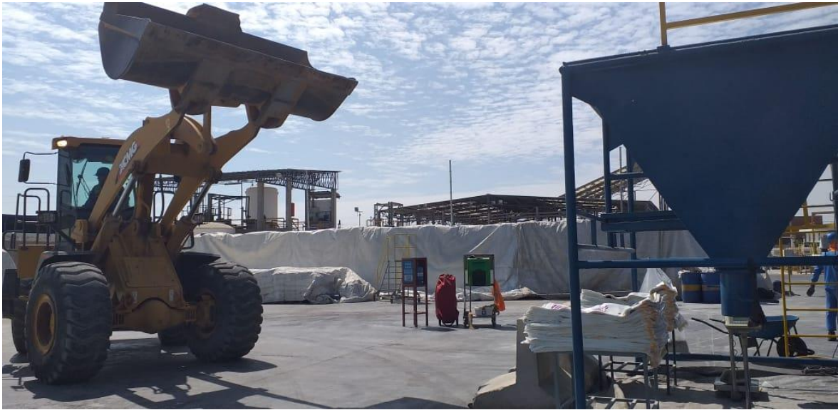
Foto 3.1: Abastecimiento del fertilizante granulado a Tolva
