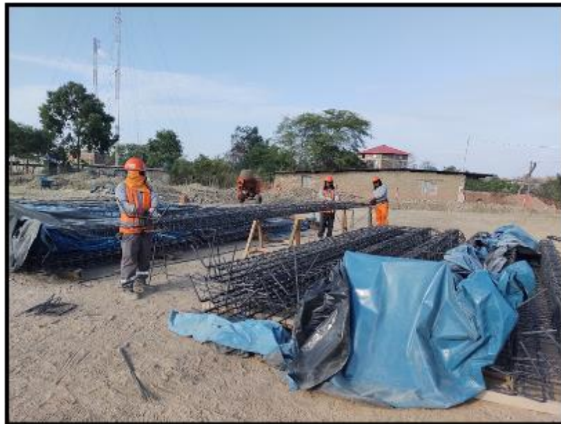
FOTO N°01.- Colocación de acero de zapata.
