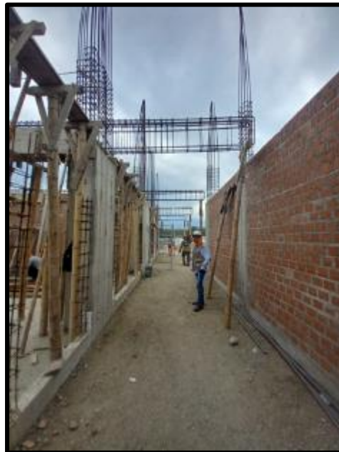
FOTO N°12.- Vista de columnas desencofradas.
