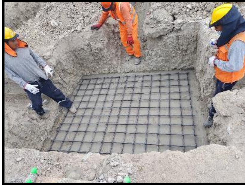
FOTO N°01.- Colocación de acero de zapata.
