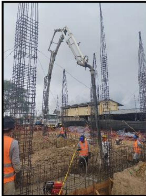
FOTO N°07.- Encofrado de vigas de cimentación.
