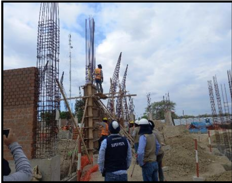
FOTO N°11.- Concreto premezclado F'c=210 \text{ Kg/cm}^2 . para columnas y placas.
