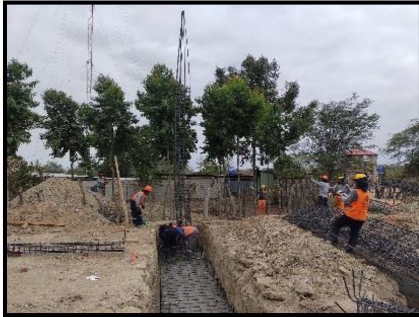
FOTO N°03.- Izaje de columnas y placas prearmadas.
