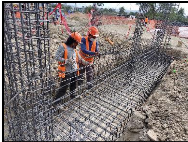
FOTO N°05.- armado de vigas de cimentación modulo 9.
