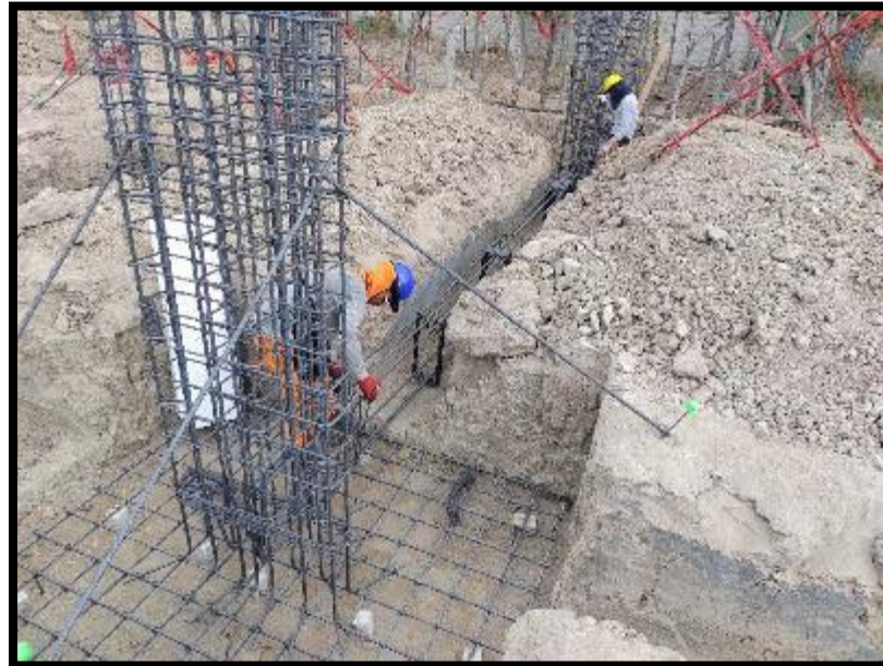
FOTO N°04.- Armado de vigas de cimentación.
