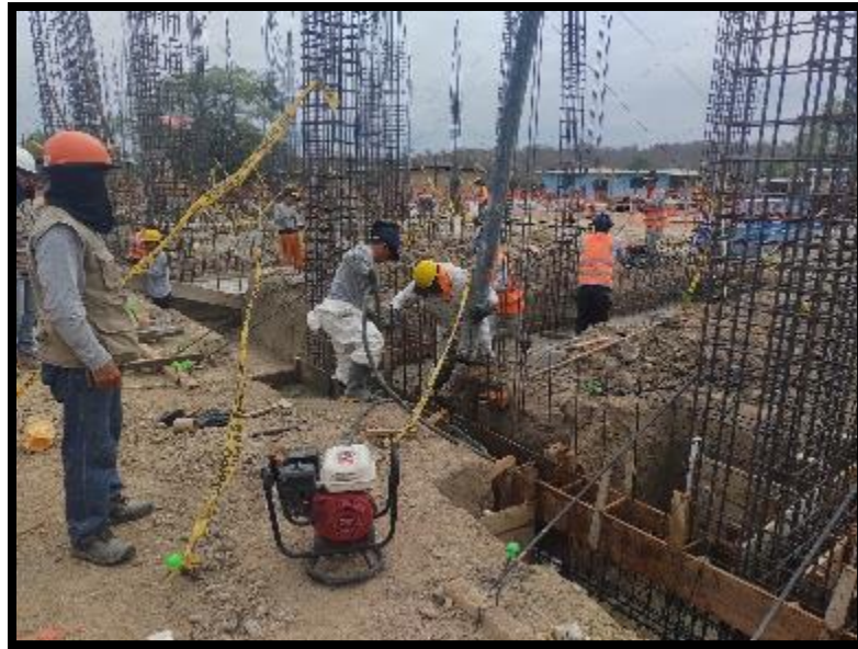
FOTO N°9.- Vibrado de concreto en vigas de cimentación y zapatas.
