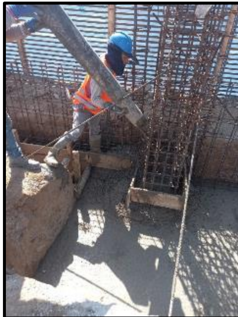
FOTO N°13.- Vista de avance de columnas don concreto.
