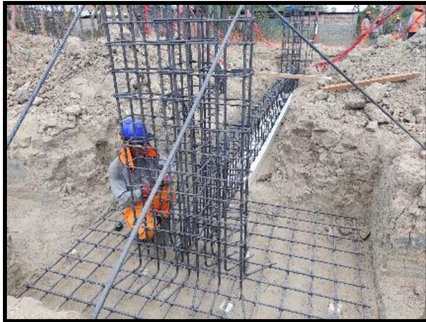
FOTO N°05.- armado de vigas de cimentación modulo 9.
