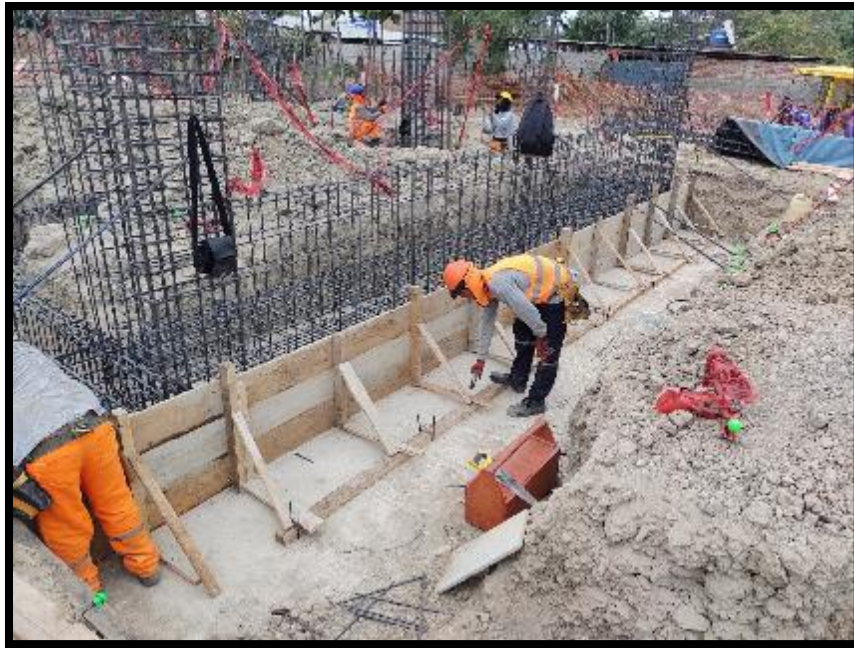
FOTO N°07.- Encofrado de vigas de cimentación.
