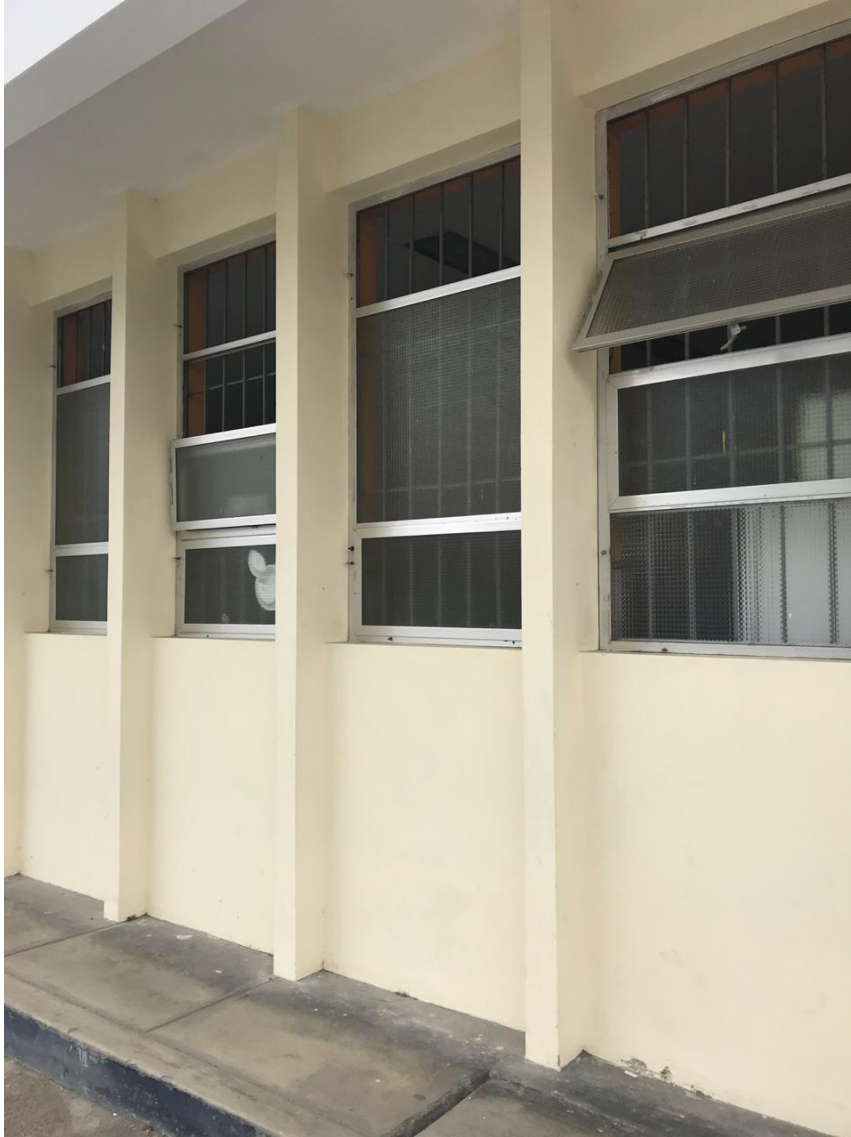
Ventanas Pabellón Psiquiátrico del Hospital Regional
