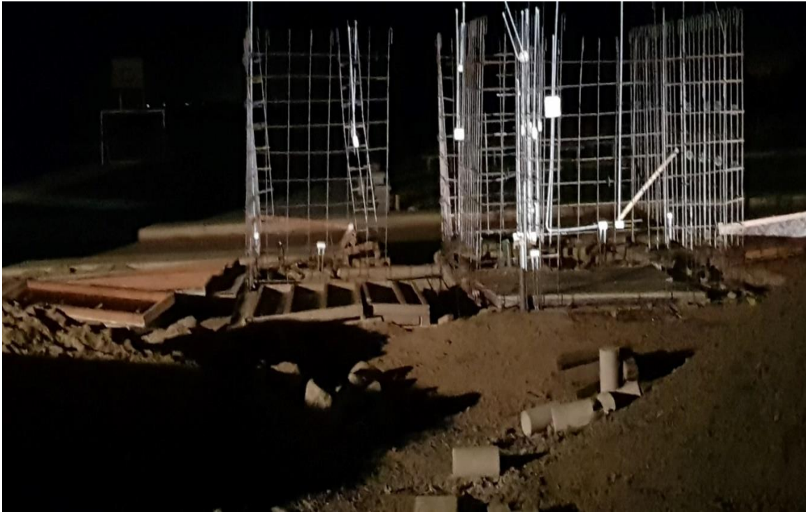
Figura 36. Realizando trabajos en el segundo turno.
