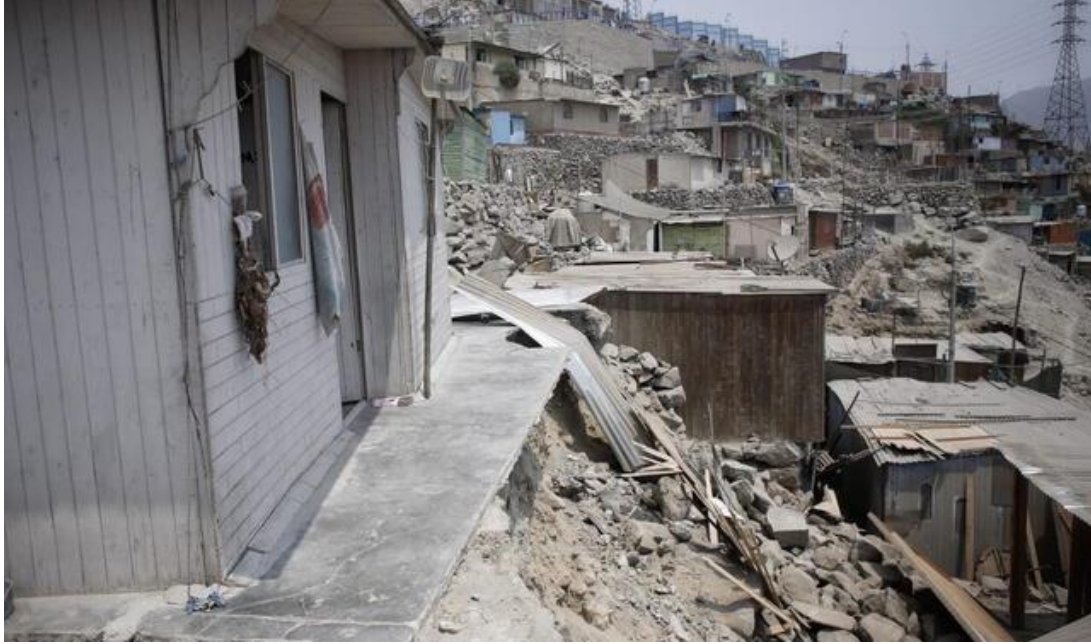
Figura 15. Vulnerabilidad de una vivienda multifamiliar frente a un sismo.
