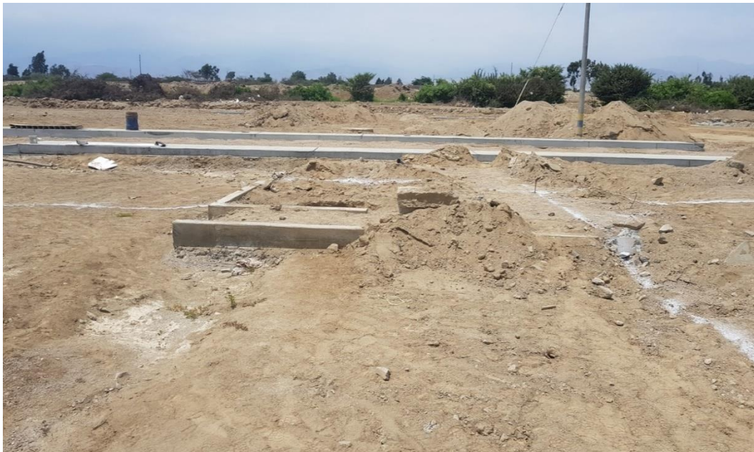
Figura 33. Empezando con los trabajos preliminares
