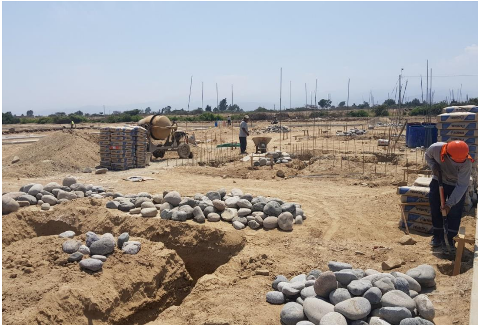
Figura 34. Realizando las excavaciones para la habilitación del terreno
