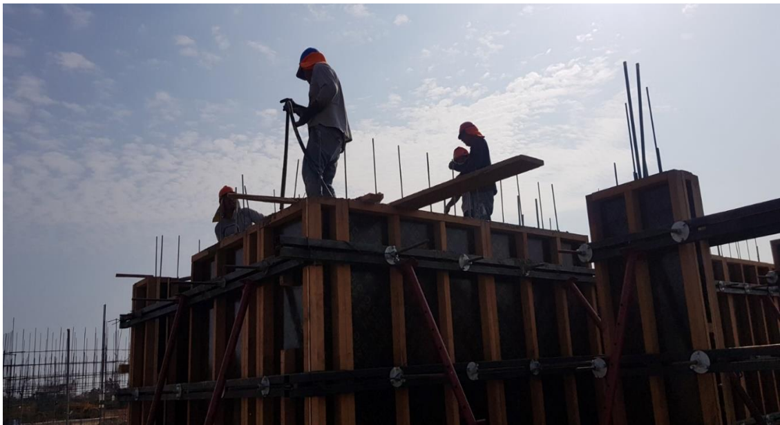
Figura 41. Desencofrando, para continuar el ritmo del avance.
