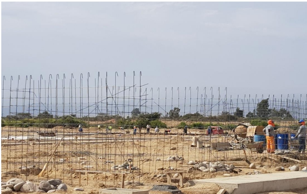
Figura 35. Realizando la habilitación del acero en malla.
