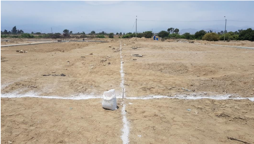
Figura 32. Inicio de Obra con trazo y replanteo.
