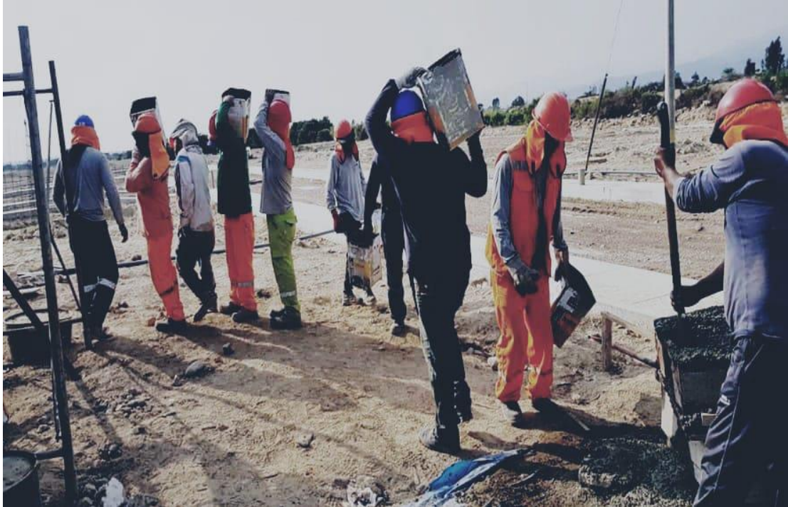
Figura 41. Desencofrando, para continuar el ritmo del avance.
