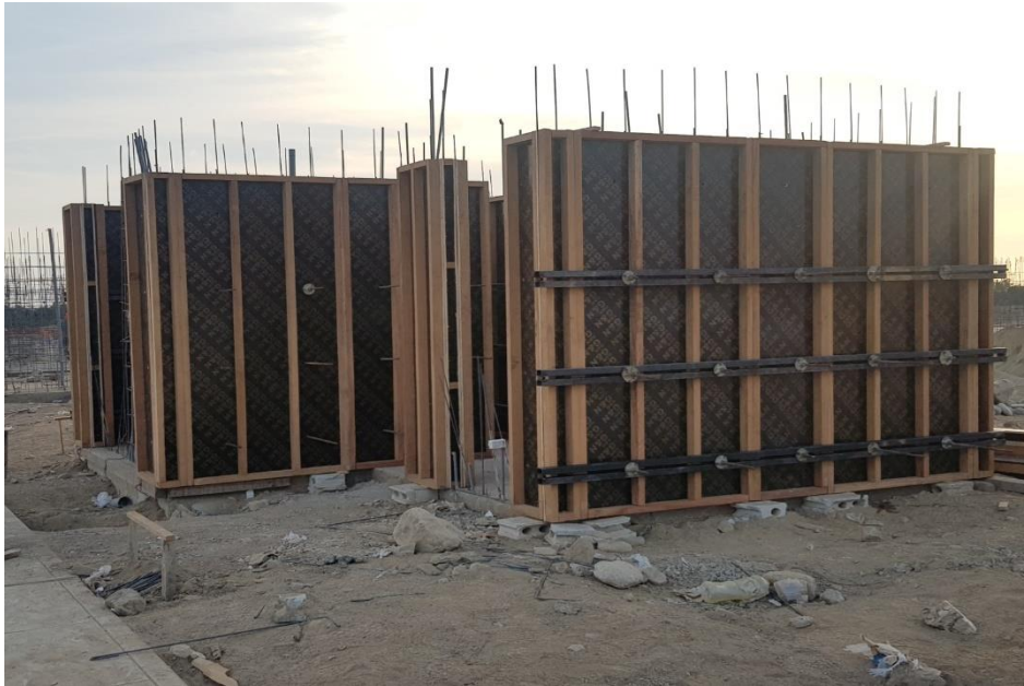
Figura 38. Encofrado listo para el vaciado de concreto
