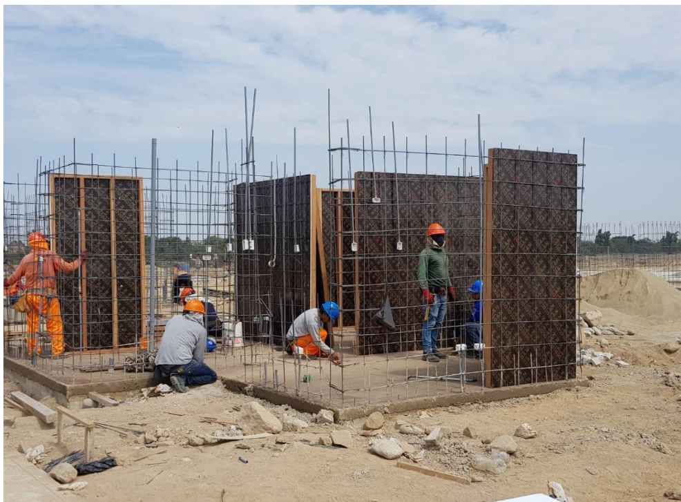
Figura 37. Empezado a realizar el encofrado.
