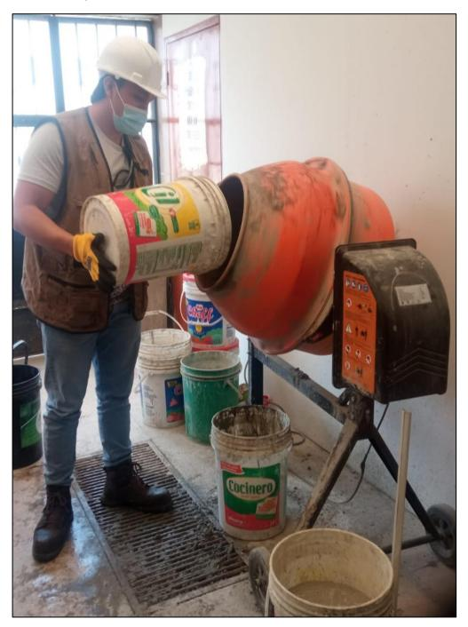
*Nota*. En esta figura se muestra parte del proceso de la elaboración de la mezcla de concreto.
