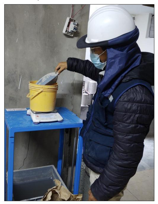
*Nota*. En esta figura se muestra parte del proceso de la mezcla de concreto, pensando el aditivo de microsílice.
