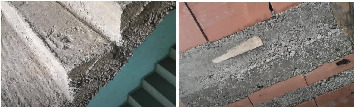
*Nota:* En la imagen se visualiza la segregación del concreto después de un vaciado o llenado de alguna estructura. Tomado de la página web de Global Invent (2021).
