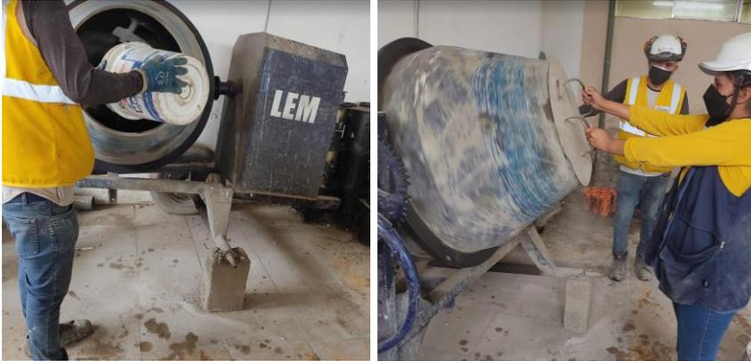
*Nota.* Una vez colocado el agregado grueso (piedra), se ingresa el 50% de agua para su batido, luego la arena y finalmente el cemento con el agua restante, se cubre con una tapa circular para que no se desperdicie o salpique la mezcla.
