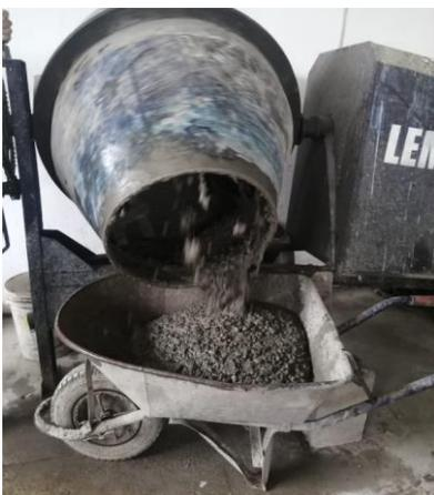
*Nota.* Vaciamos la mezcla para luego batirlo con una pala para homogenizar la mezcla.
