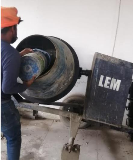
*Nota.* Una vez humedecido la mezcladora agregamos el primer material, en este caso el agregado grueso.
