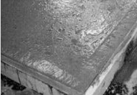
*Nota:* En la imagen se visualiza como se genera la exudación del concreto posteriormente del llenado de una estructura, por Kosmatka, H., Panarese, C., & Bringas, S. (1992).
