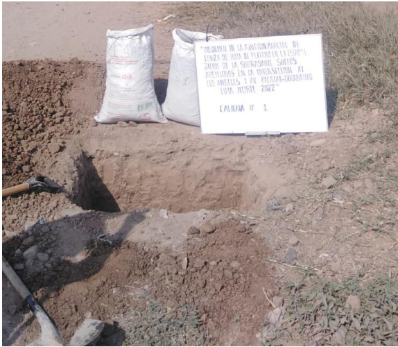
Figura 5: Calicata 1 en la Av. Los Ángeles – Carabayllo.
