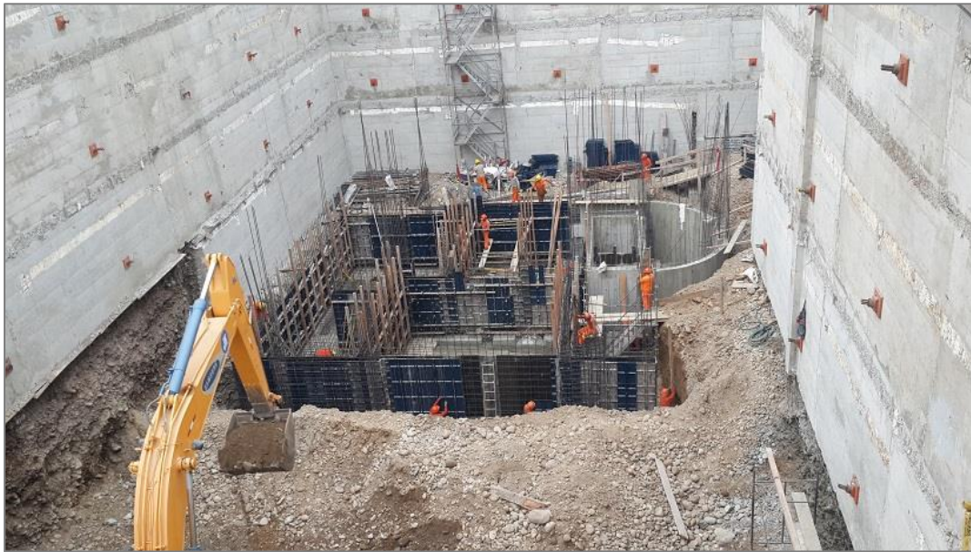
Ilustración 2: Construcción Edificio Ocean House II
