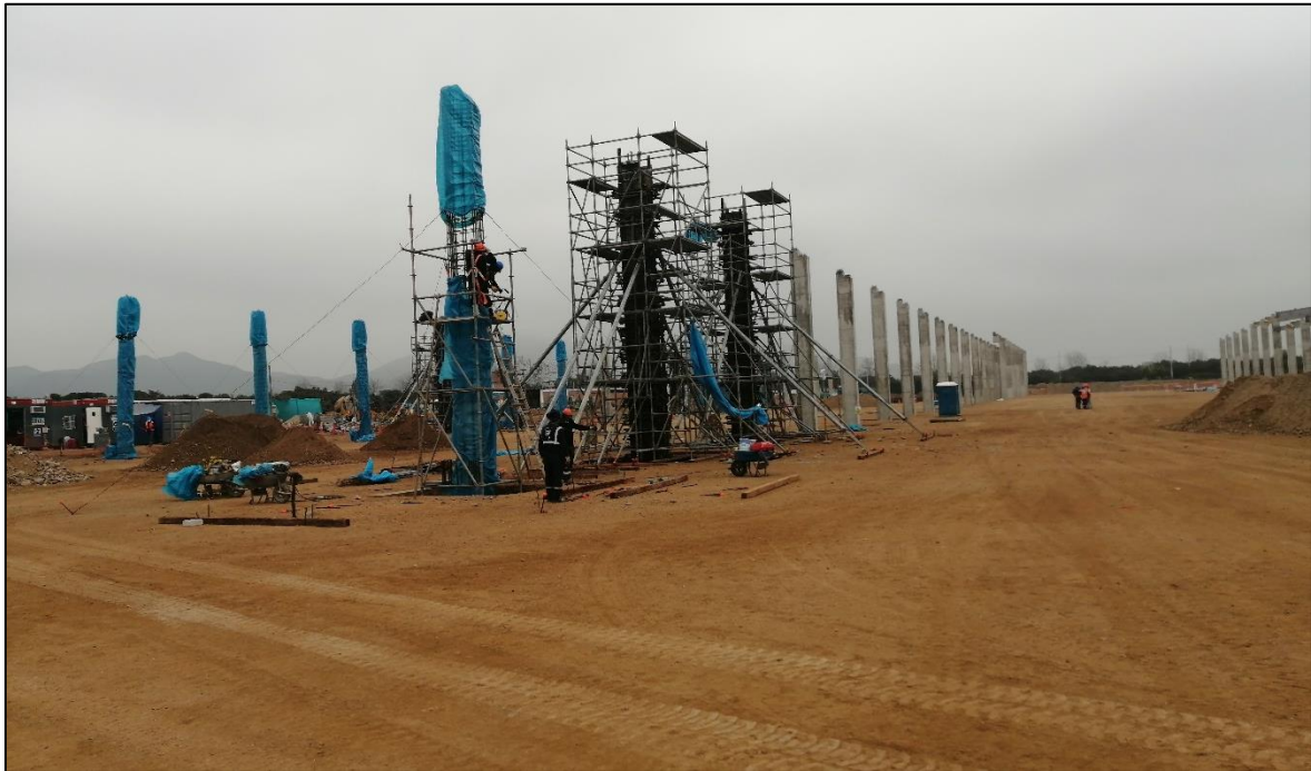
Ilustración 44: Proceso de vaciado de zapatas, encofrado y vaciado de columnas
