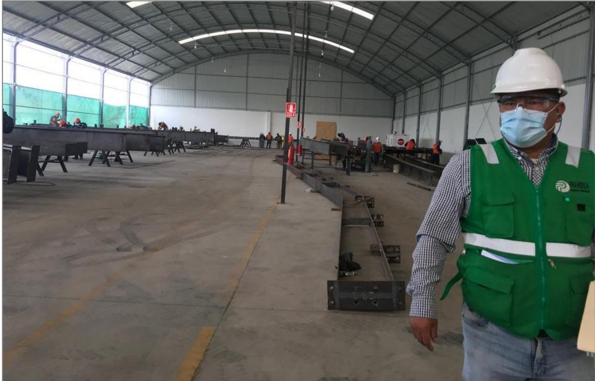
Ilustración 35: Proceso de Fabricación de Vigas de acero
