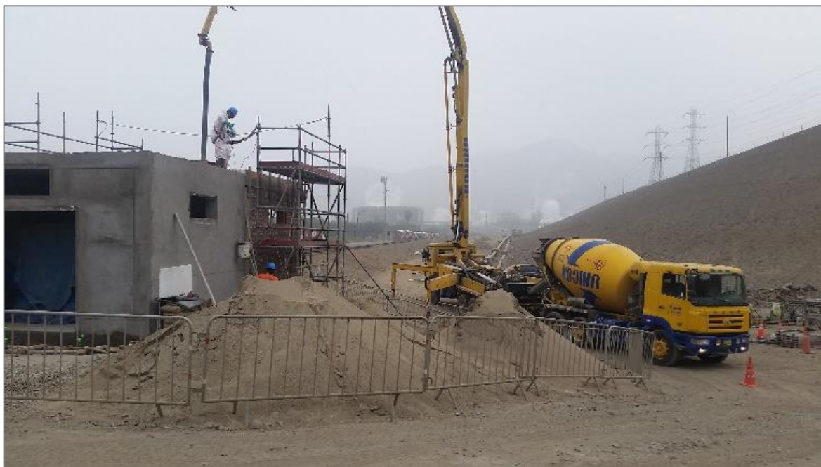
Ilustración 4: Obras Civiles PTAR – Aceros Arequipa
