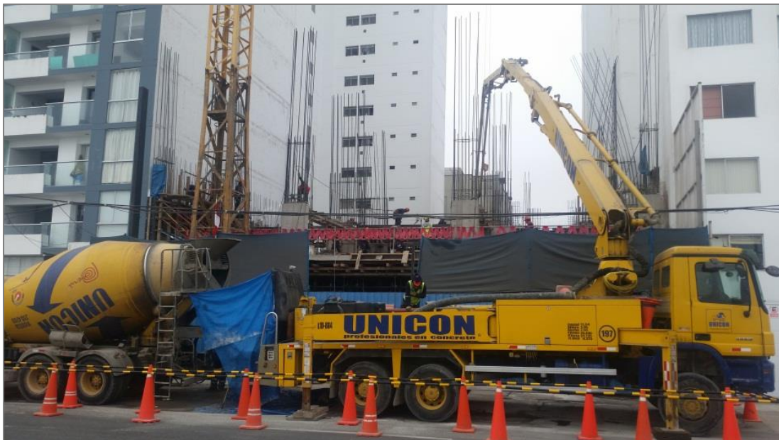
Ilustración 3: Construcción edificio HPC-La Muralla
