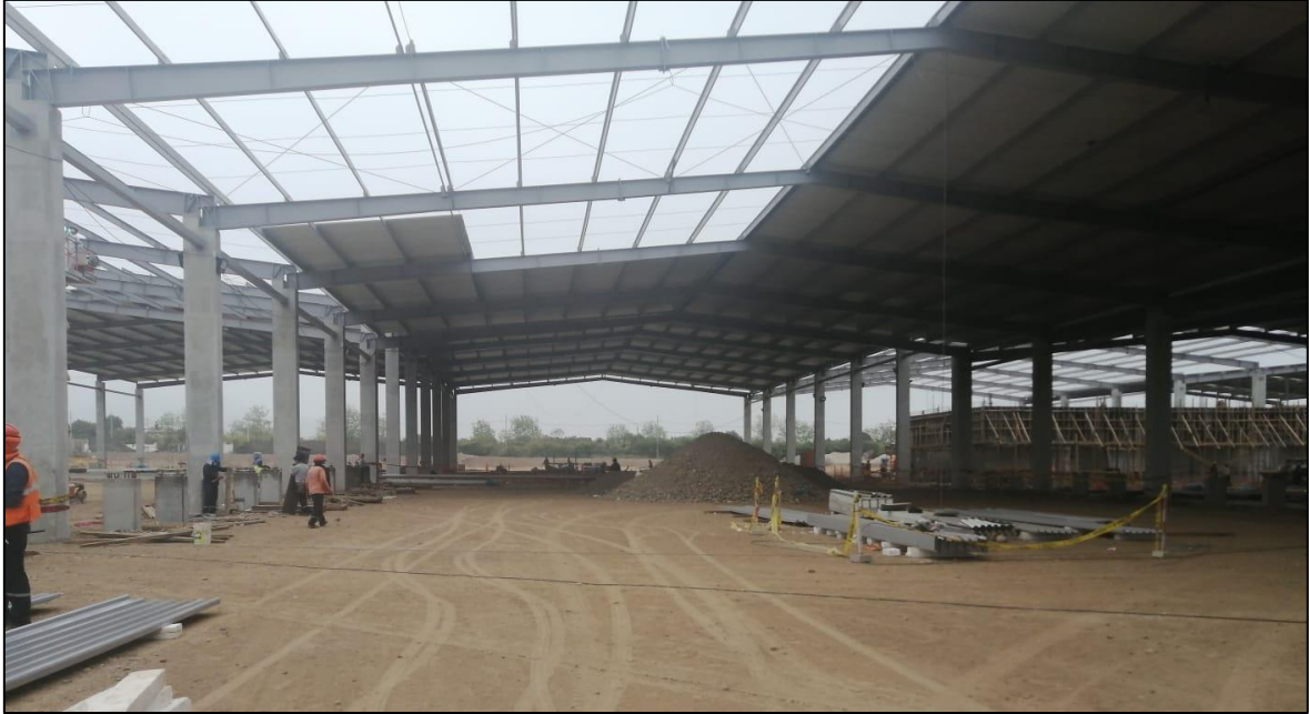
Ilustración 47: Montaje de Cobertura de techo con TR7
