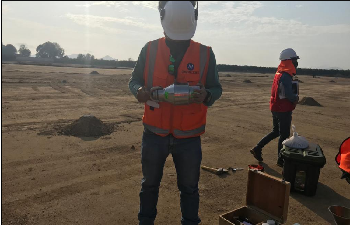
Ilustración 41: Control de calidad en compactación
