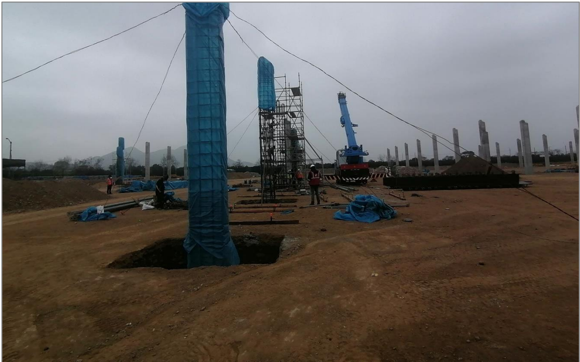
Ilustración 37: Proceso de vaciado de columnas de pórticos
