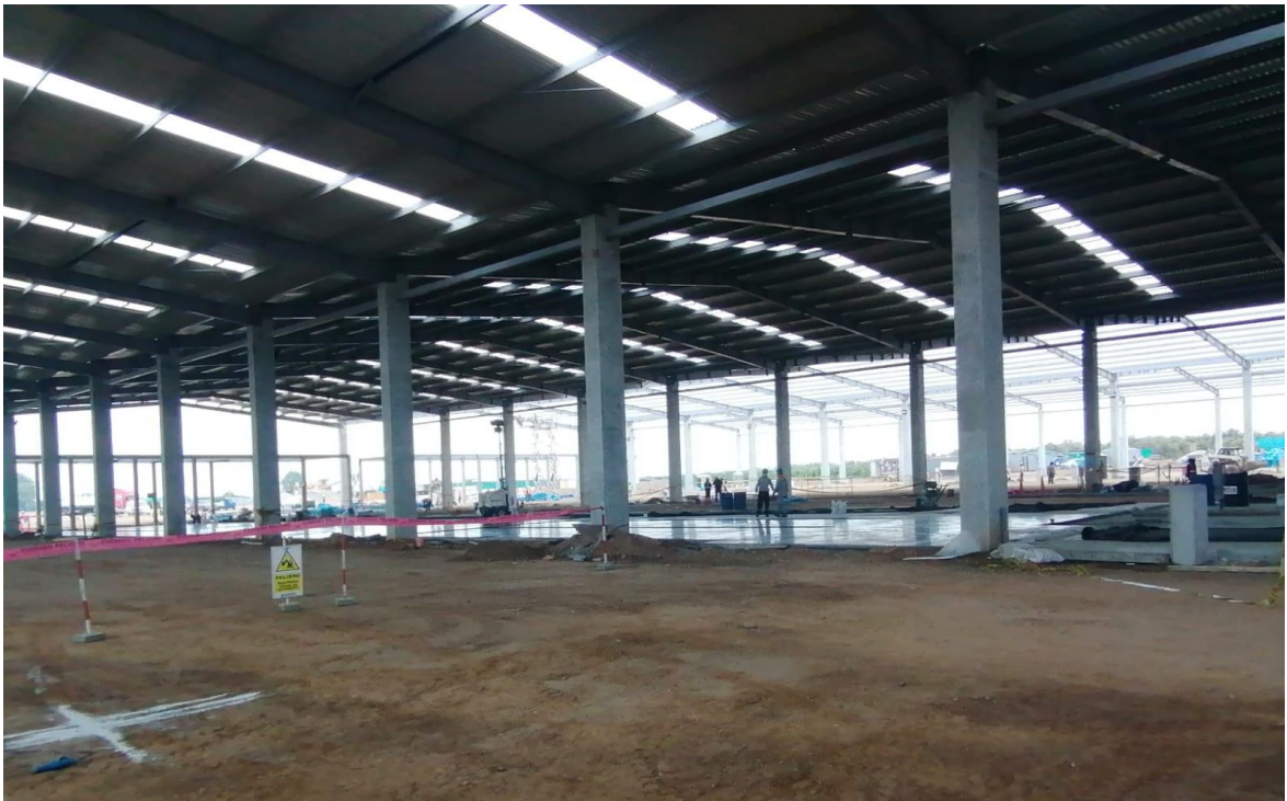
Ilustración 46: Colocación de cobertura traslucida en techo
