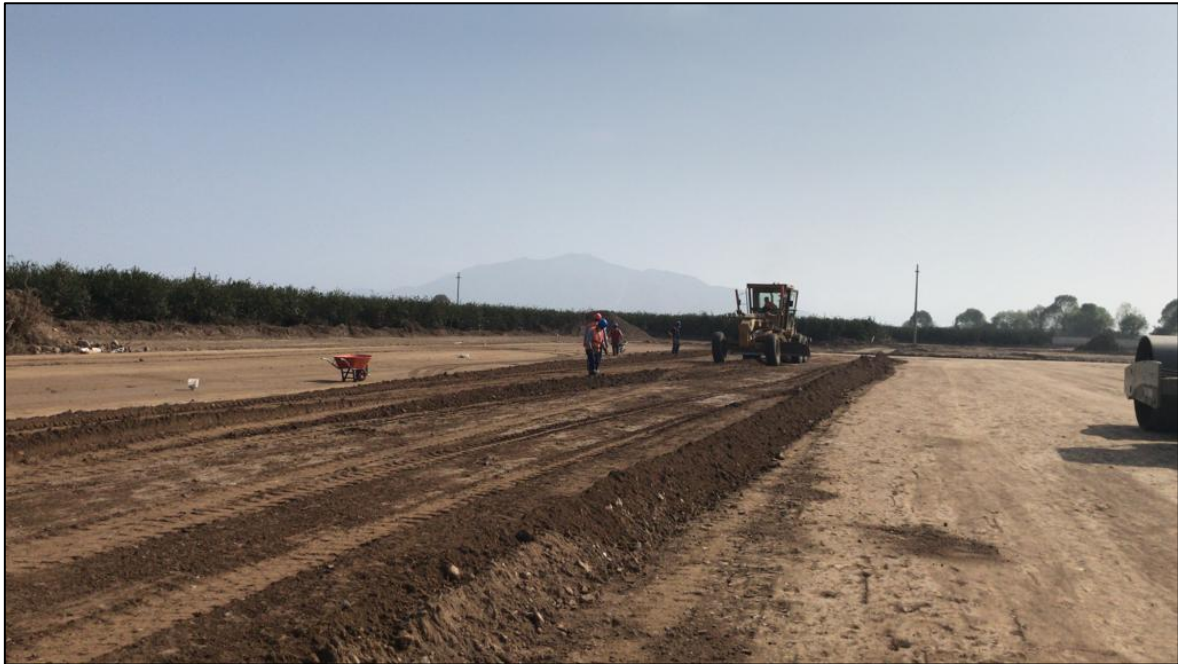
Ilustración 38: Habilitación, Nivelación de capa base
