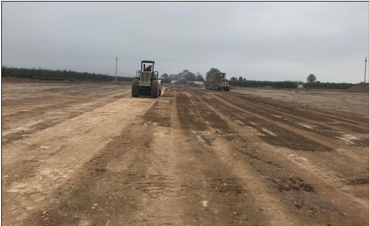
Ilustración 39: Compactación a nivel de base en la zona de la nave industrial
