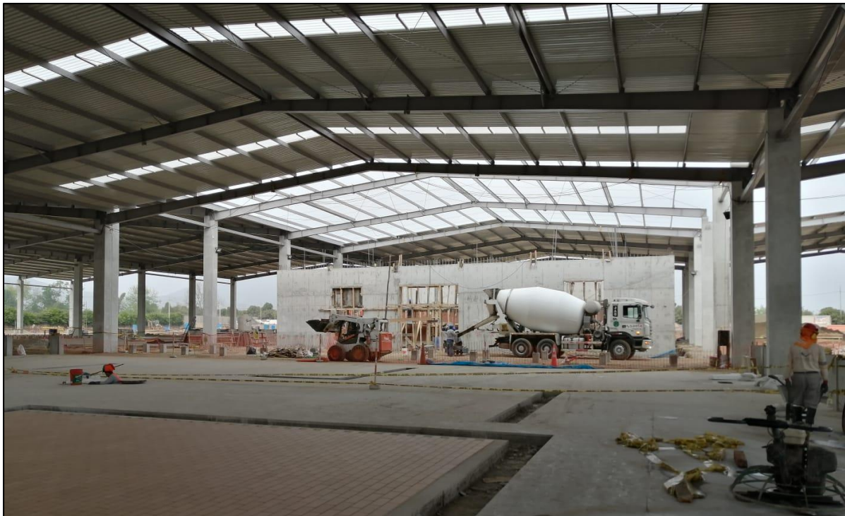
Ilustración 48: Cerramiento con muro corta fuego en zona de calderos
