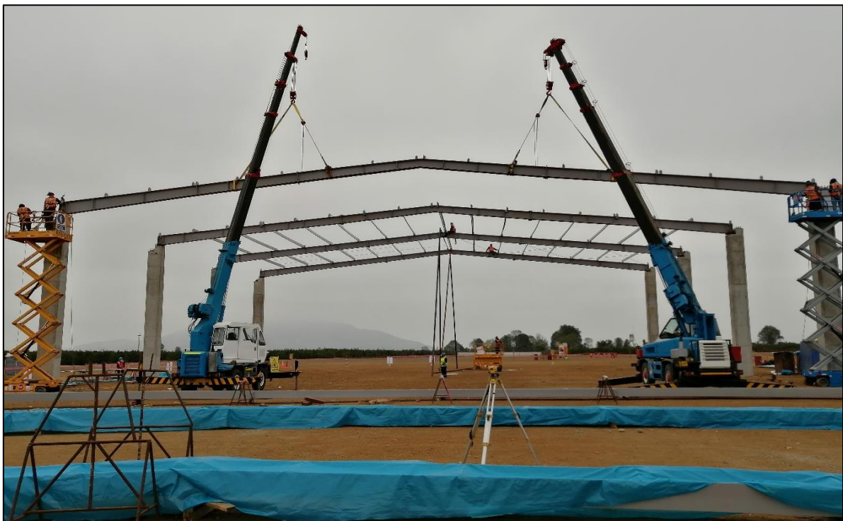
Ilustración 45: Izaje de las primeras vigas de los pórticos principales
