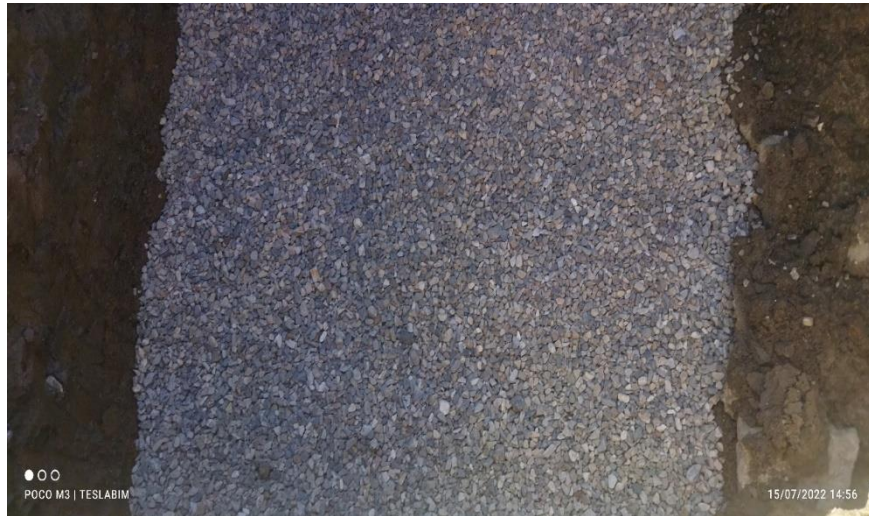
Figura 42. Solado de la Zapata.
