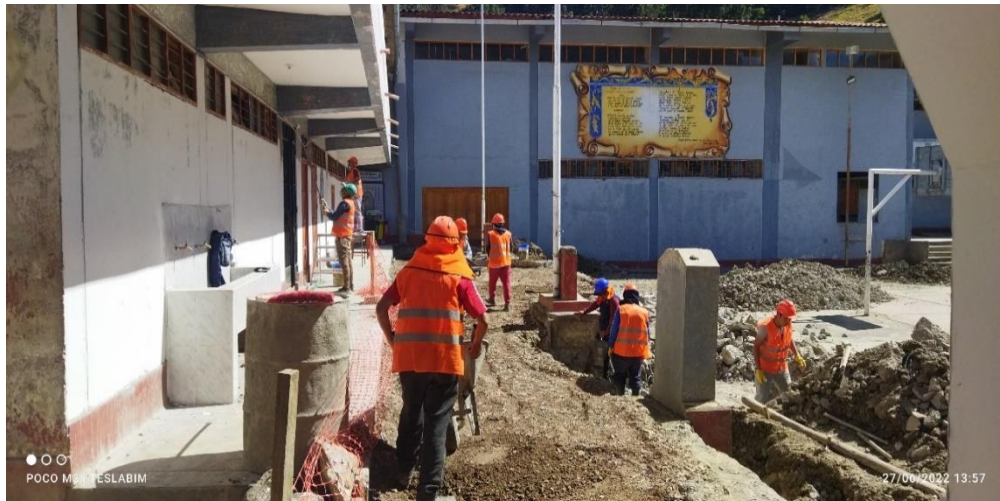
Figura 35. Nivelación y compactación
