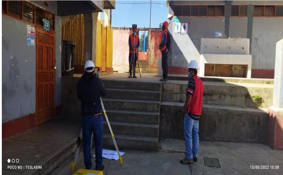
Figura 33. Trazo y replanteo
