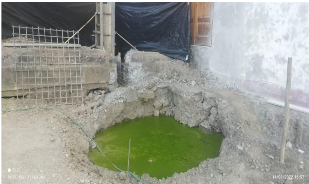
Figura 51. Nivel freático en las zapatas
