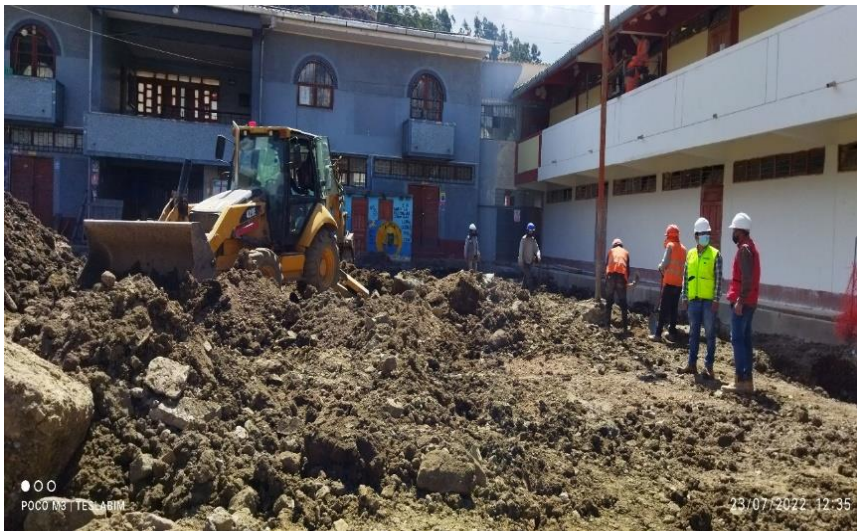
Figura 46. Demolición del patio de formación
