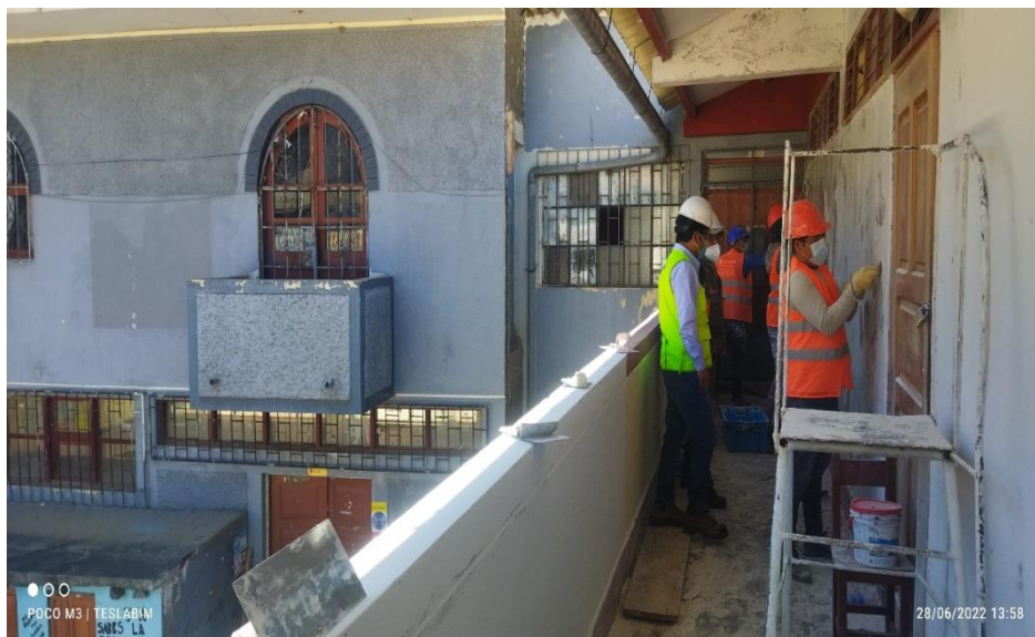
Figura 36. Lijado y empastado de columnas, vigas, muros, cielorraso
