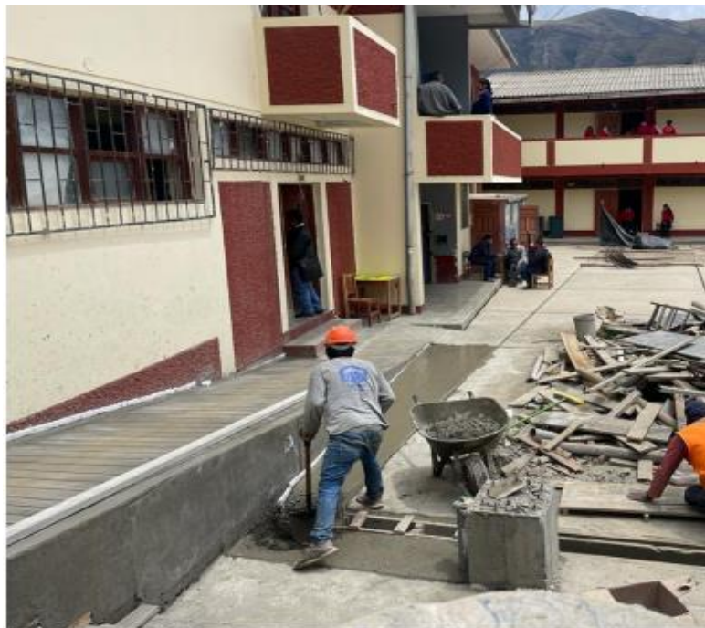
Figura 13. Rampa de la I.E Manuel Gonzalez Prada
