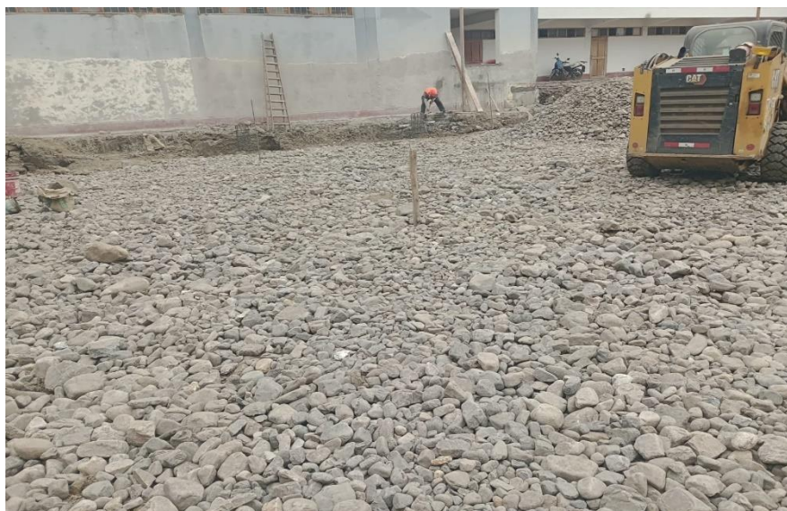
Figura 47. Llenado de sub base granular
