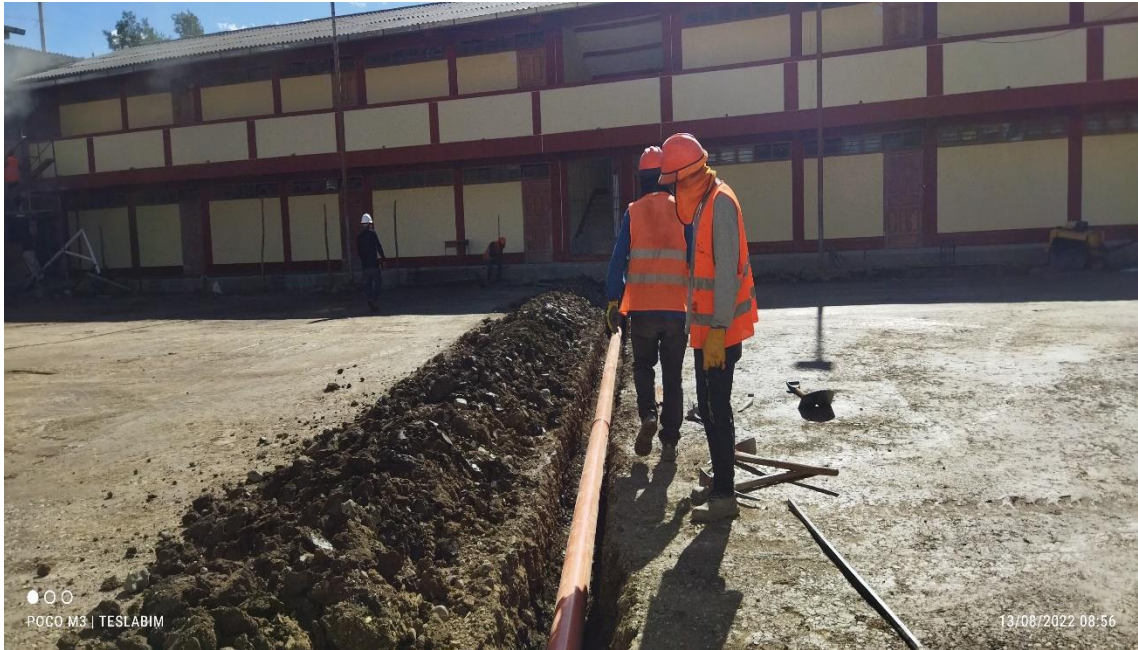
Figura 41. Colocación de tuberías
