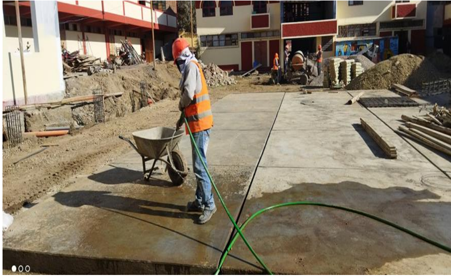
Figura 56. Curado de concreto
