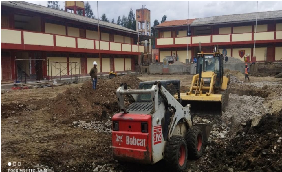
Figura 48. Llenado de afirmado con maquinaria
