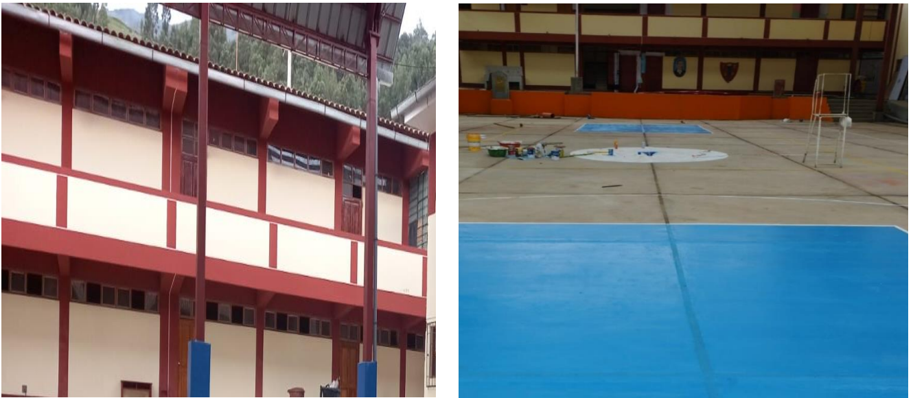
Figura 62. Canaletas cuadradas y pintado de losa deportiva
