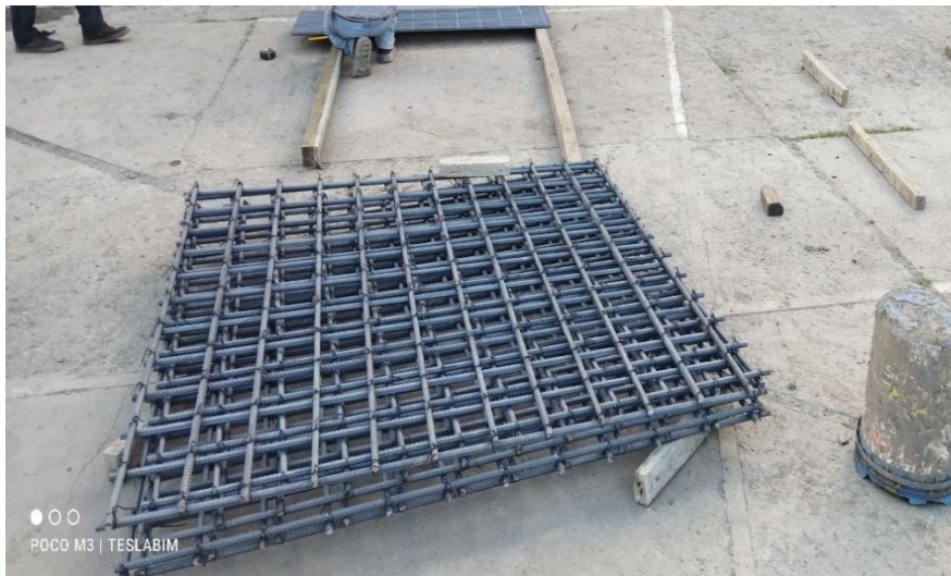
Figura 43. Armado de acero para la zapata
