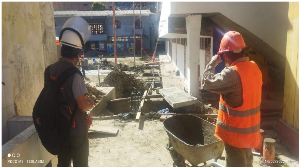
Figura 45. Colocación del concreto para la zapata
