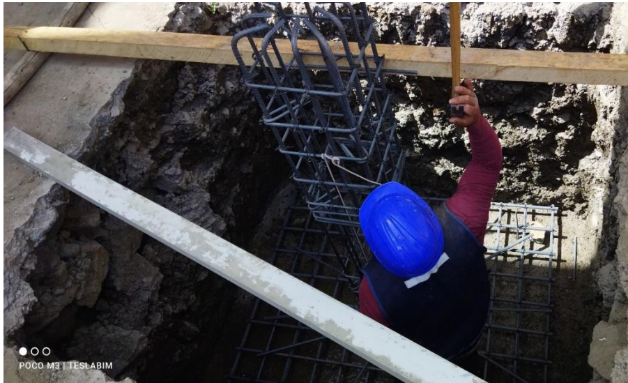
Figura 44. Armado de acero para la zapata
