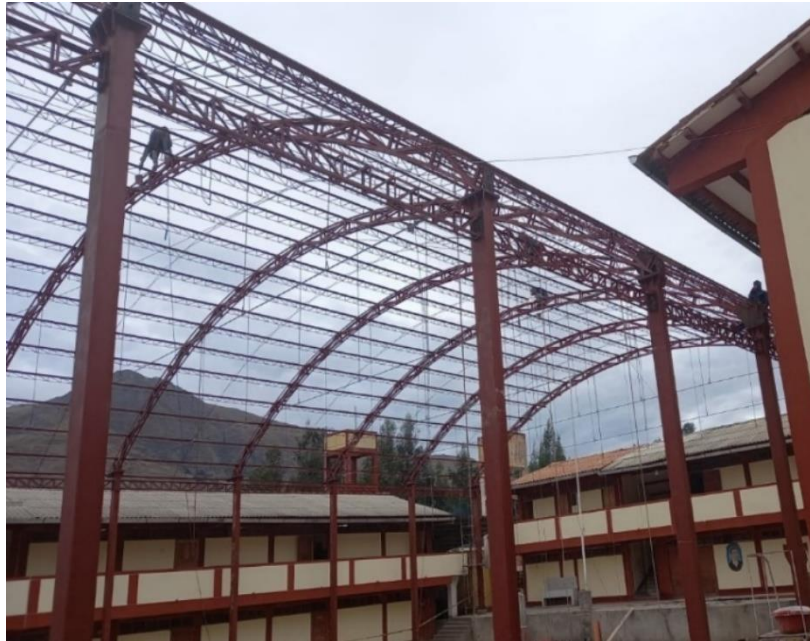
Figura 63. Instalación de aluzin
