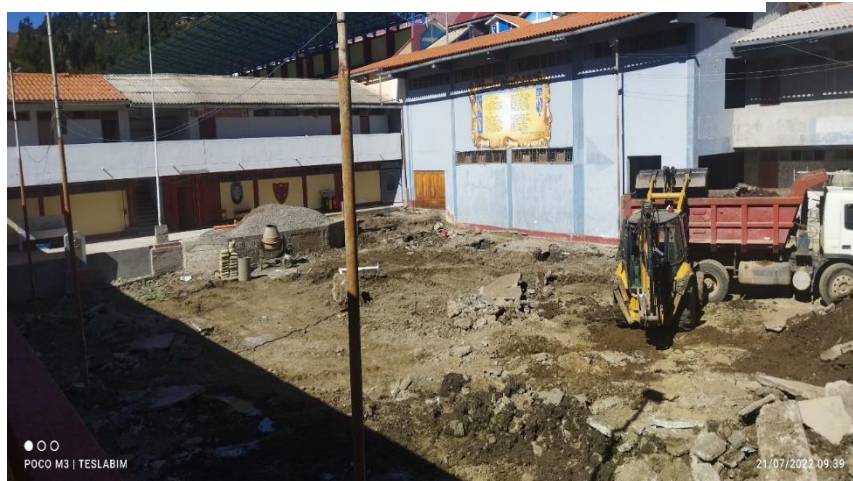
Figura 34. Demolición del escenario
