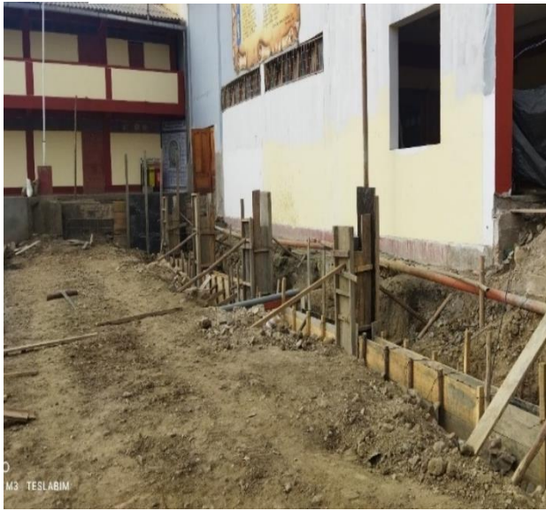
Figura 59. Vigas de cimentación
