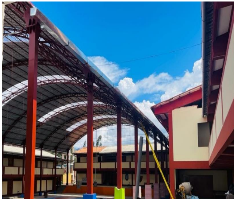
Figura 64 Instalación de aluzin
