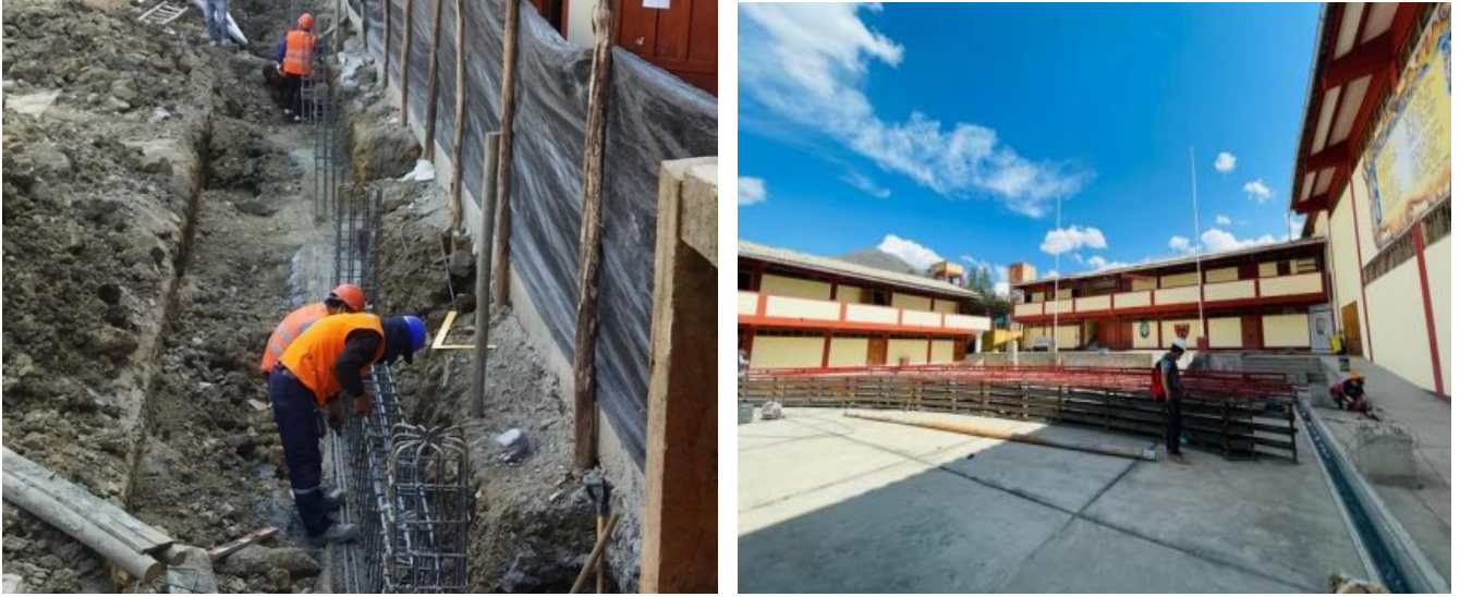
Figura 61. Vigas de cimentación y estructura metálica
