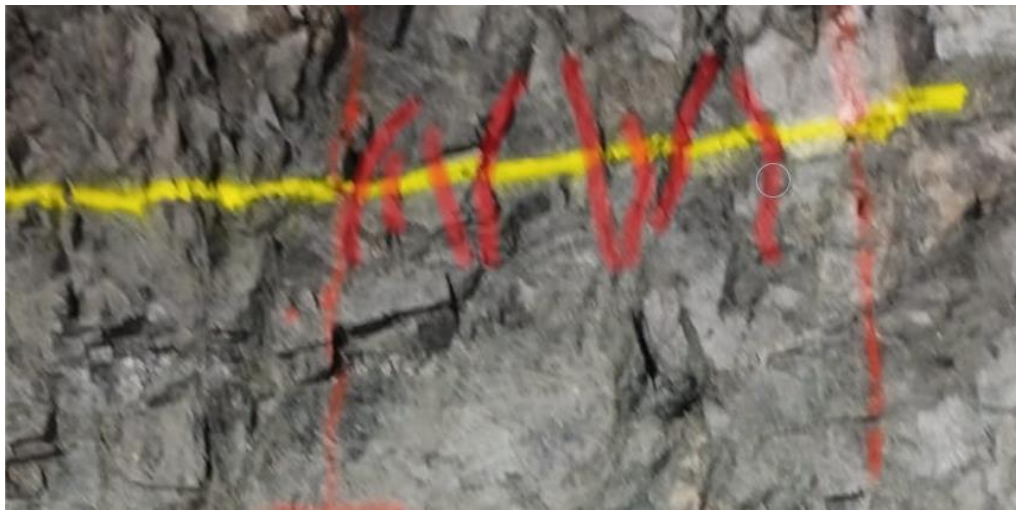
Figura 20: Conteo de fracturas por metro lineal. Para este caso se identificaron 8 fracturas por metro Fuente: Propia
