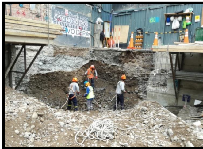
Fuente: Fotografía tomada en obra de Marsano 2175
