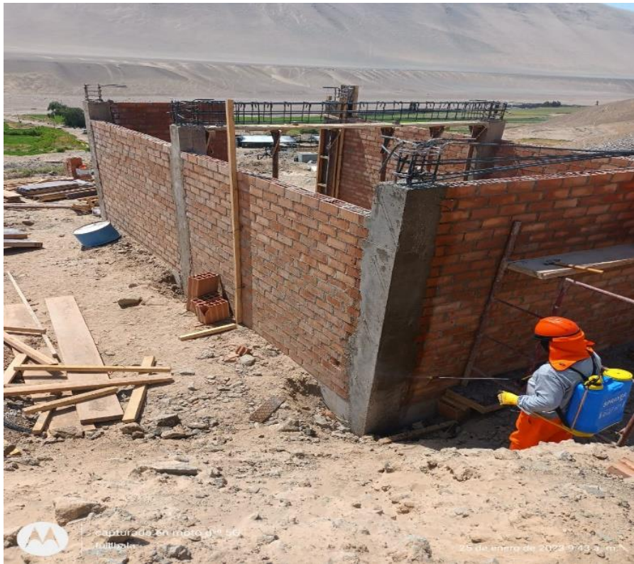
Figura 35 Curado de concreto con aditivo.
