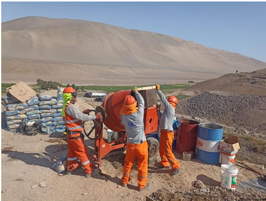
Figura 19 Elaboración de concreto 1:10 + 30 PG - Caseta de filtrado R - A3.
