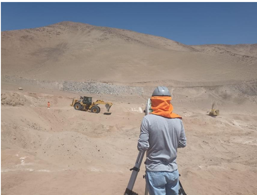
Figura 15 Excavación en terreno gravoso con maquinaria R - C.
