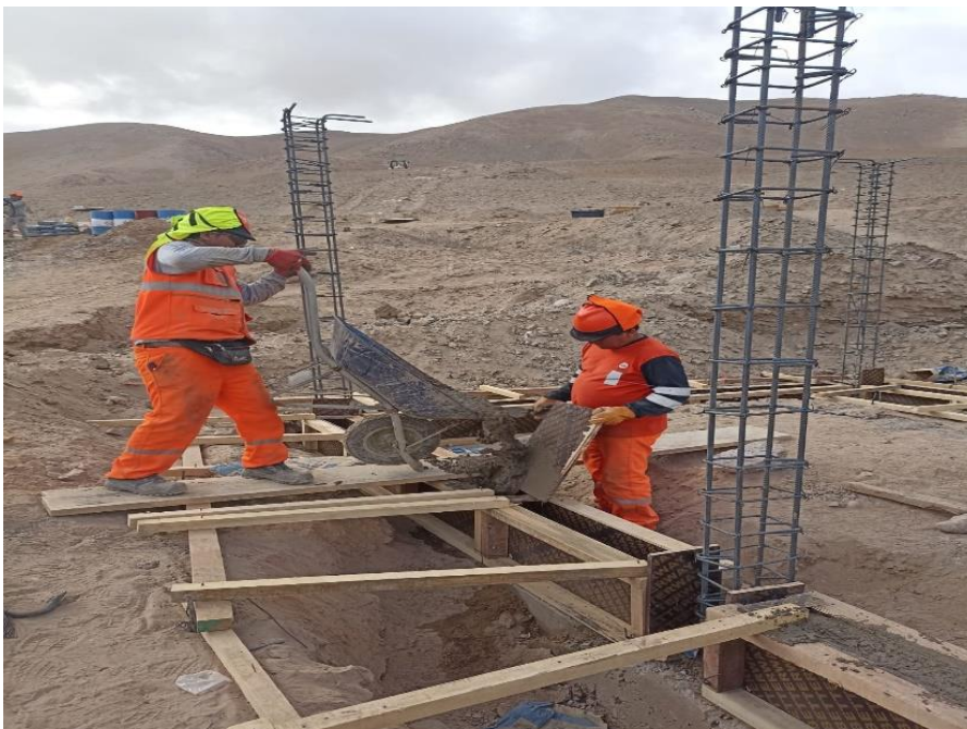
Figura 29 Colocación de concreto F_c=175 \text{ kg/cm}^2 para sobrecimiento.
