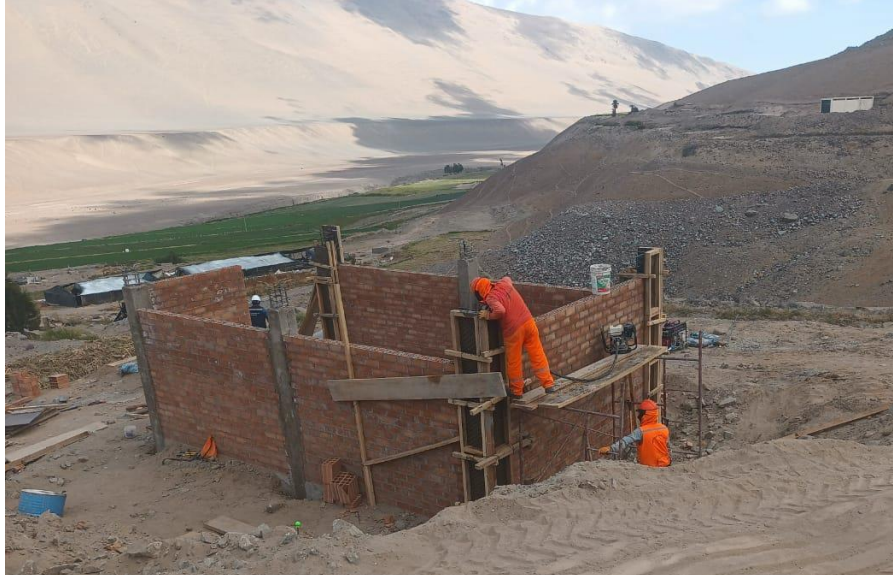
Figura 34 Muro de ladrillo king kong acabado.
