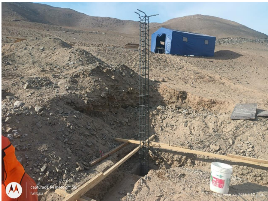
Figura 23 Colocación de acero estructural para columnas.
