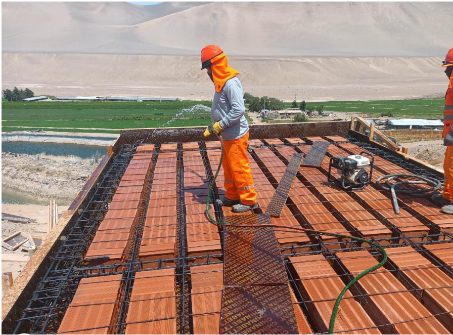
Figura 39 Losa aligerada de caseta de filtrado R-A3.
