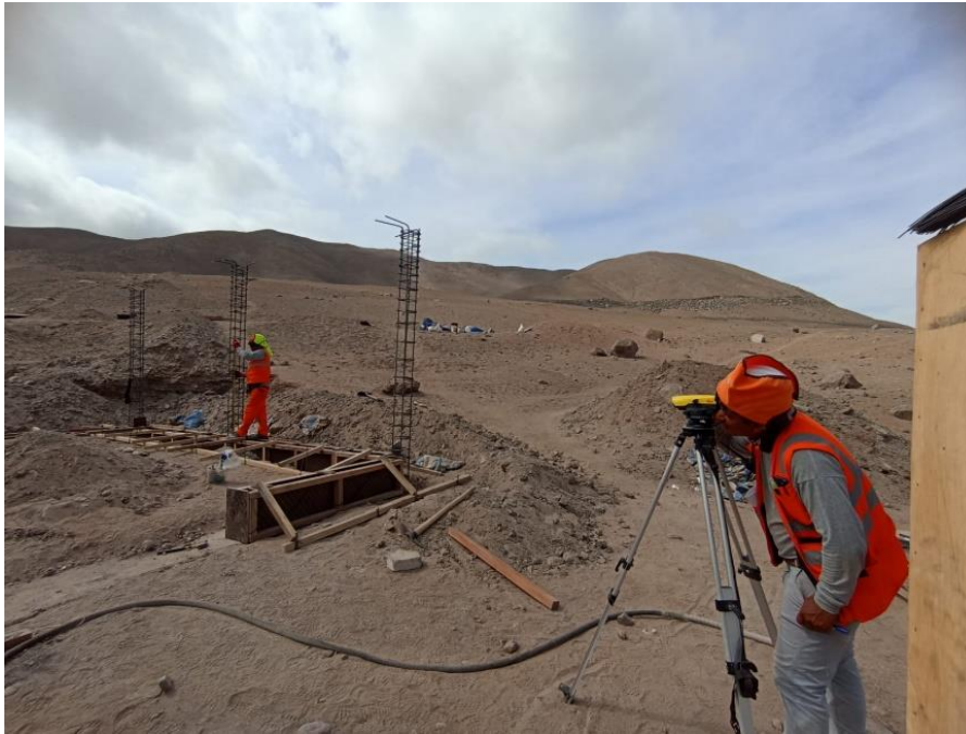
Figura 28 Control de niveles durante ejecución de sobrecimiento.
