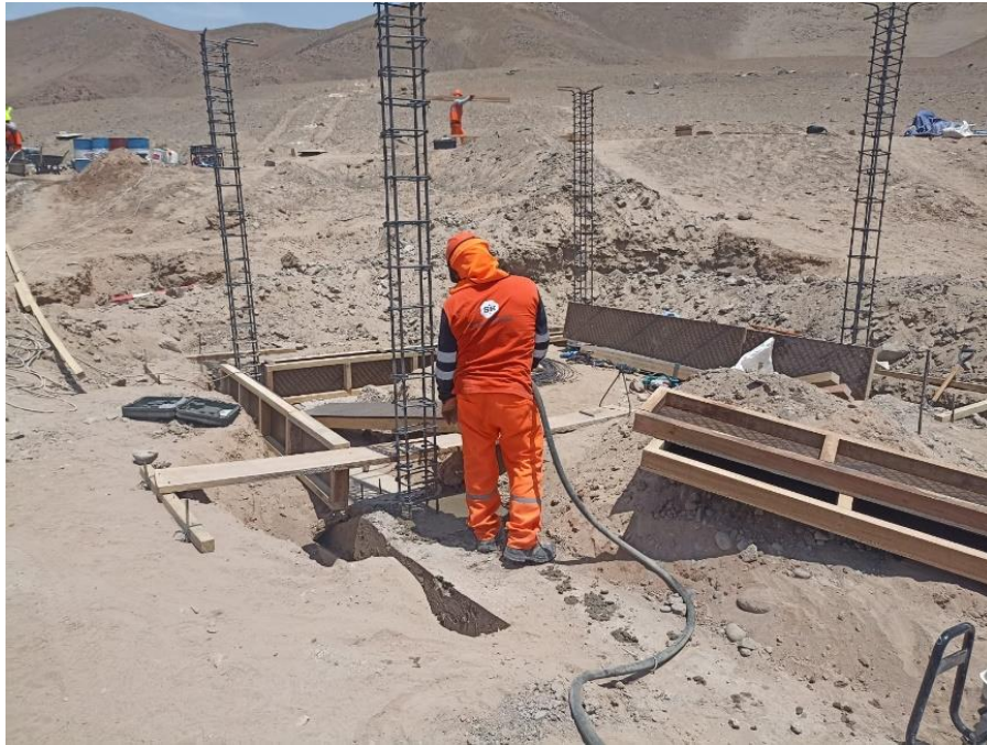
Figura 30 Vibrado de concreto en sobrecimiento.
