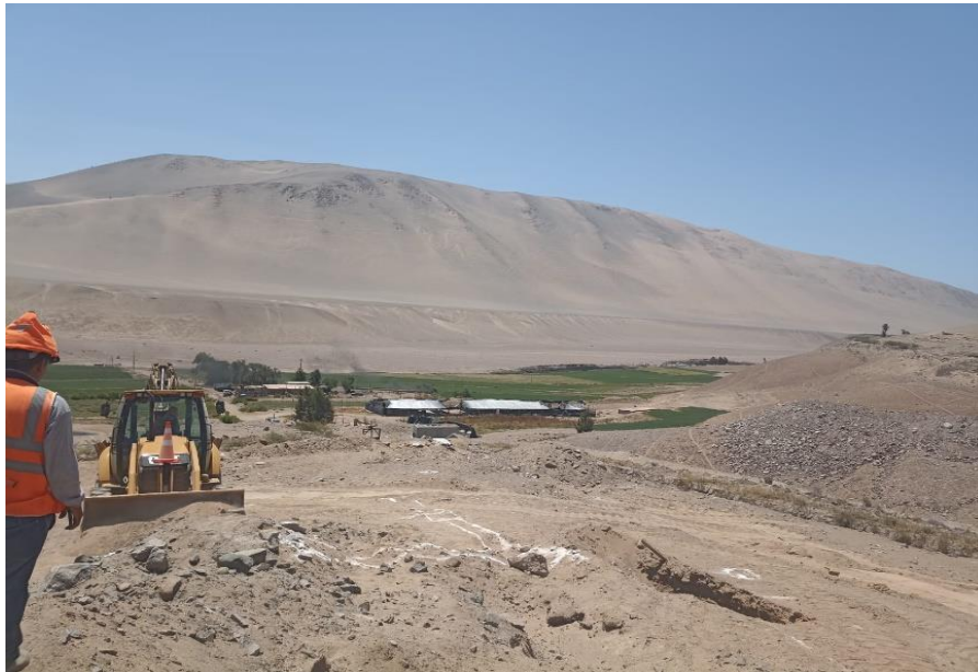
Figura 12 Limpieza de terreno con maquinaria - Caseta de filtrado A3.
