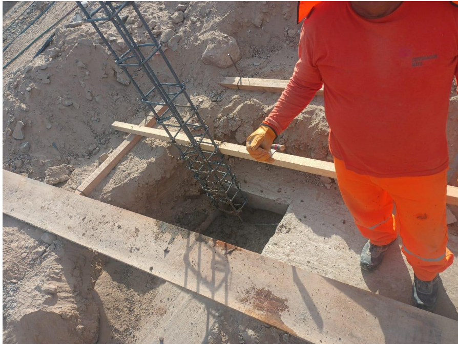
Figura 26 Colocación de concreto F'c = 210 \text{ kg/cm}^2 en zapata.
