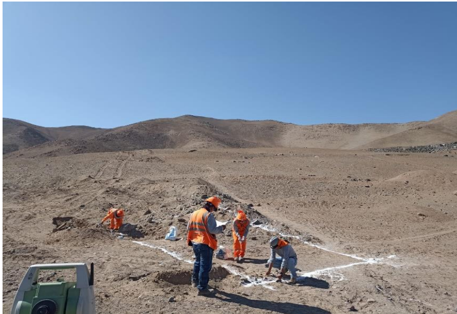
Figura 11 Ejecución de partida trazo, niveles y replanteo preliminar.
