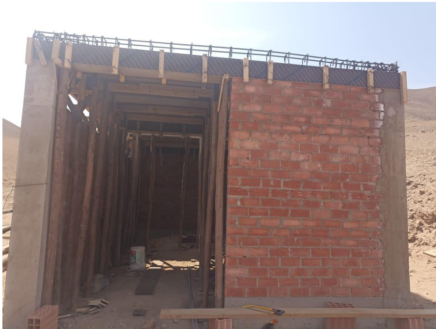
Figura 38 Losa Aligerada de Caseta de filtrado R-A3.
