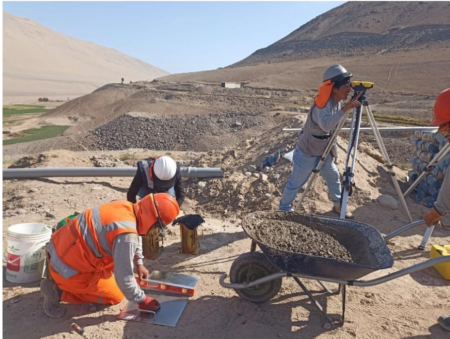
Figura 20 Control topográfico durante la ejecución.
