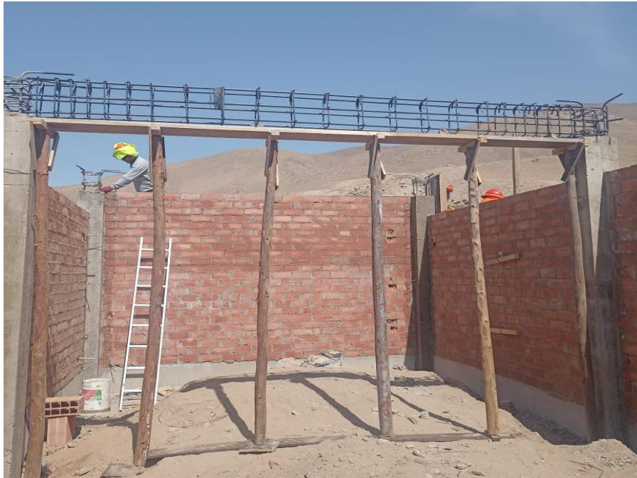
Figura 37 Colocación de acero estructural para viga.
