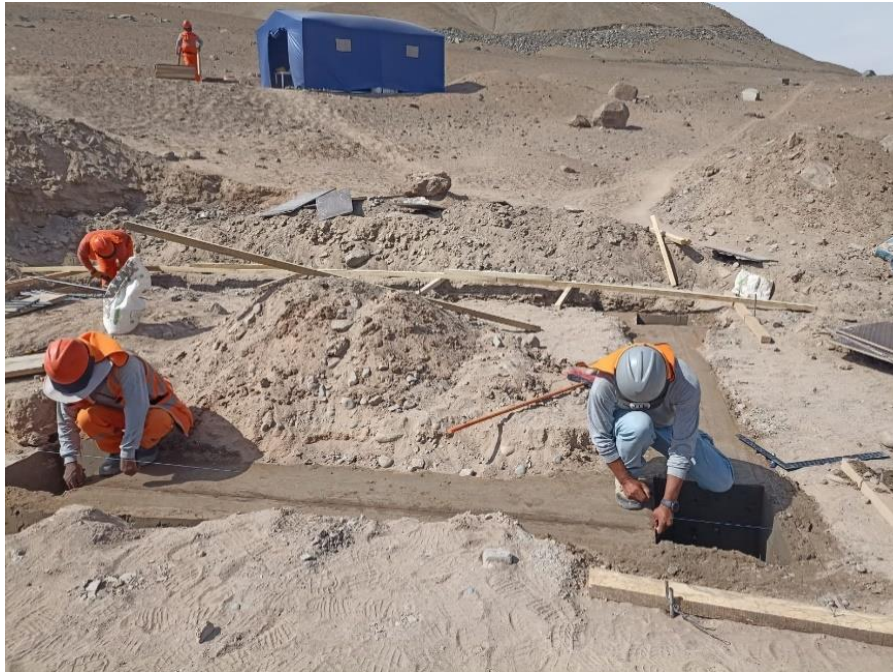
Figura 22 Trazo durante la ejecución para colocación de acero para columnas.
