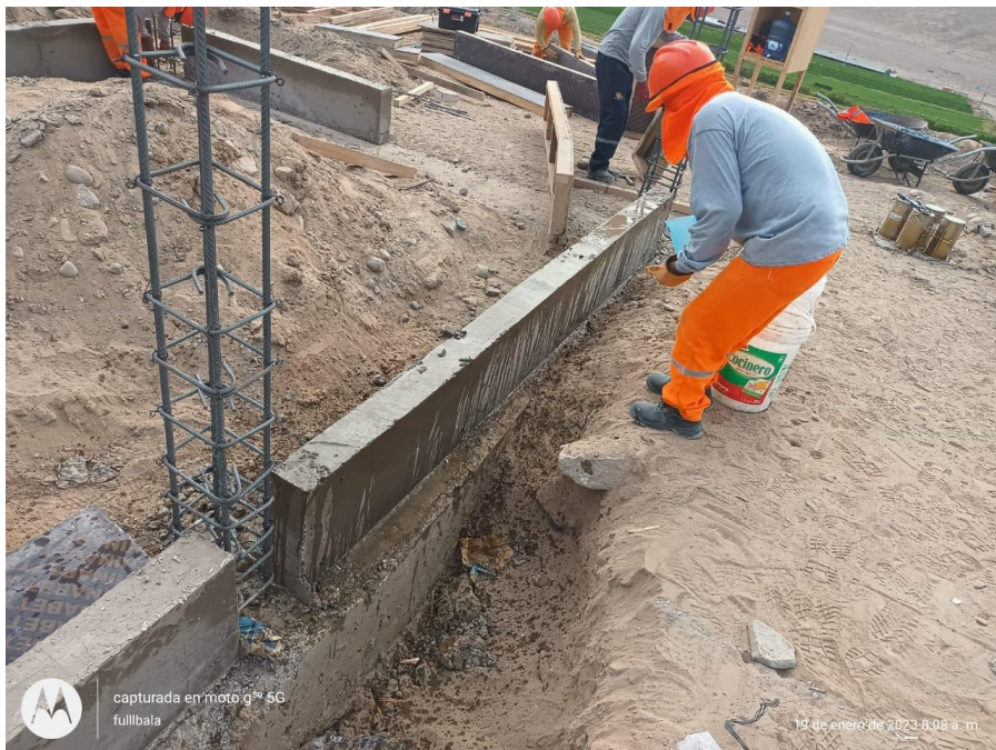
Figura 31 Curado de concreto posterior al desencofrado.
