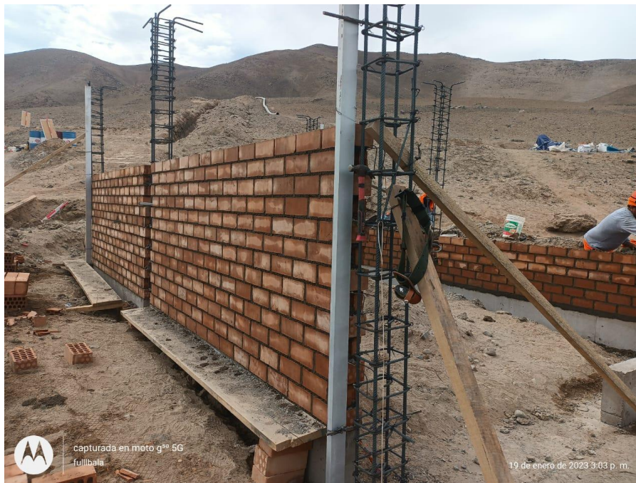
Figura 32 Asentado de ladrillo king kong.
